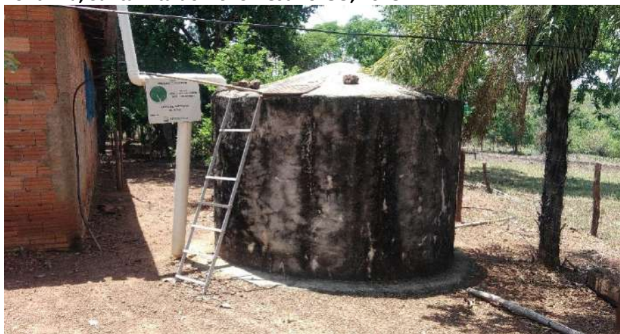
Foto 6.5 – Cisterna para armazenamento da água de chuva e do poço tubular, na Comunidade Engenho da Pontinha, Santa Rita do Novo Destino-GO, 2018.
