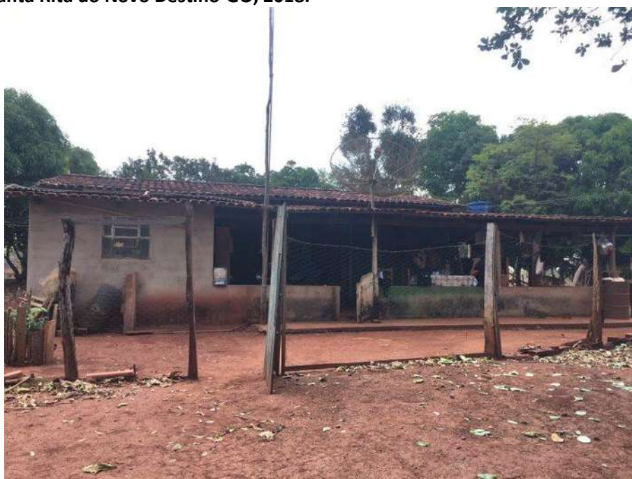
Foto 4.2 – Habitação construída de alvenaria com reboco, identificada na Comunidade Engenho da Pontinha, Santa Rita do Novo Destino-GO, 2018.
