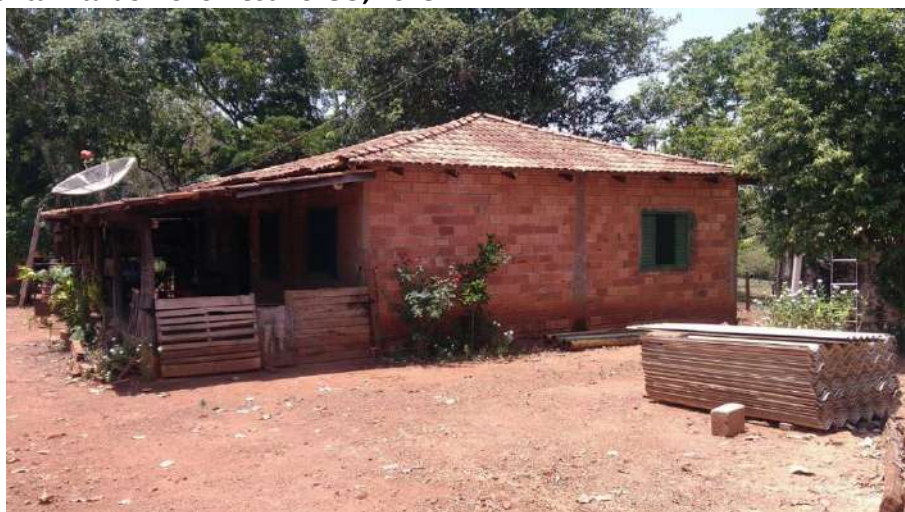
Foto 4.3 – Habitação construída de alvenaria sem reboco, identificada na Comunidade Engenho da Pontinha, Santa Rita do Novo Destino-GO, 2018.
