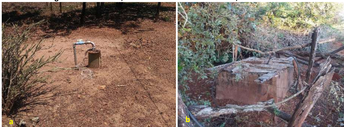
Foto 6.1 – Poço tubular profundo (a) e poço raso escavado (b) utilizados por domicílios da Comunidade Engenho da Pontinha, Santa Rita do Novo Destino-GO, 2018.
