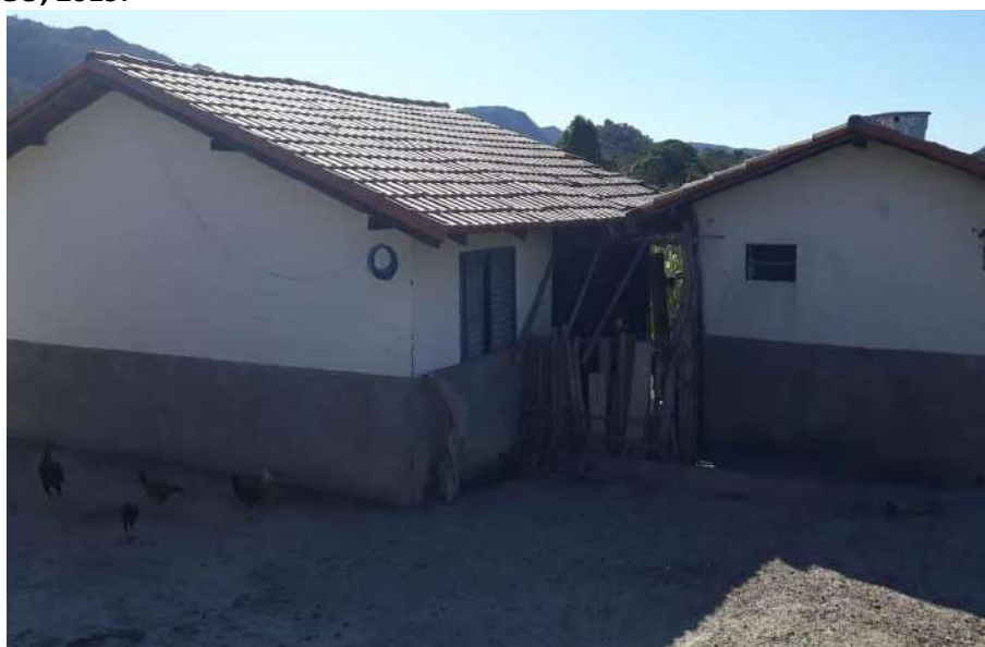
Foto 4.13 – Cobertura de telha de barro, identificada nas habitações da Comunidade Engenho 2, Cavalcante-GO, 2019.
