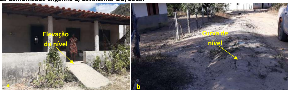
Foto 6.21 – Dispositivos de prevenção dos danos provocados pelas águas em residência (a) e lote (b) da Comunidade Engenho 2, Cavalcante-GO, 2019.
