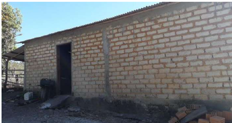
Foto 4.9 – Habitação construída de adobe, identificada na Comunidade Engenho 2, Cavalcante-GO, 2019.
