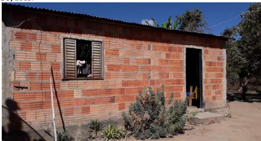
Foto 4.10 – Habitação construída de alvenaria sem reboco, identificada na Comunidade Engenho 2, Cavalcante-GO, 2019.
