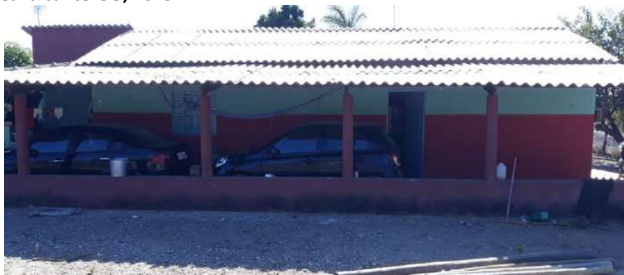
Foto 4.12 – Habitação construída de alvenaria com reboco e pintura, identificada na Comunidade Engenho 2, Cavalcante-GO, 2019.
