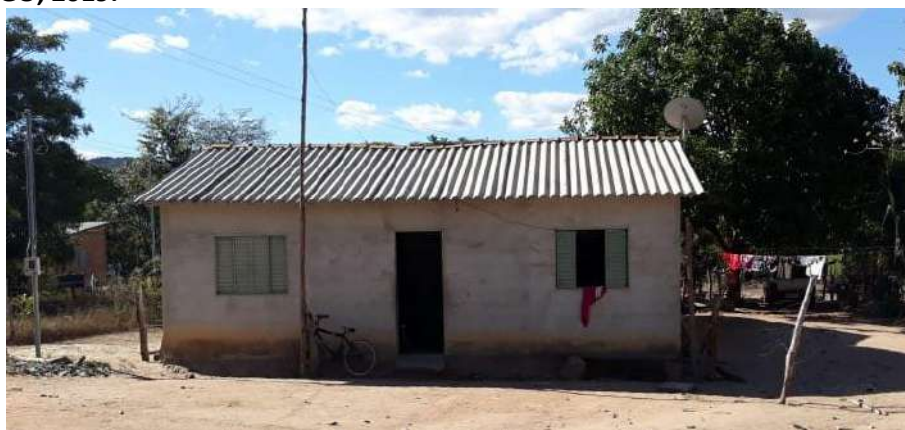
Foto 4.11 – Habitação construída de alvenaria e reboco, identificada na Comunidade Engenho 2, Cavalcante-GO, 2019.
