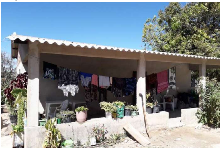
Foto 4.14 – Cobertura de telha de fibrocimento, identificada nas habitações da Comunidade Engenho 2, Cavalcante-GO, 2019.
