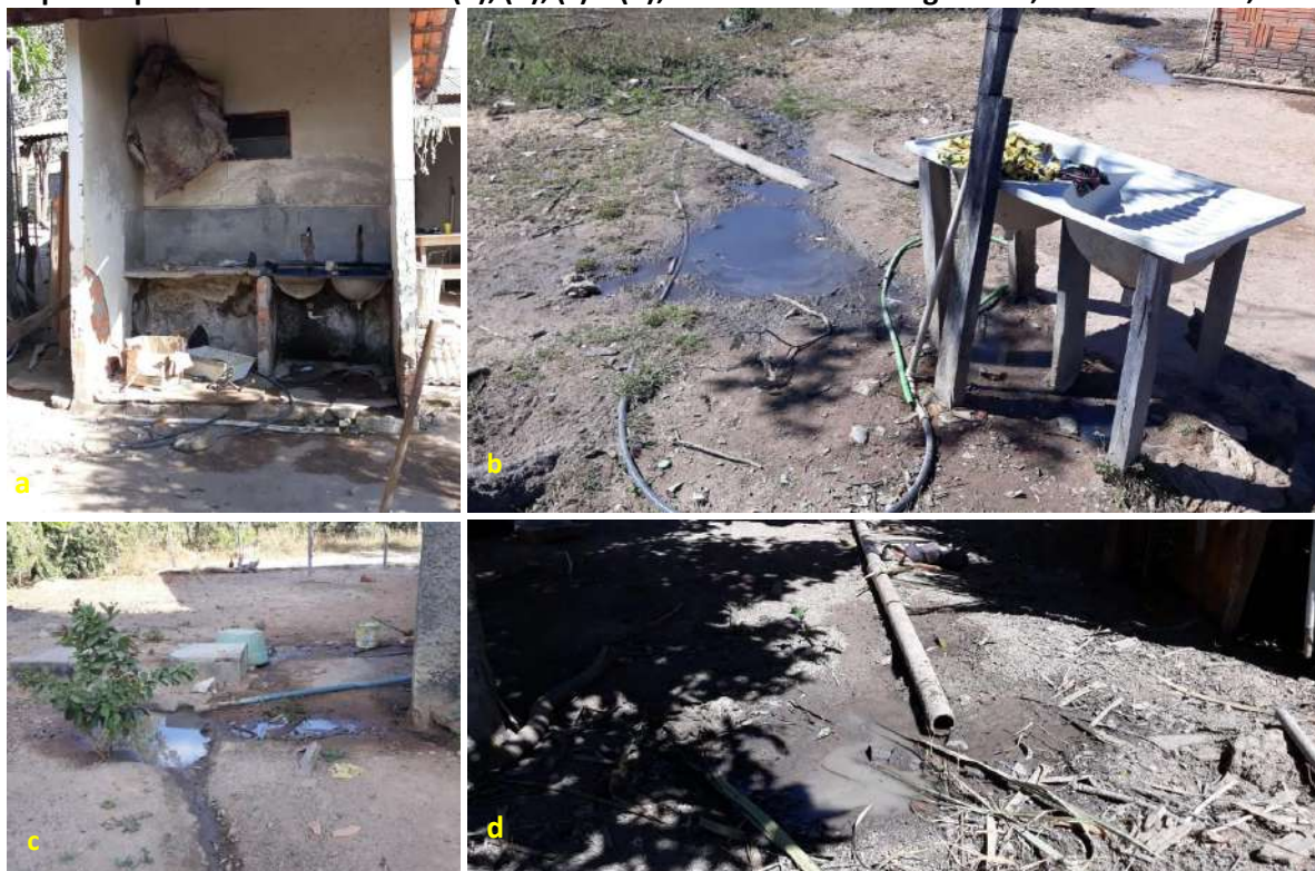
Foto 6.8 – Lançamento e acúmulo de água cinza proveniente da pia da cozinha diretamente no solo do quintal próximo aos domicílios (a), (b), (c) e (d), na Comunidade Engenho 2, Cavalcante-GO, 2019.
