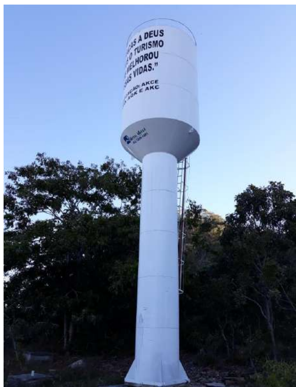
Foto 6.2 – Reservatório coletivo tipo taça, construído em material metálico, na Comunidade Engenho 2, Cavalcante-GO, 2019.
