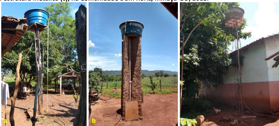
Foto 6.5 – Reservatórios domiciliares instalados sobre estrutura: em madeira (a), em alvenaria (b) e em estrutura metálica (c), na Comunidade Dom Roriz, Minaçu-GO, 2018.
