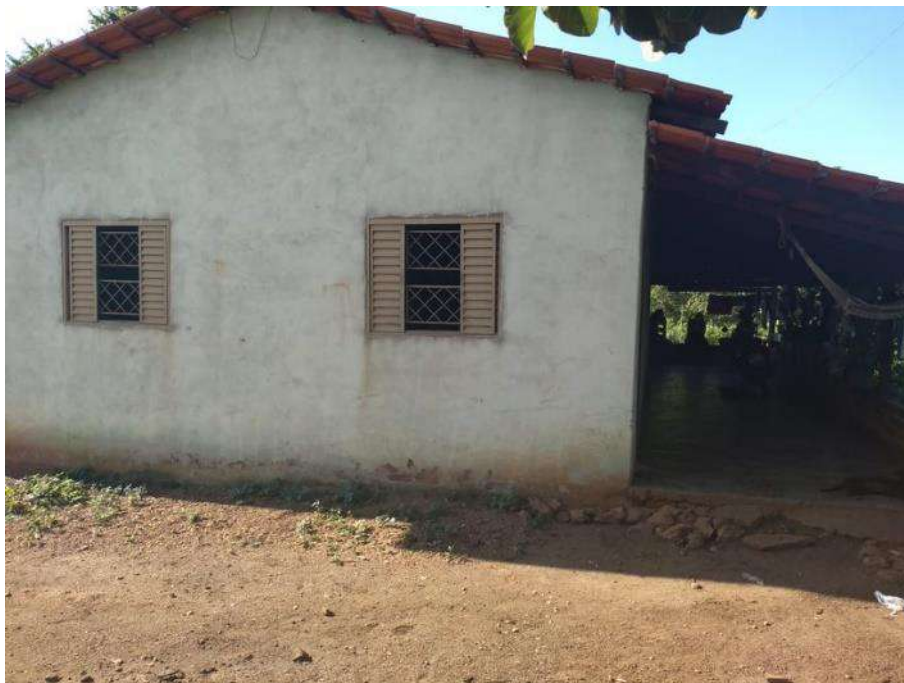
Foto 4.2 – Habitação construída de alvenaria com reboco, identificada na Comunidade Dom Roriz, Minaçu-GO, 2018.
