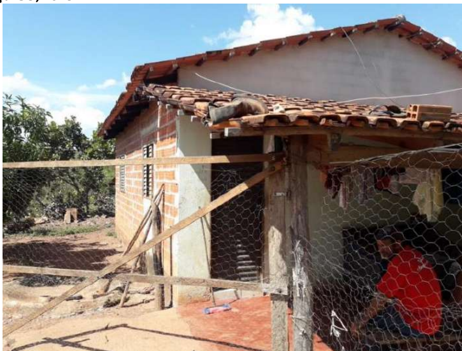
Foto 4.1 – Habitação construída de alvenaria com e sem reboco, identificada na Comunidade Dom Roriz, Minaçu-GO, 2018.
