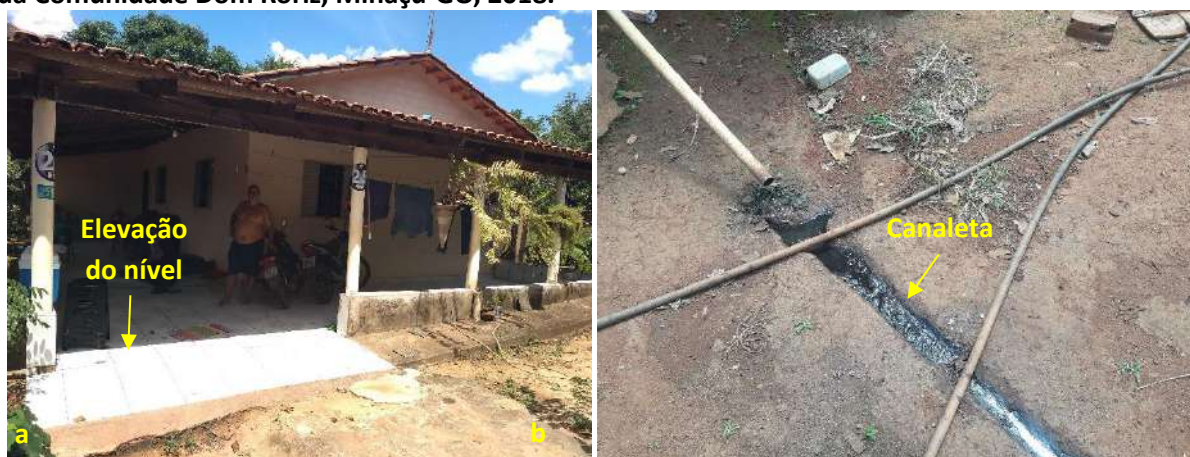
Foto 6.22 – Dispositivos de prevenção dos danos provocados pelas águas em residência (a) e lote (b) da Comunidade Dom Roriz, Minaçu-GO, 2018.
