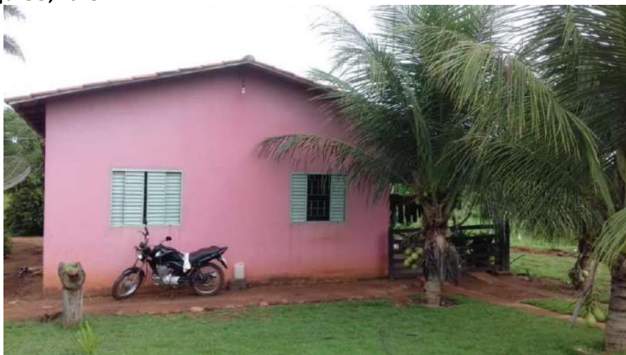
Foto 4.3 – Habitação construída de alvenaria com reboco e pintura, identificada na Comunidade Dom Roriz, Minaçu-GO, 2018.
