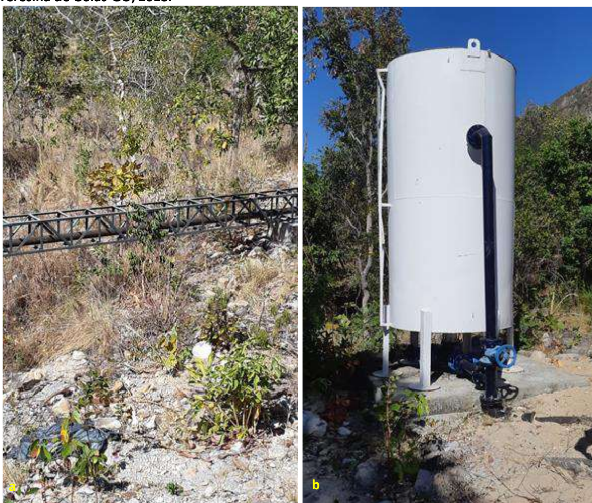
Foto 6.3 – Adutora de água bruta (a) e filtro (b) pertencentes ao SAA da Comunidade Diadema, Teresina de Goiás-GO, 2018.
