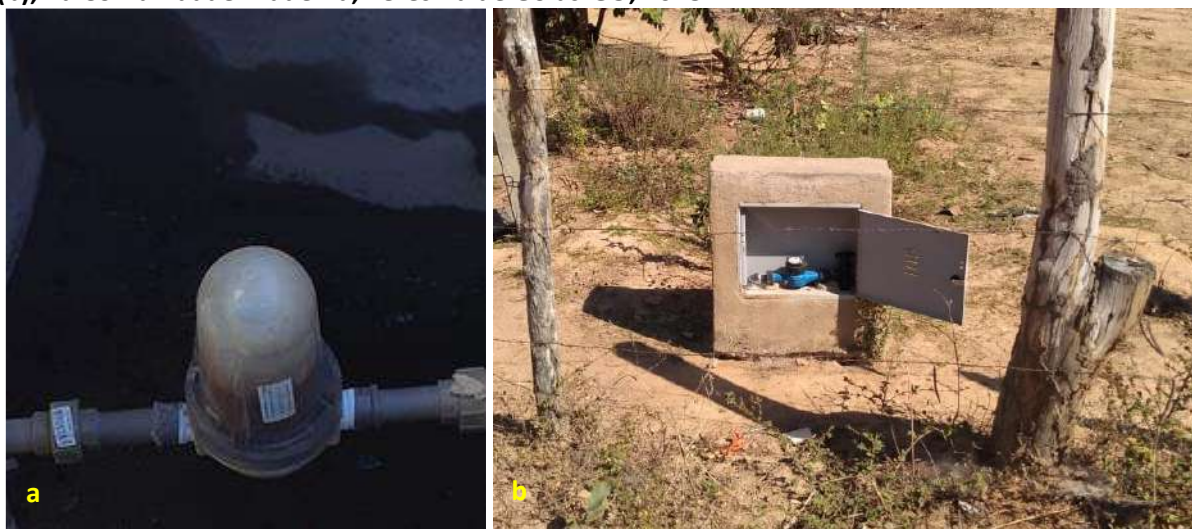
Foto 6.5 – Dispositivos na rede do SAA utilizados para desinfecção (a) e medição da vazão domiciliar (b), na Comunidade Diadema, Teresina de Goiás-GO, 2018.
