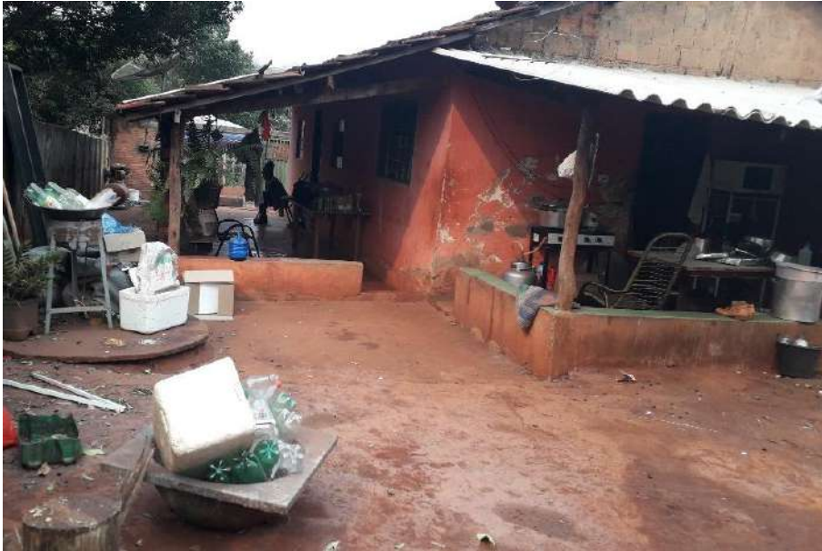
Foto 4.30 – Telhado misto composto, em parte, por telhas de fibrocimento e, em parte, por telhas de barro identificado na Comunidade Córrego do Inhambu, Cachoeira Dourada-GO, 2019.
