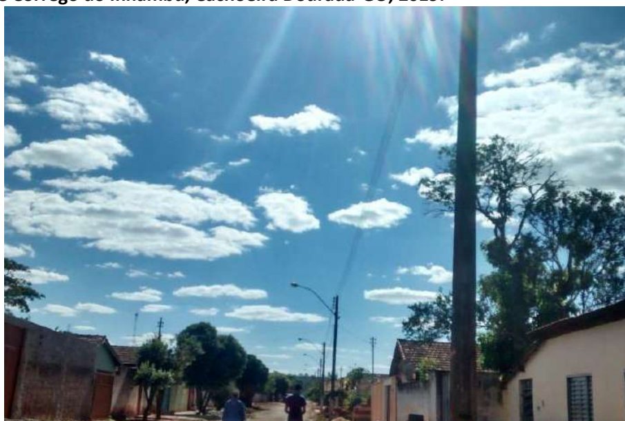
Foto 4.23 – Iluminação pública do povoado Nilópolis, identificada durante o checklist na Comunidade Córrego do Inhambú, Cachoeira Dourada-GO, 2019.
