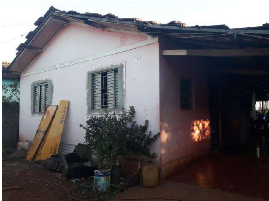
Foto 4.28 – Piso de cimento queimado identificado na Comunidade Córrego do Inhambú, Cachoeira Dourada-GO, 2019.
