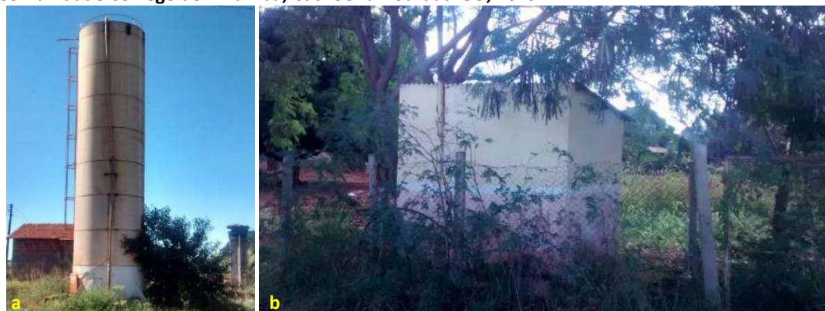
Foto 6.5 – Sistema de abastecimento do distrito Almerindonópolis, composto por reservatório apoiado R1 (a) e abrigo do sistema elétrico de recalque com estrutura de alvenaria do R1 (b), Comunidade Córrego do Inhambú, Cachoeira Dourada-GO, 2019.
