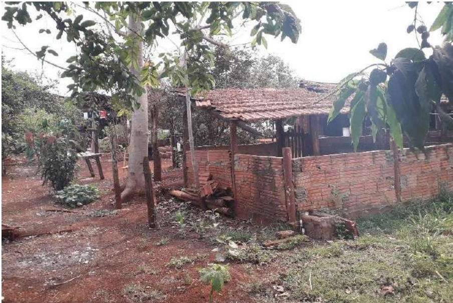
Foto 4.31 – Telhado composto por telhas de barro identificado na Comunidade Córrego do Inhambu, Cachoeira Dourada-GO, 2019.
