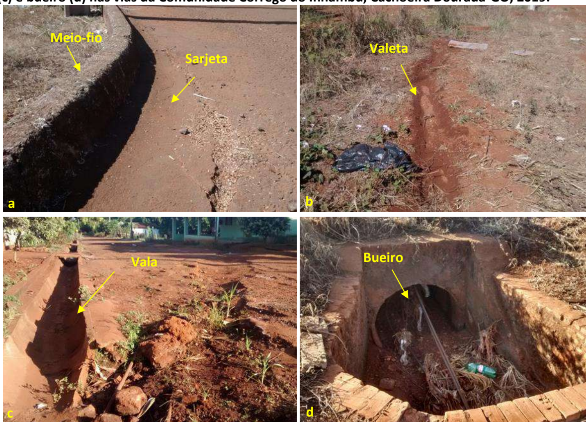
Foto 6.27 – Situação da drenagem pluvial na via de acesso: meio-fio com sarjeta (a), valeta (b), vala (c) e bueiro (d) nas vias da Comunidade Córrego do Inhambú, Cachoeira Dourada-GO, 2019.
