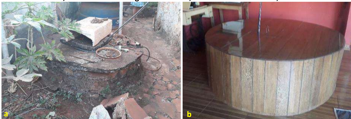
Foto 6.9 – Poço raso escavado com mecanismos de proteção feitos de concreto (a) e revestido por material cerâmico, Comunidade Córrego do Inhabú, Cachoeira Dourada-GO, 2019.
