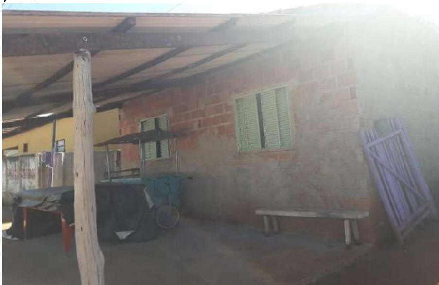
Foto 4.29 – Piso de concreto bruto identificado na Comunidade Córrego do Inhambú, Cachoeira Dourada-GO, 2019.
