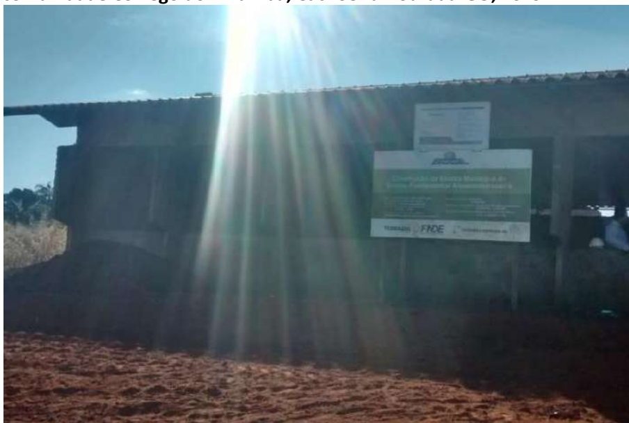
Foto 4.3 – Escola municipal em construção do povoado Almerindonópolis, identificada durante o checklist da comunidade Córrego do Inhambú, Cachoeira Dourada-GO, 2019.
