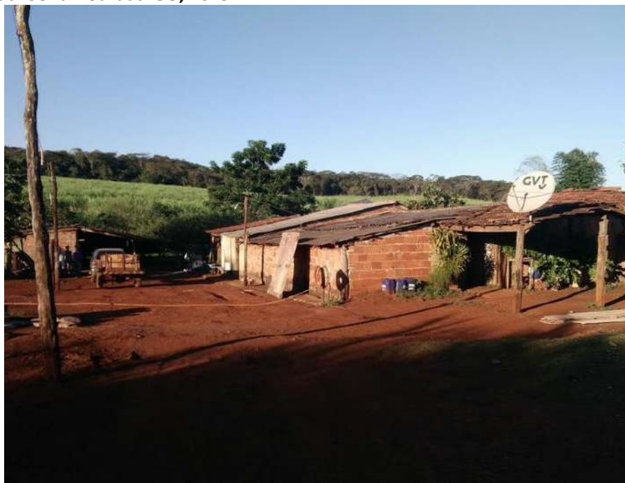
Foto 4.25 – Habitação construída de alvenaria sem reboco, identificada na Comunidade Córrego do Inhambú, Cachoeira Dourada-GO, 2019.
