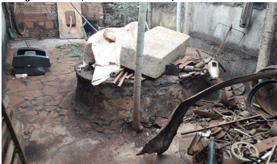
Foto 6.10 – Poço raso escavado com estruturas de proteção danificadas e acúmulo de resíduos, Comunidade Córrego do Inhambú, Cachoeira Dourada-GO, 2019.
