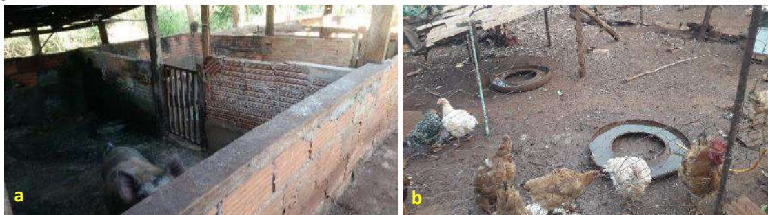
Foto 6.19 – Exemplos da presença de chiqueiro com a impermeabilização do solo (a) e galinheiro sem impermeabilização do solo (b) na Comunidade Córrego do Inhambú, Cachoeira Dourada-GO, 2019.
