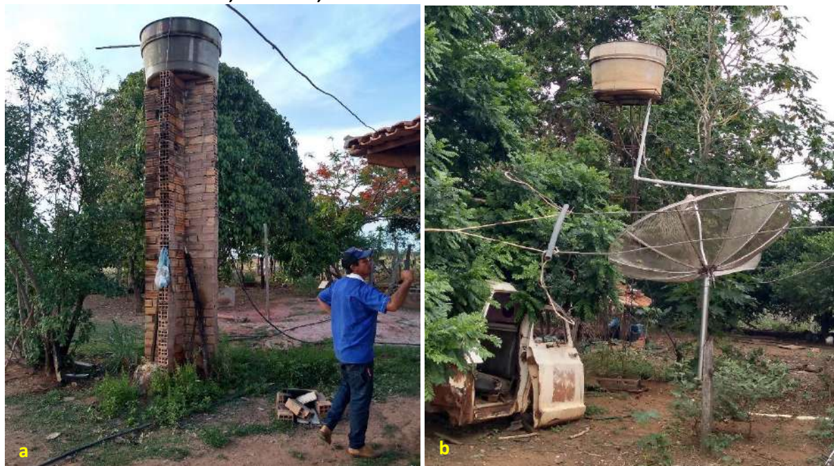
Foto 6.4 – Reservatório domiciliar sobre estrutura em alvenaria (a) e material metálico (b), Comunidade Cora Coralina, Faina-GO, 2018.
