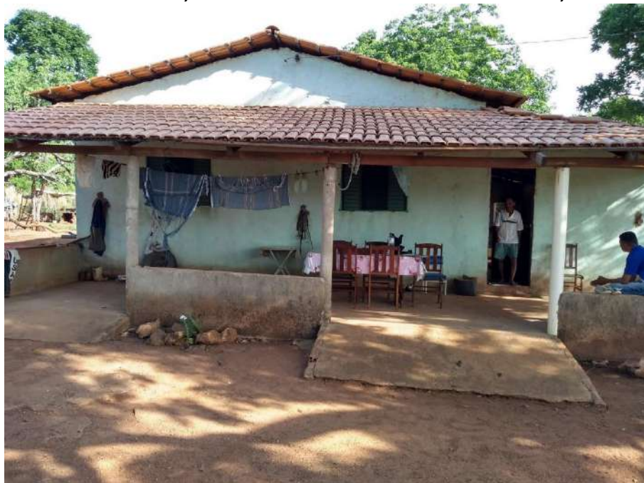
Foto 4.5 – Piso de concreto bruto, identificado na Comunidade Cora Coralina, Faina-GO, 2018.
