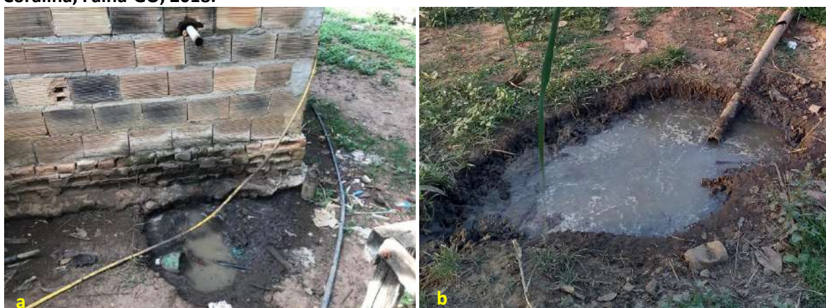
Foto 6.6 – Lançamento e acúmulo de água cinza proveniente da pia da cozinha ou do tanque de lavar roupas diretamente no solo do quintal próximo aos domicílios (a) e (b) na Comunidade Cora Coralina, Faina-GO, 2018.
