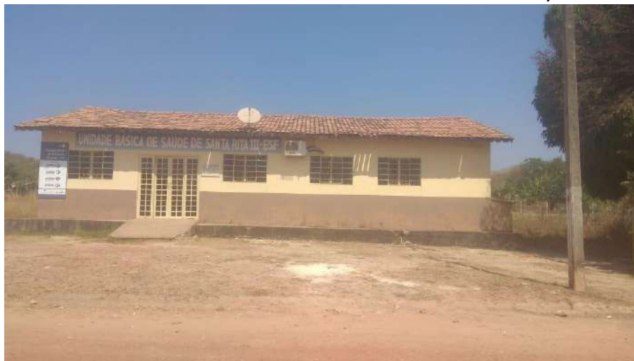
Foto 5.1 – Vista externa da UBSF Santa Rita III da Comunidade Cora Coralina, Faina-GO, 2018.
