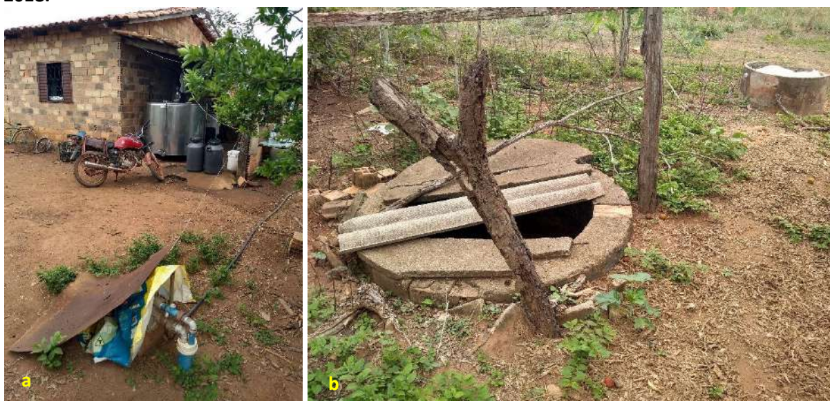
Foto 6.1 – Poço tubular raso (a) e poço raso escavado (b), Comunidade Cora Coralina, Faina-GO, 2018.
