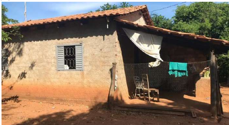
Foto 4.1 – Habitação construída de alvenaria com reboco, identificada na Comunidade Cora Coralina, Faina-GO, 2018.
