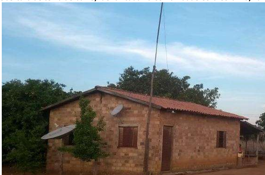
Foto 4.6 – Cobertura de telha de barro, identificada na Comunidade Cora Coralina, Faina-GO, 2018.
