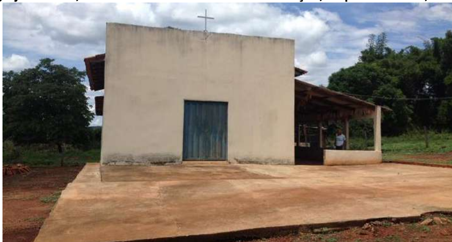
Foto 4.1 – Igreja católica, identificada na Comunidade Conceição, Niquelândia-GO, 2018.
