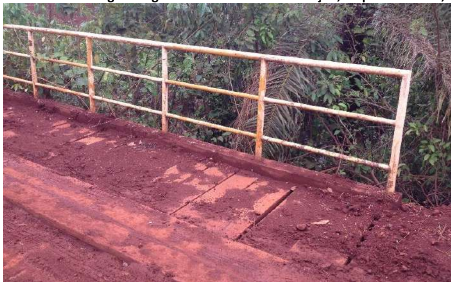
Foto 6.14 – Ponte sobre córrego Biliágua na Comunidade Conceição, Niquelândia-GO, 2018.
