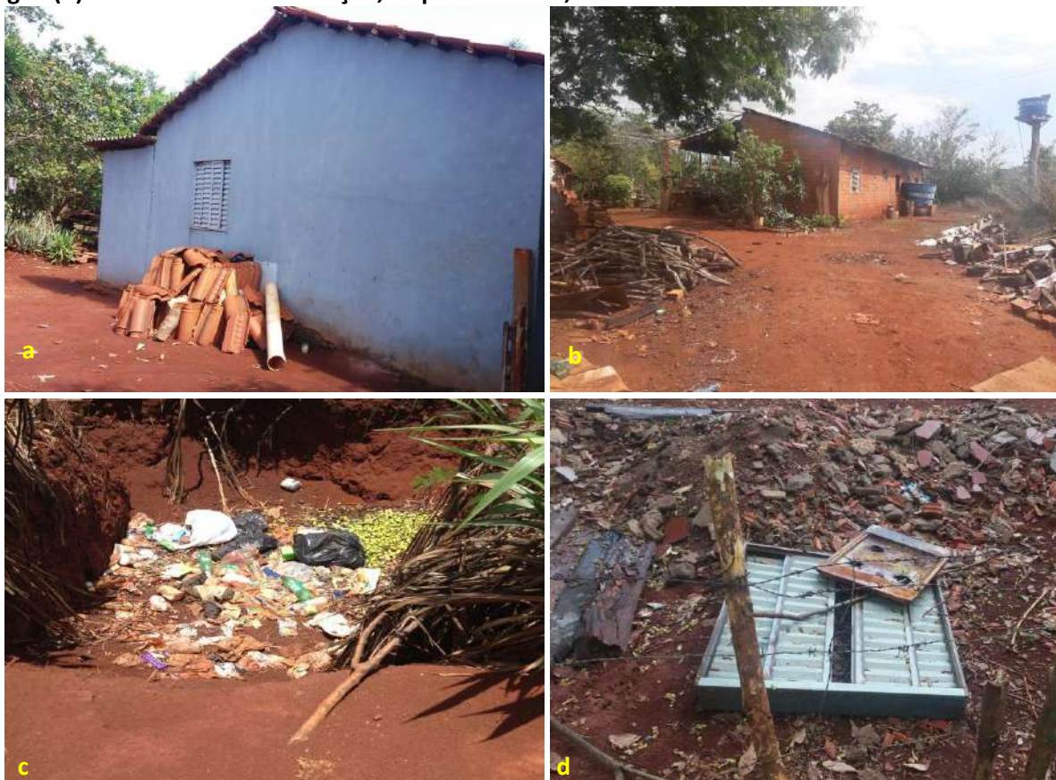
Foto 6.12 – Presença, nos quintais, de materiais de construção tipo: telhas cerâmica e tubo plástico (a), resíduos variados espalhados (b), acumulados em buraco (c) e resíduos capazes de acumular água (d) na Comunidade Conceição, Niquelândia-GO, 2018.
