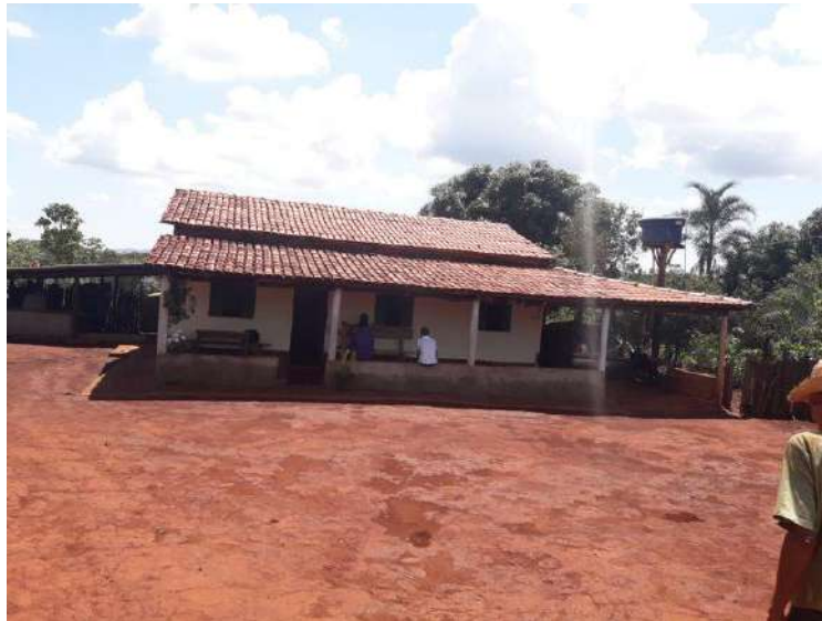
Foto 4.6 – Cobertura de telha de barro, identificada na Comunidade Conceição, Niquelândia-GO, 2018.
