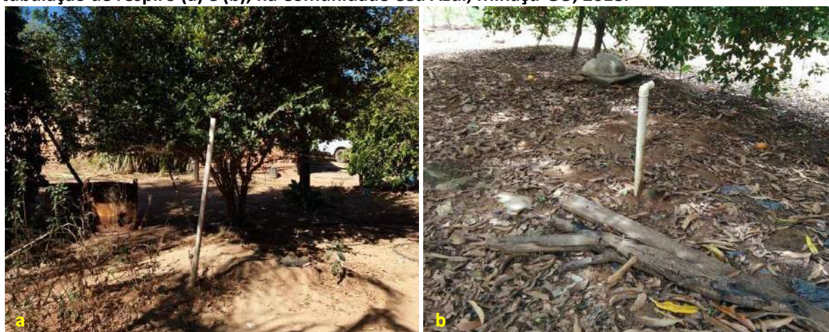
Foto 6.8 – Situações construtivas das fossas negras/rudimentares, abaixo do nível do solo e com tubulação de respiro (a) e (b), na Comunidade Céu Azul, Minaçu-GO, 2018.
