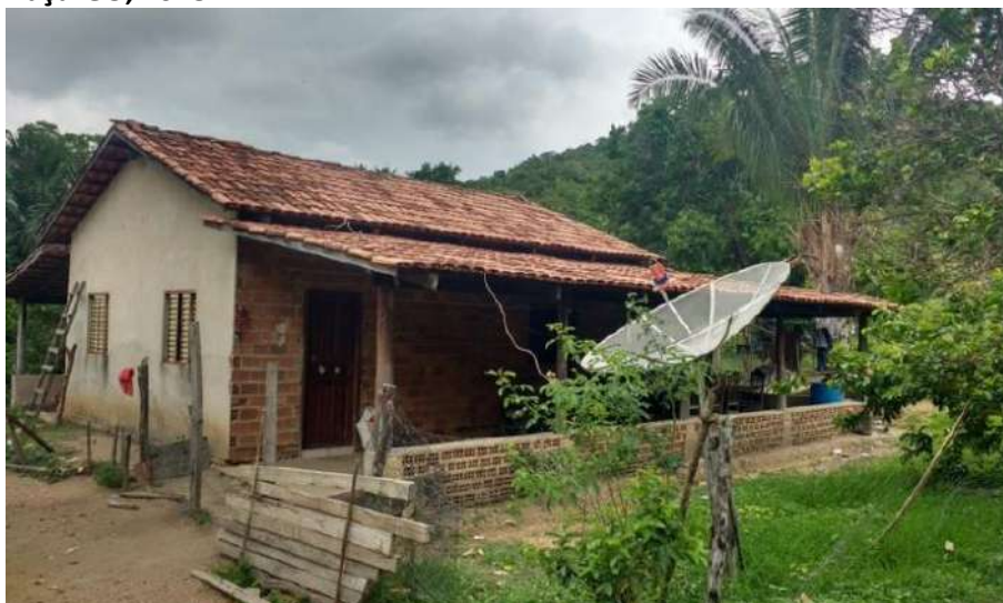
Foto 4.5 – Habitação construída de alvenaria com reboco e sem reboco, identificada na Comunidade Céu Azul, Minaçu-GO, 2018.
