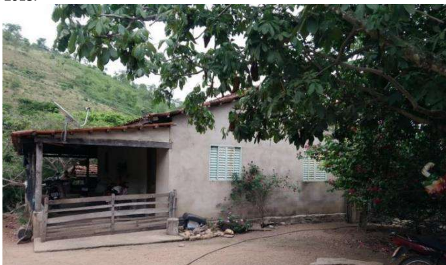
Foto 4.6 – Habitação construída de alvenaria com reboco, identificada na Comunidade Céu Azul, Minaçu-GO, 2018.
