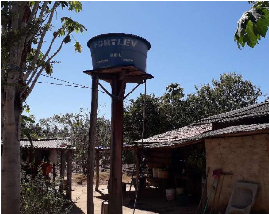
Foto 6.7 – Reservatório domiciliar instalado sobre uma estrutura de madeira, na Comunidade Capela, Cavalcante-GO, 2019.
