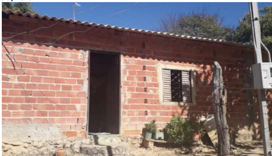
Foto 4.8 – Habitação construída de alvenaria sem reboco, identificada na Comunidade Capela, Cavalcante-GO, 2019.
