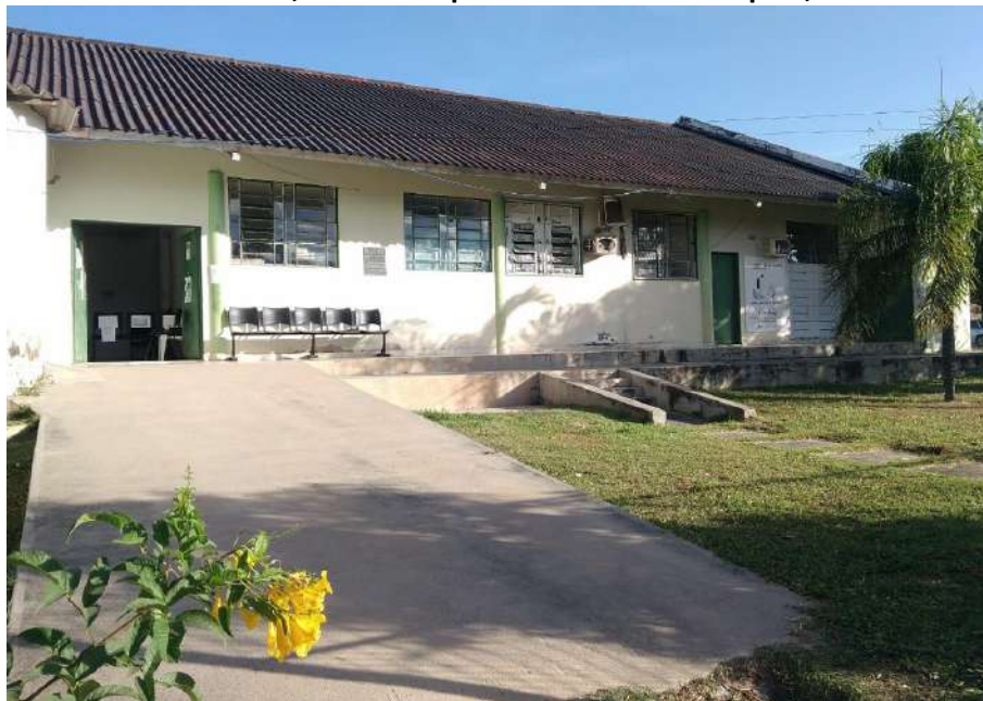
Foto 5.1 – Vista externa da UBS IV, referência para a Comunidade Capela, Cavalcante-GO, 2020.
