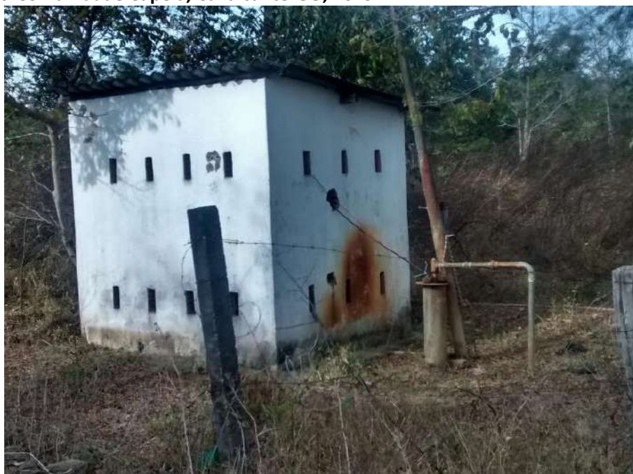
Foto 6.2 – Área de captação com cercas de isolamento, estrutura em alvenaria e poço tubular profundo, na Comunidade Capela, Cavalcante-GO, 2019.
