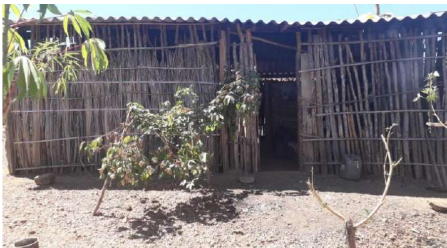
Foto 4.6 – Habitação construída de madeira, identificada na Comunidade Capela, Cavalcante-GO, 2019.
