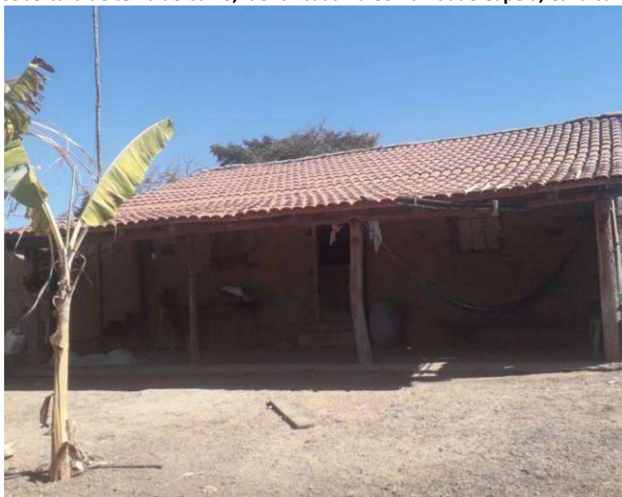
Foto 4.11 – Cobertura de telha de barro, identificada na Comunidade Capela, Cavalcante-GO, 2019.
