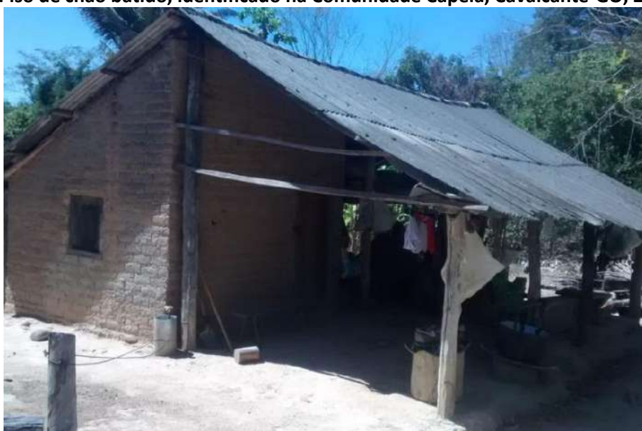
Foto 4.10 – Piso de chão batido, identificado na Comunidade Capela, Cavalcante-GO, 2019.
