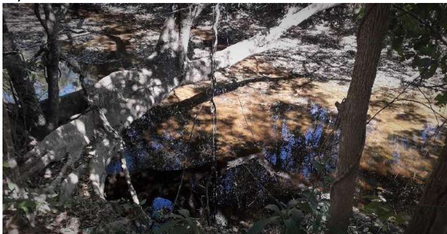
Foto 6.6 – Captação realizada por conjunto motobomba submerso, na Comunidade Capela, Cavalcante-GO, 2019.
