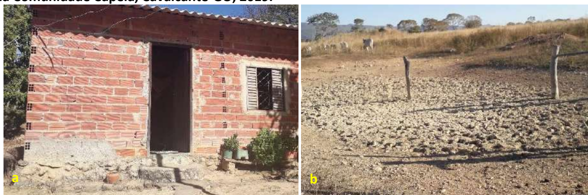
Foto 6.25 – Dispositivos de prevenção dos danos provocados pelas águas em residência (a) e lote (b) da Comunidade Capela, Cavalcante-GO, 2019.
