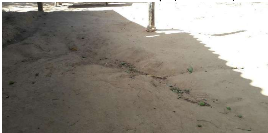
Foto 6.26 – Processo erosivo em lote da Comunidade Capela, Cavalcante-GO, 2019.
