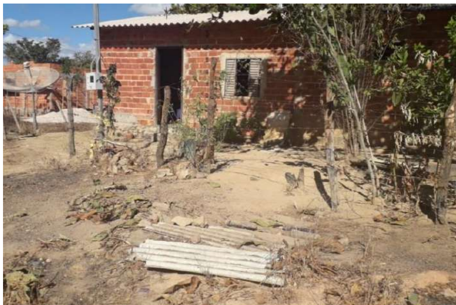
Foto 4.12 – Cobertura de telha fibrocimento, identificada na Comunidade Capela, Cavalcante-GO, 2019.
