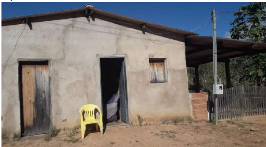
Foto 4.7 – Habitação construída de alvenaria com reboco, identificada na Comunidade Capela, Cavalcante-GO, 2019.
