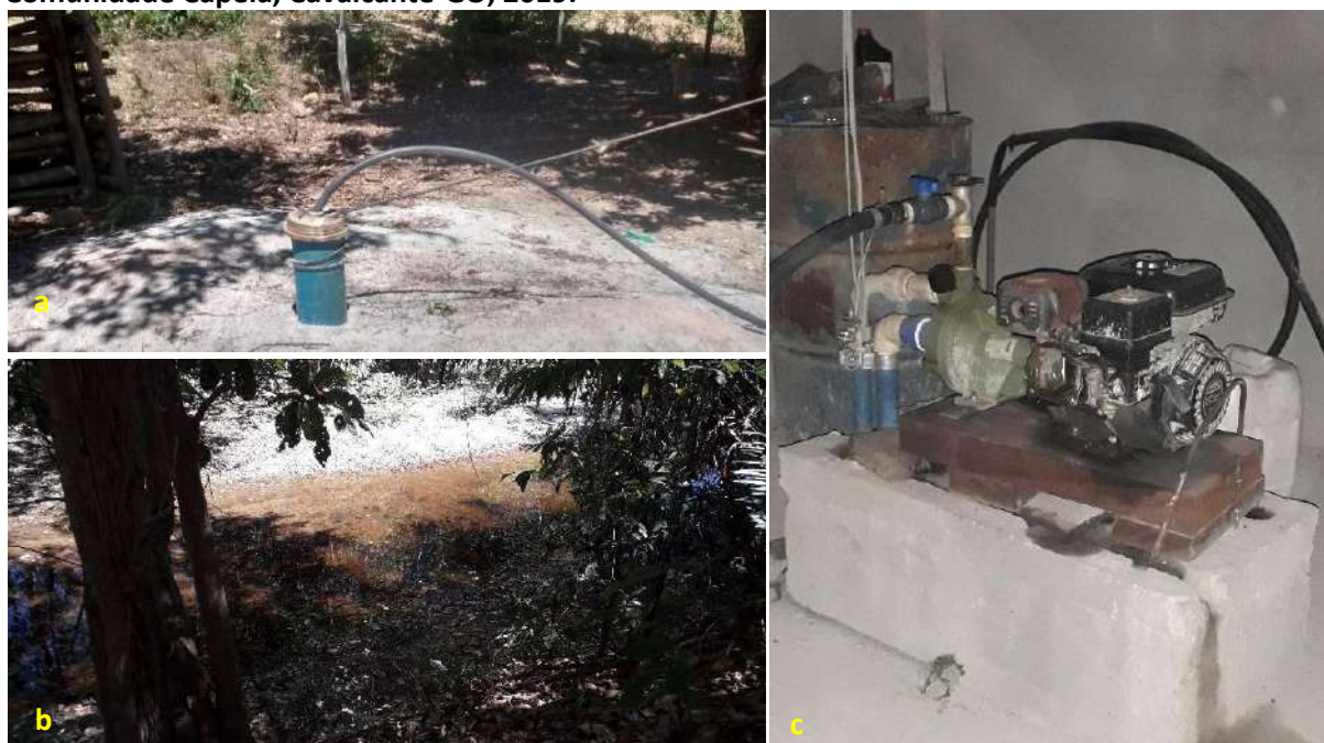
Foto 6.1 – Poço tubular profundo (a), manancial superficial (b) e poço tubular raso (c), na Comunidade Capela, Cavalcante-GO, 2019.
