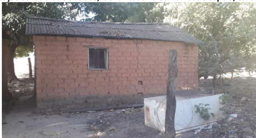
Foto 4.5 – Habitação construída de adobe, identificada na Comunidade Capela, Cavalcante-GO, 2019.
