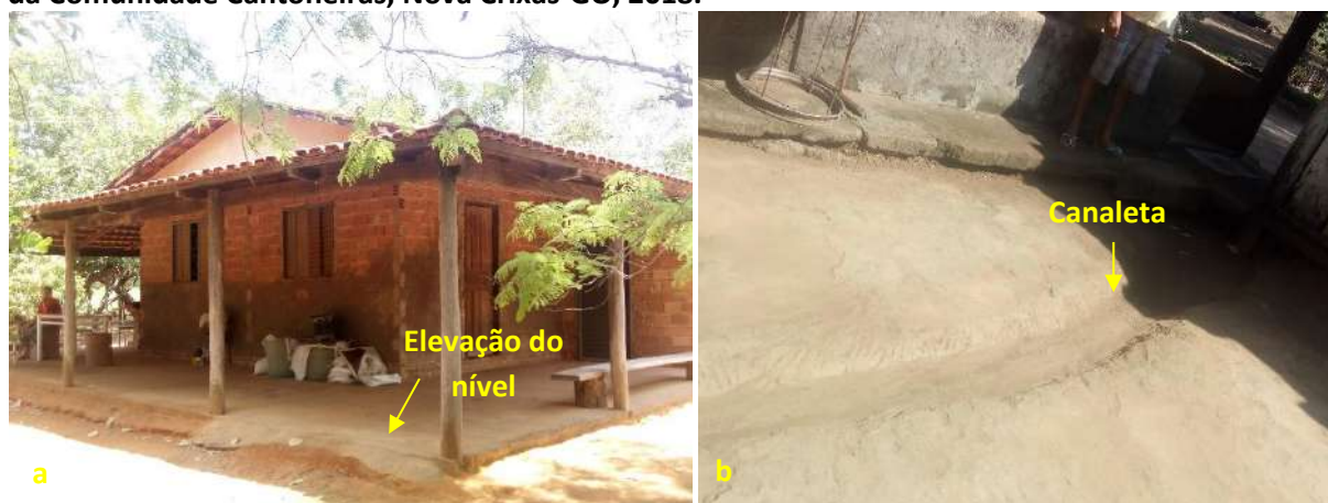
Foto 6.20 – Dispositivos de prevenção dos danos provocados pelas águas em residência (a) e lote (b) da Comunidade Cantoneiras, Nova Crixás-GO, 2018.
