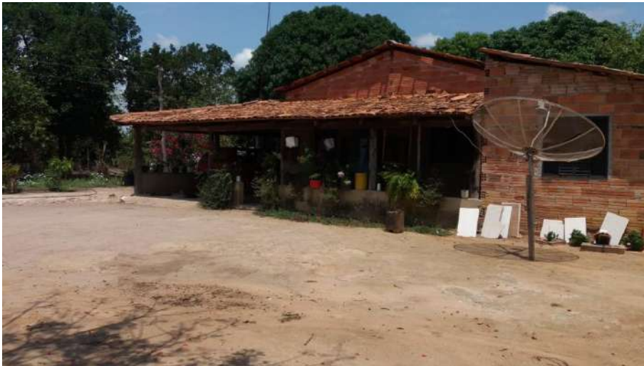
Foto 4.5 – Habitação construída de alvenaria sem reboco, identificada na Comunidade Cantoneiras, Nova Crixás-GO, 2018.
