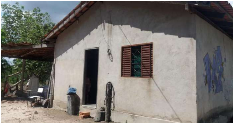
Foto 4.6 – Habitação construída de alvenaria com reboco, identificada na Comunidade Cantoneiras, Nova Crixás-GO, 2018.
