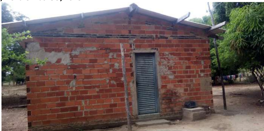
Foto 4.10 – Cobertura de telha de fibrocimento, identificada nas habitações da Comunidade Cantoneiras, Nova Crixás-GO, 2018.
