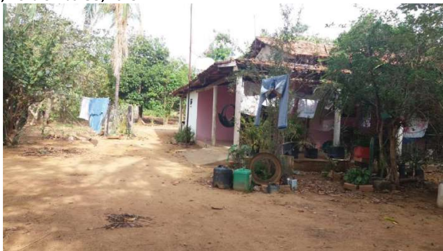
Foto 4.8 – Habitação construída de alvenaria com reboco e pintura, identificada na Comunidade Cantoneiras, Nova Crixás-GO, 2018.
