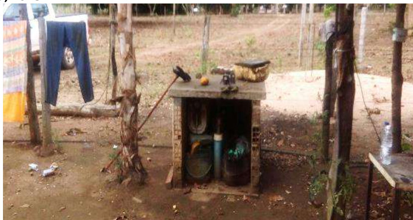
Foto 6.4 – Poço tubular profundo protegido por estrutura em alvenaria, na Comunidade Cantoneiras, Nova Crixás-GO, 2018.
