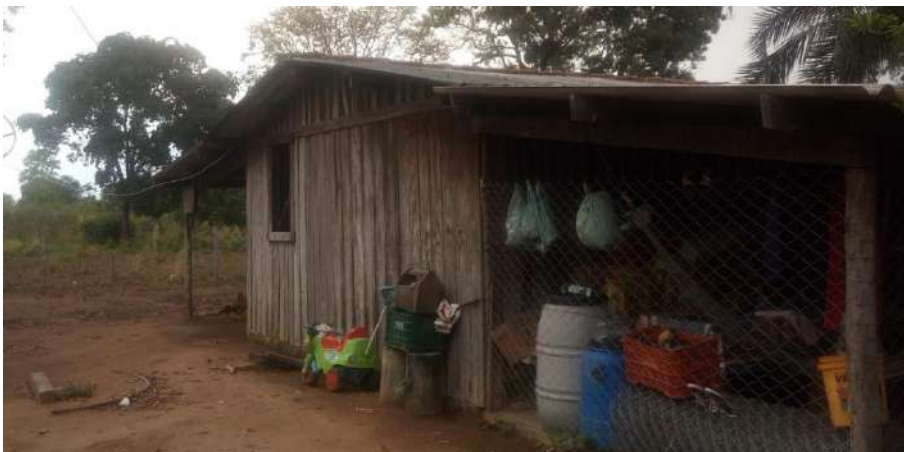
Foto 4.7 – Habitação construída de madeira, identificada na Comunidade Cantoneiras, Nova Crixás-GO, 2018.
