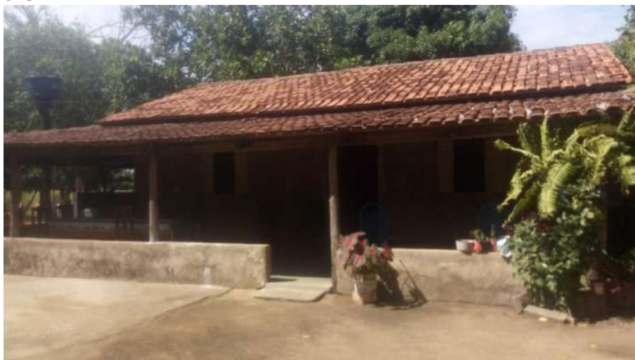
Foto 4.11 – Cobertura de telha de barro, identificada nas habitações Comunidade Cantoneiras, Nova Crixás-GO, 2018.
