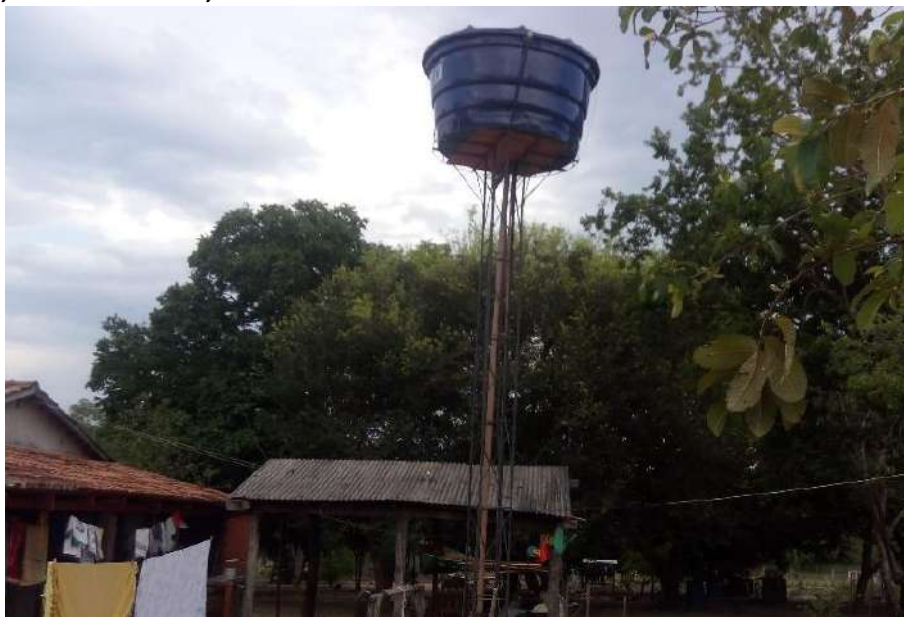
Foto 6.5 – Unidade familiar dotada de um único reservatório em polietileno, na Comunidade Cantoneiras, Nova Crixás-GO, 2018.
