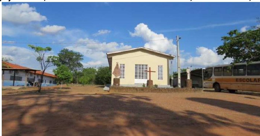
Foto 4.2 – Igreja católica, identificada na Comunidade Cantoneiras, Nova Crixás-GO, 2018.
