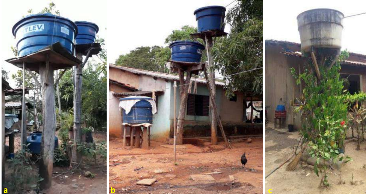
Foto 6.10 – Domicílios com dois (a) e três (b) reservatórios em polietileno e outro em cimento amianto com extravasor (c), na Comunidade Canabrava, Flores de Goiás-GO, 2019.
