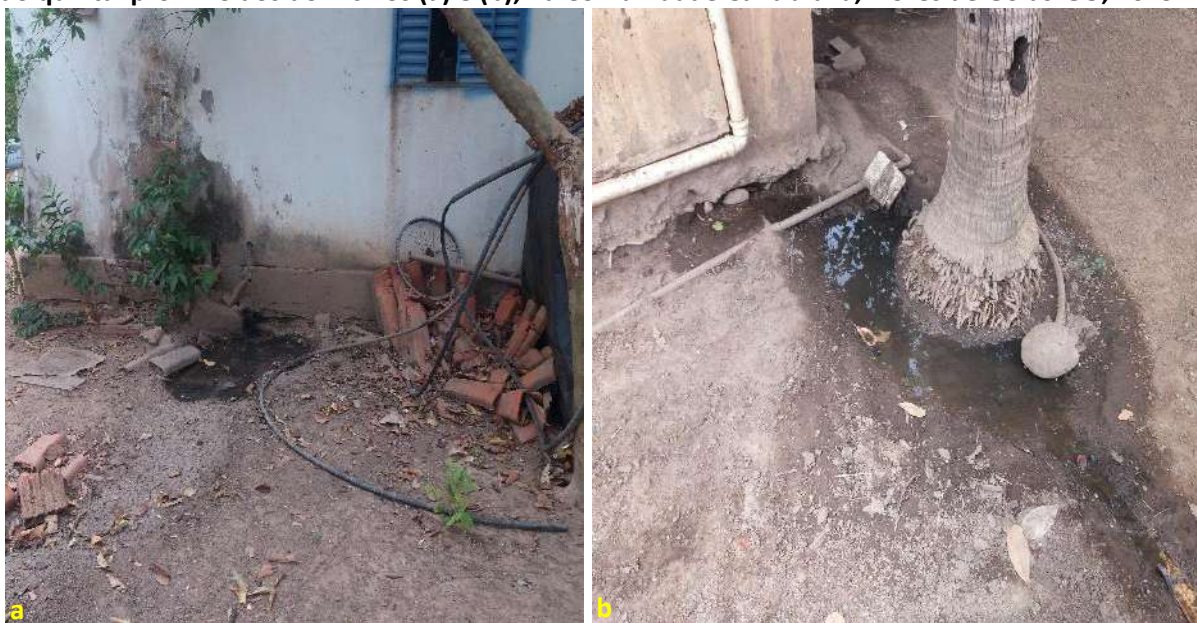
Foto 6.14 – Lançamento e acúmulo de água cinza proveniente da pia da cozinha diretamente no solo do quintal próximo aos domicílios (a) e (b), na Comunidade Canabrava, Flores de Goiás-GO, 2019.
