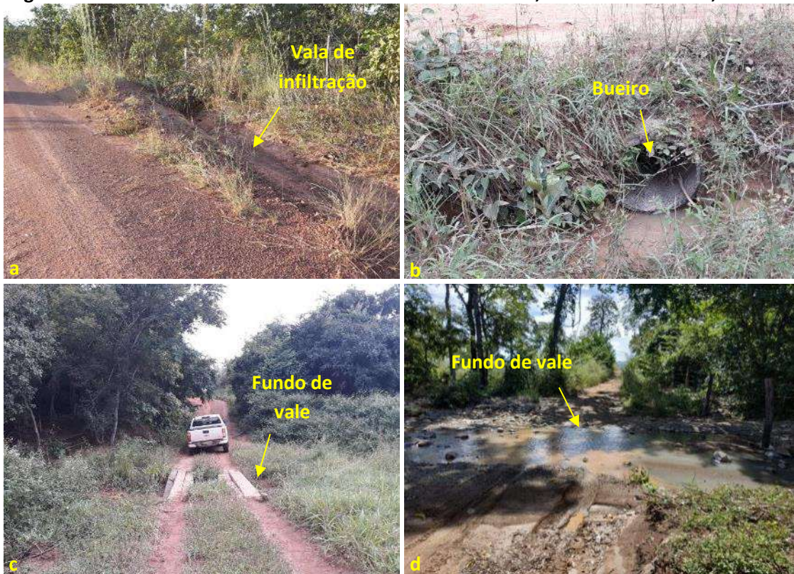
Foto 6.24 – Situação da drenagem pluvial: vala de infiltração (a), bueiro (b) e fundos de vale (c) e (d) ao longo das vias de acesso e internas na Comunidade Canabrava, Flores de Goiás-GO, 2019.
