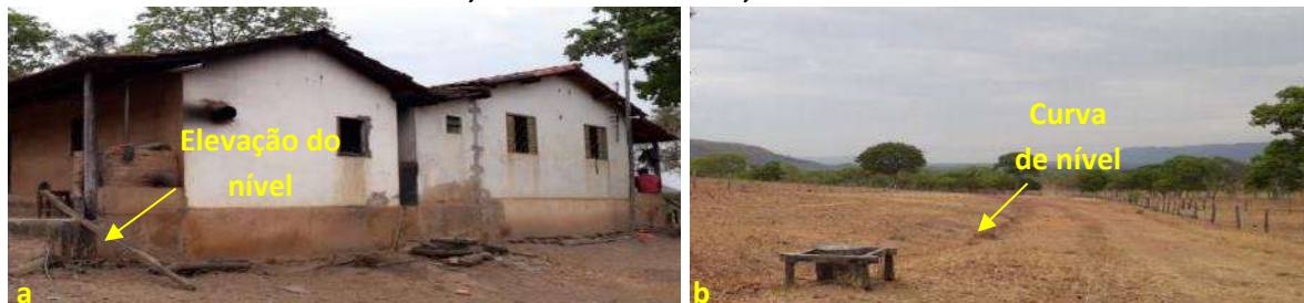
Foto 6.28 – Dispositivos de prevenção dos danos provocados pelas águas (a) nas residências e (b) nas vias da Comunidade Canabrava, Flores de Goiás-GO, 2019.
