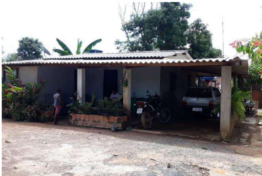
Foto 4.13 – Cobertura do tipo fibrocimento, identificada na Comunidade Canabrava, Flores de Goiás-GO, 2019.
