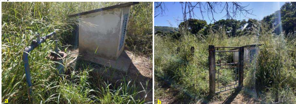
Foto 6.4 – Poço tubular profundo (F2) que abastece 7,1% da Comunidade Canabrava, Flores de Goiás-GO, 2019.
