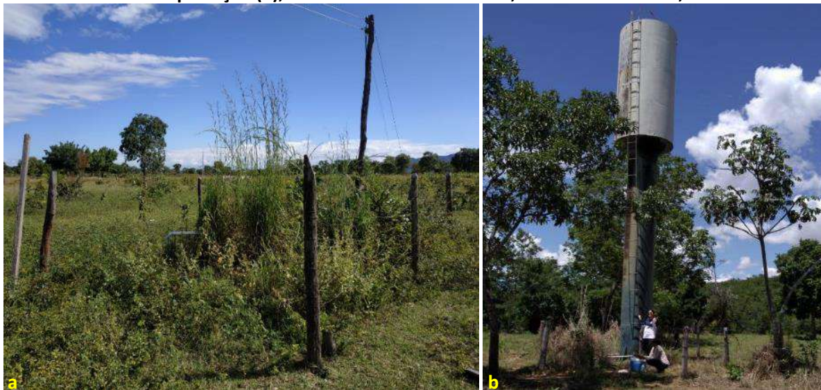
Foto 6.6 – Área de captação (F3) cercada, poço tubular profundo obstruído pelo mato (a) e reservatório elevado com cerca de proteção (b), na Comunidade Canabrava, Flores de Goiás-GO, 2019.
