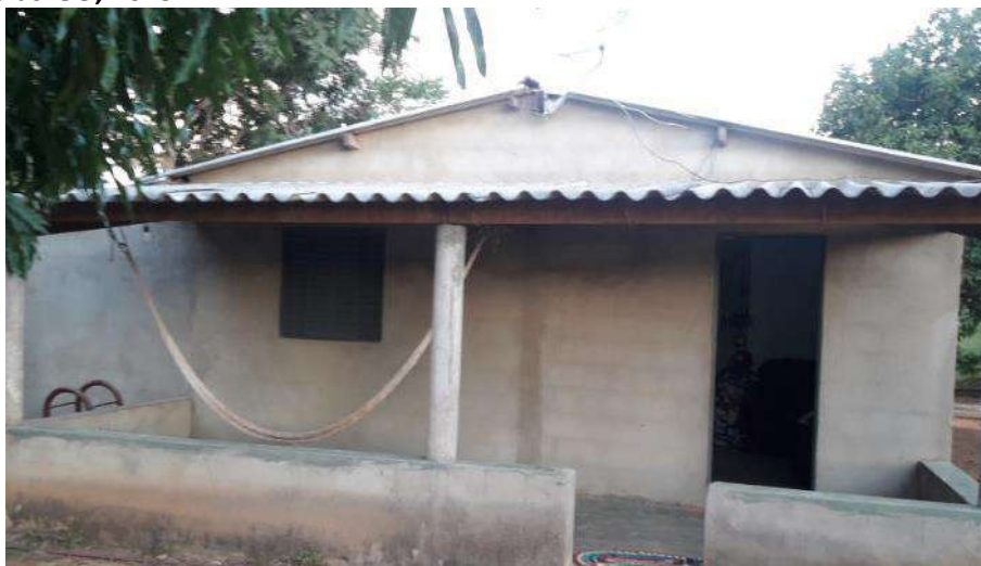
Foto 4.7 – Habitação construída de alvenaria com reboco, identificada na Comunidade Canabrava, Flores de Goiás-GO, 2019.
