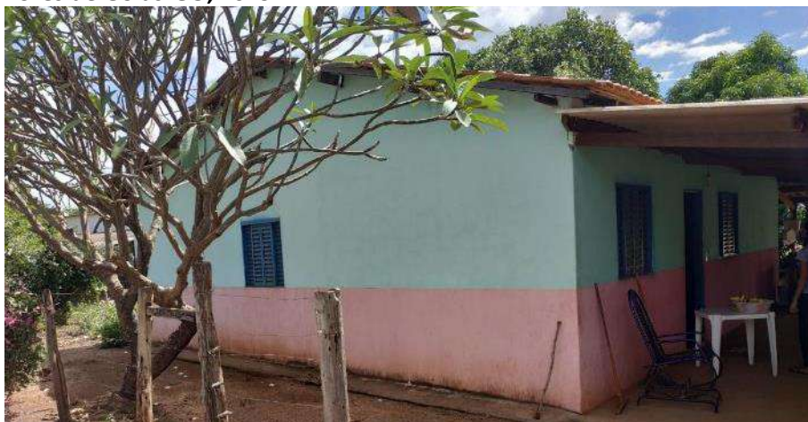
Foto 4.8 – Habitação construída de alvenaria com reboco e pintura, identificada na Comunidade Canabrava, Flores de Goiás-GO, 2019.
