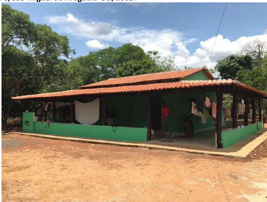
Foto 4.3 – Habitação construída de alvenaria com reboco e pintura, identificada na Comunidade Campo Alegre, São Miguel do Araguaia-GO, 2018.
