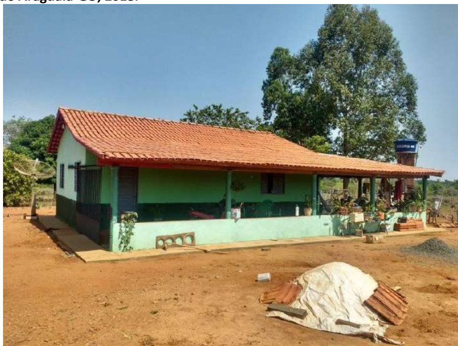
Foto 4.6 – Cobertura de telha de barro, identificada nas habitações da Comunidade Campo Alegre, São Miguel do Araguaia-GO, 2018.
