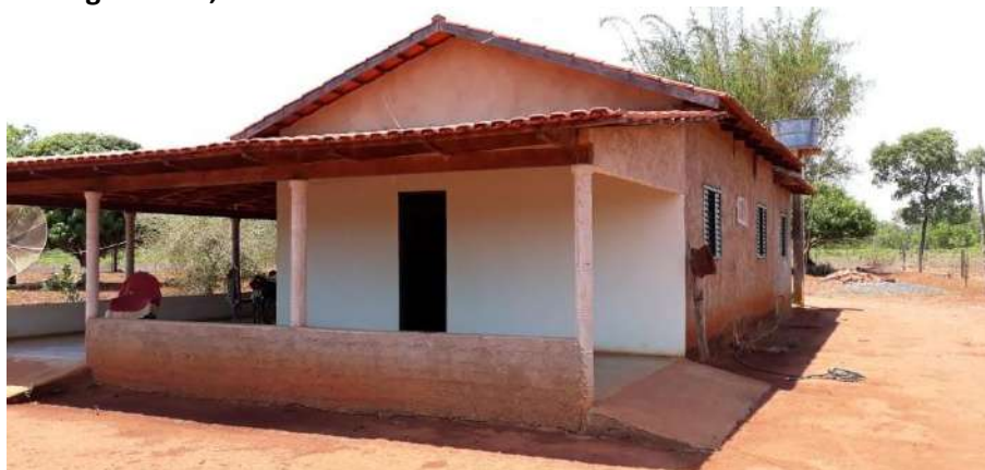
Foto 4.4 – Piso de cimento queimado, identificado nas habitações da Comunidade Campo Alegre, São Miguel do Araguaia-GO, 2018.
