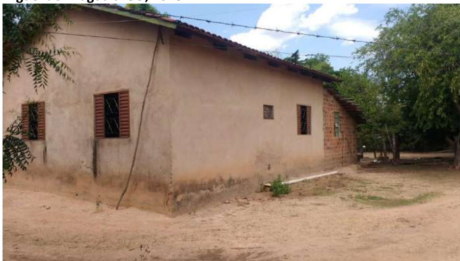
Foto 4.2 – Habitação construída de alvenaria com reboco, identificada na Comunidade Campo Alegre, São Miguel do Araguaia-GO, 2018.
