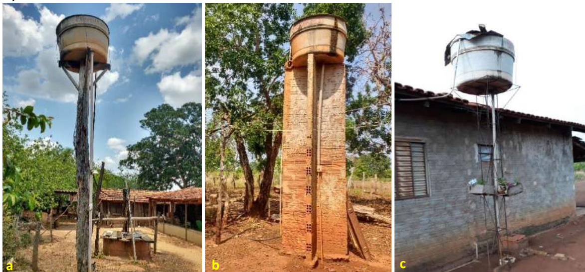
Foto 6.5 – Reservatórios domiciliares em fibrocimento instalados sobre estrutura: em madeira (a), em alvenaria (b), em estrutura metálica (c), na Comunidade Campo Alegre, São Miguel do Araguaia-GO, 2018.
