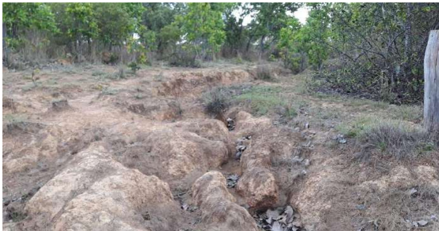
Foto 6.23 – Processo erosivo em lote da Comunidade Campo Alegre, São Miguel do Araguaia-GO, 2018.
