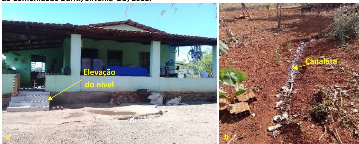
Foto 6.16 – Dispositivos de prevenção dos danos provocados pelas águas em residência (a) e lote (b) da Comunidade Buriti, Silvânia-GO, 2018.
