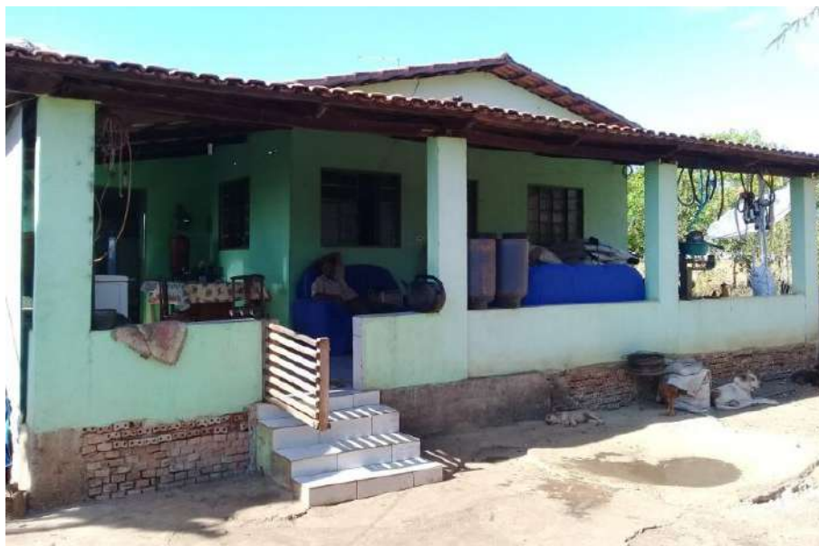
Foto 4.5 – Piso de residência constituído de cerâmica, identificado na Comunidade Buriti, Silvânia-GO, 2018.
