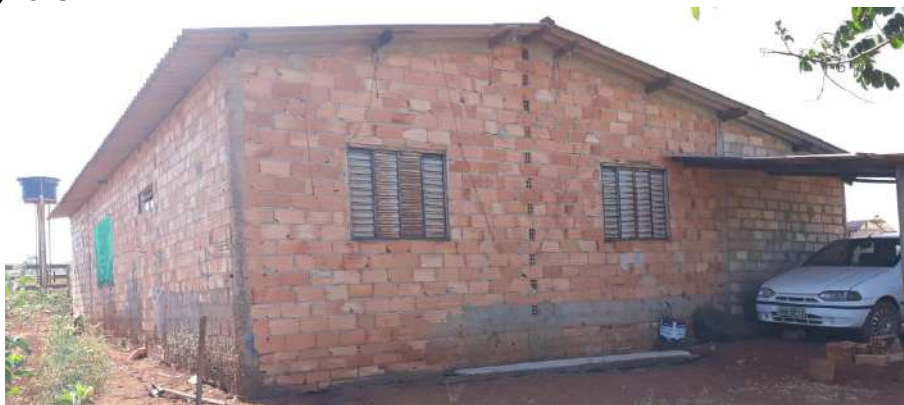
Foto 4.1 – Habitação construída de alvenaria sem reboco, identificada na Comunidade Buriti, Silvânia-GO, 2018.
