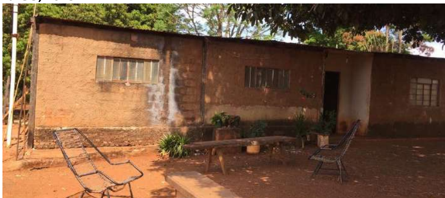
Foto 4.2 – Habitação construída de alvenaria com reboco, sem pintura, identificada na Comunidade Buriti, Silvânia-GO, 2018.
