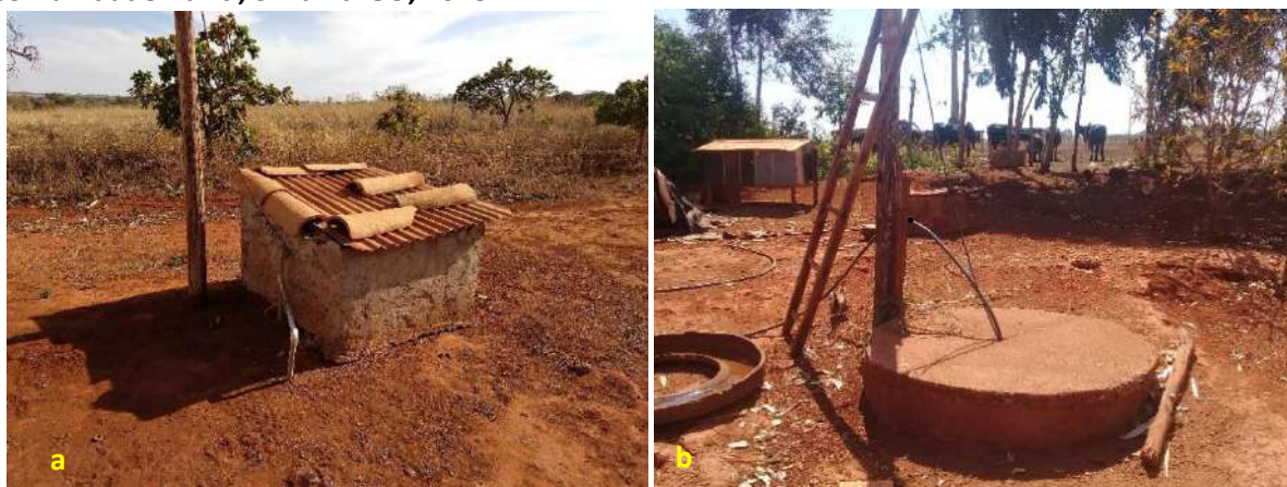
Foto 6.1 – Fontes de abastecimento de água: poço tubular raso (a) e poço raso escavado (b), na Comunidade Buriti, Silvânia-GO, 2018.
