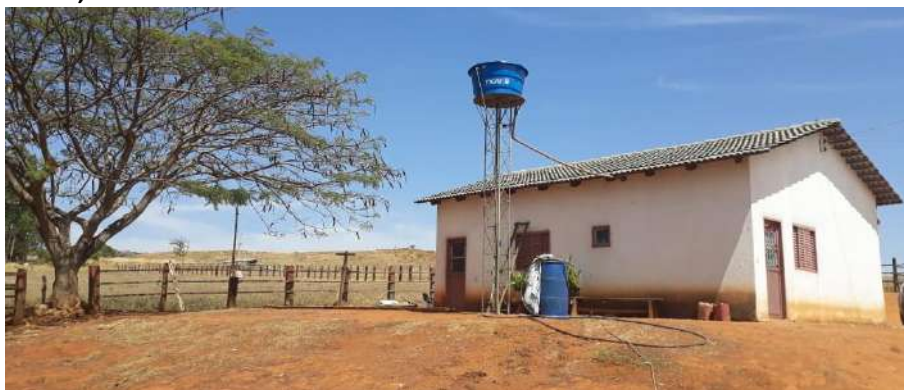
Foto 4.3 – Habitação construída de alvenaria com reboco e pintura, identificada na Comunidade Buriti, Silvânia-GO, 2018.
