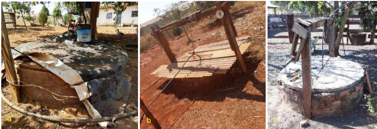
Foto 6.2 – Poços rasos escavados em diferentes condições, com mureta de proteção e cobertos com madeira e lona (a), telha ondulada de fibrocimento (b) e tampa de concreto (c), na Comunidade Buriti, Silvânia-GO, 2018.
