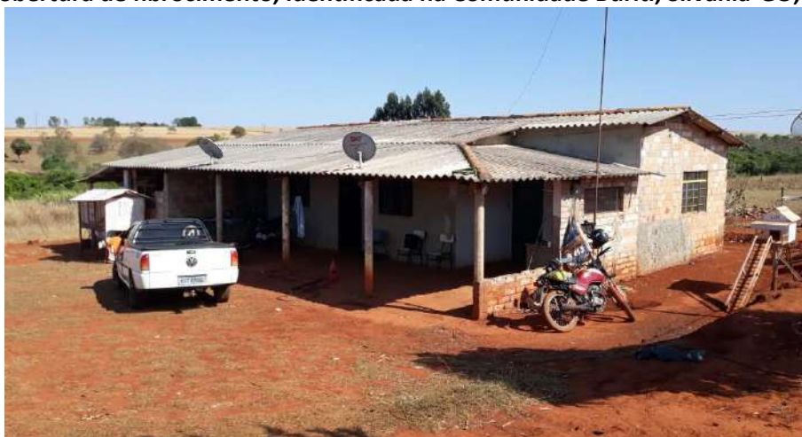
Foto 4.7 – Cobertura de fibrocimento, identificada na Comunidade Buriti, Silvânia-GO, 2018.
