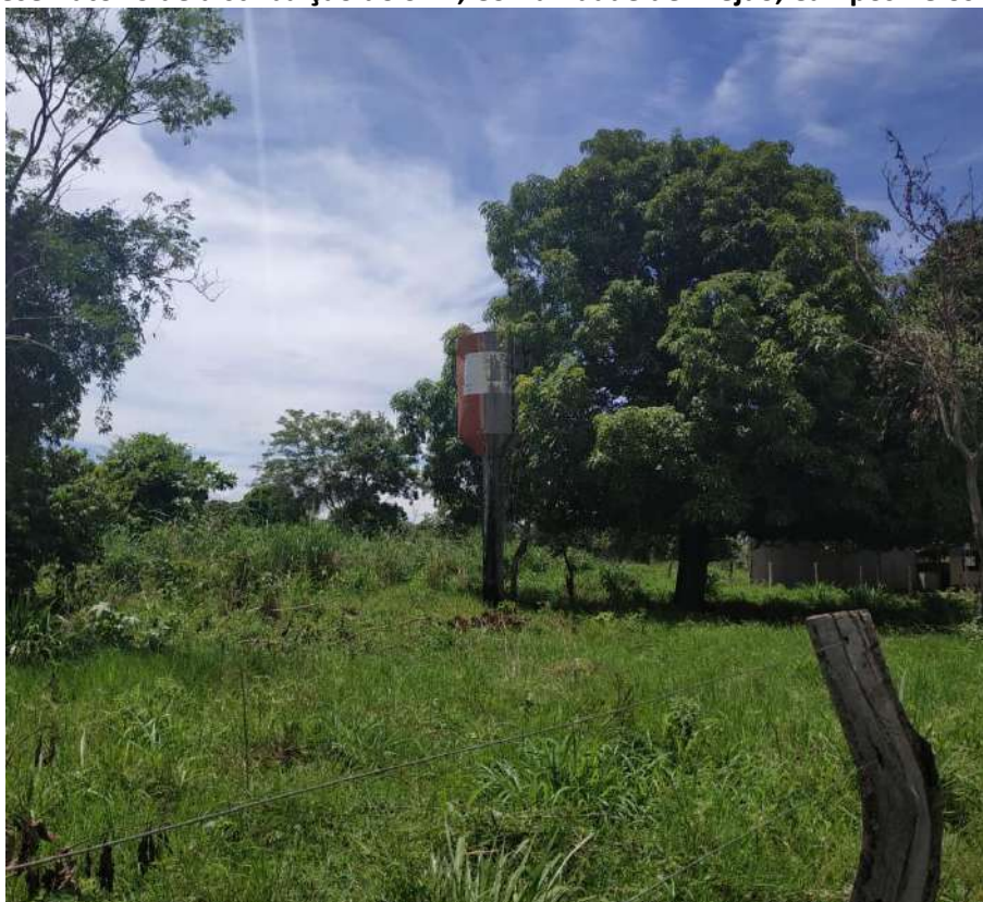
Foto 6.3 – Reservatório de distribuição do SAA, Comunidade de Brejão, Campos Belos-GO, 2019.
