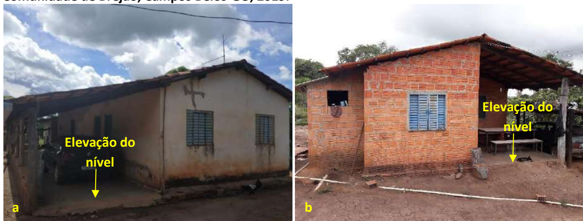
Foto 6.22 – Dispositivos de prevenção dos danos provocados pelas águas em residências da Comunidade de Brejão, Campos Belos-GO, 2019.
