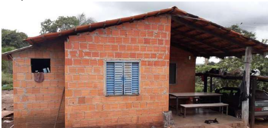
Foto 4.5 – Habitação construída de alvenaria sem reboco, identificada na Comunidade de Brejão, Campos Belos-GO, 2019.
