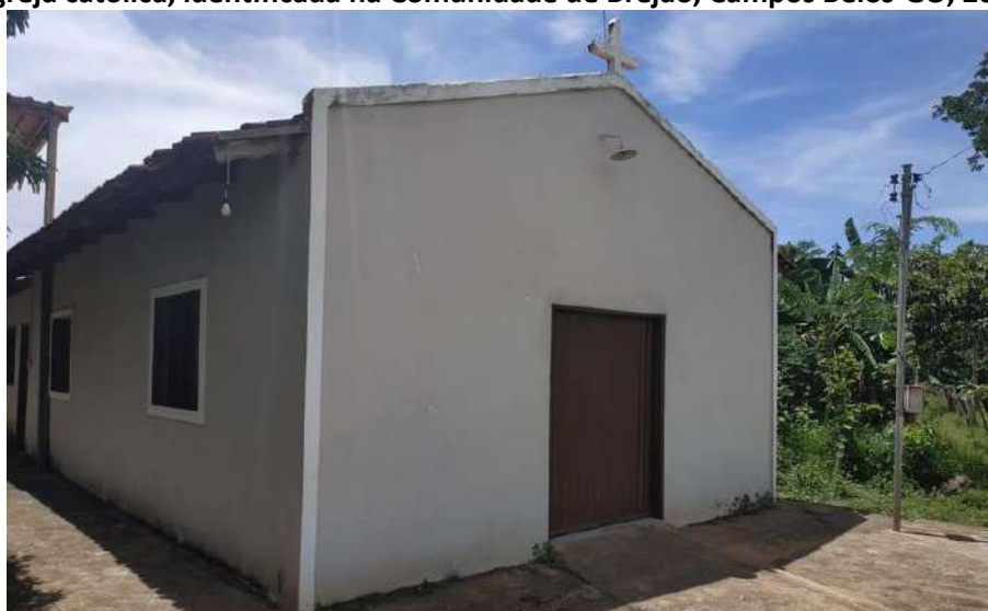
Foto 4.2 – Igreja católica, identificada na Comunidade de Brejão, Campos Belos-GO, 2019.
