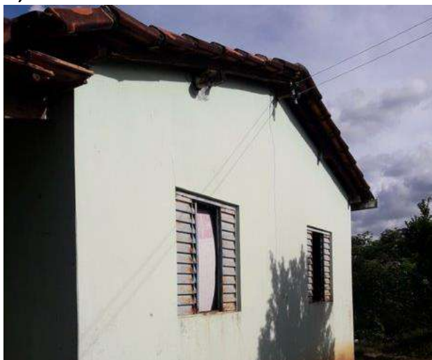
Foto 4.7 – Habitação construída de alvenaria com reboco e pintura, identificada na Comunidade de Brejão, Campos Belos-GO, 2019.
