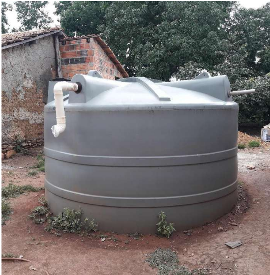
Foto 6.5 – Cisterna utilizada para armazenar a água de chuva, Comunidade de Brejão, Campos Belos-GO, 2019.
