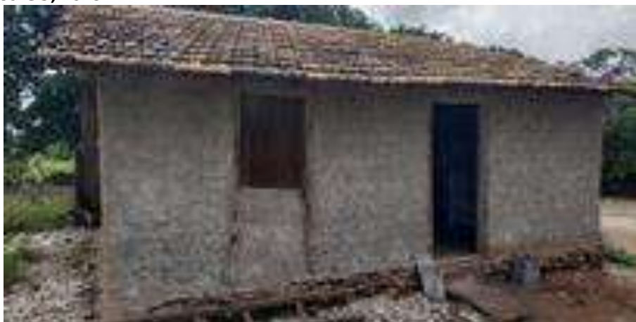
Foto 4.6 – Habitação construída de alvenaria com reboco, identificada na Comunidade de Brejão, Campos Belos-GO, 2019.
