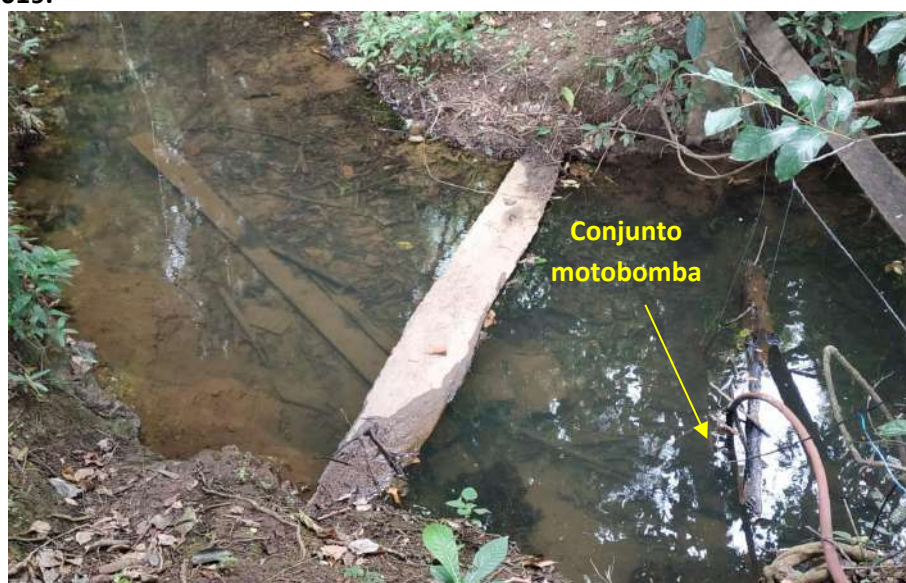
Foto 6.4 – Captação realizada por conjunto motobomba submerso, Comunidade de Brejão, Campos Belos-GO, 2019.
