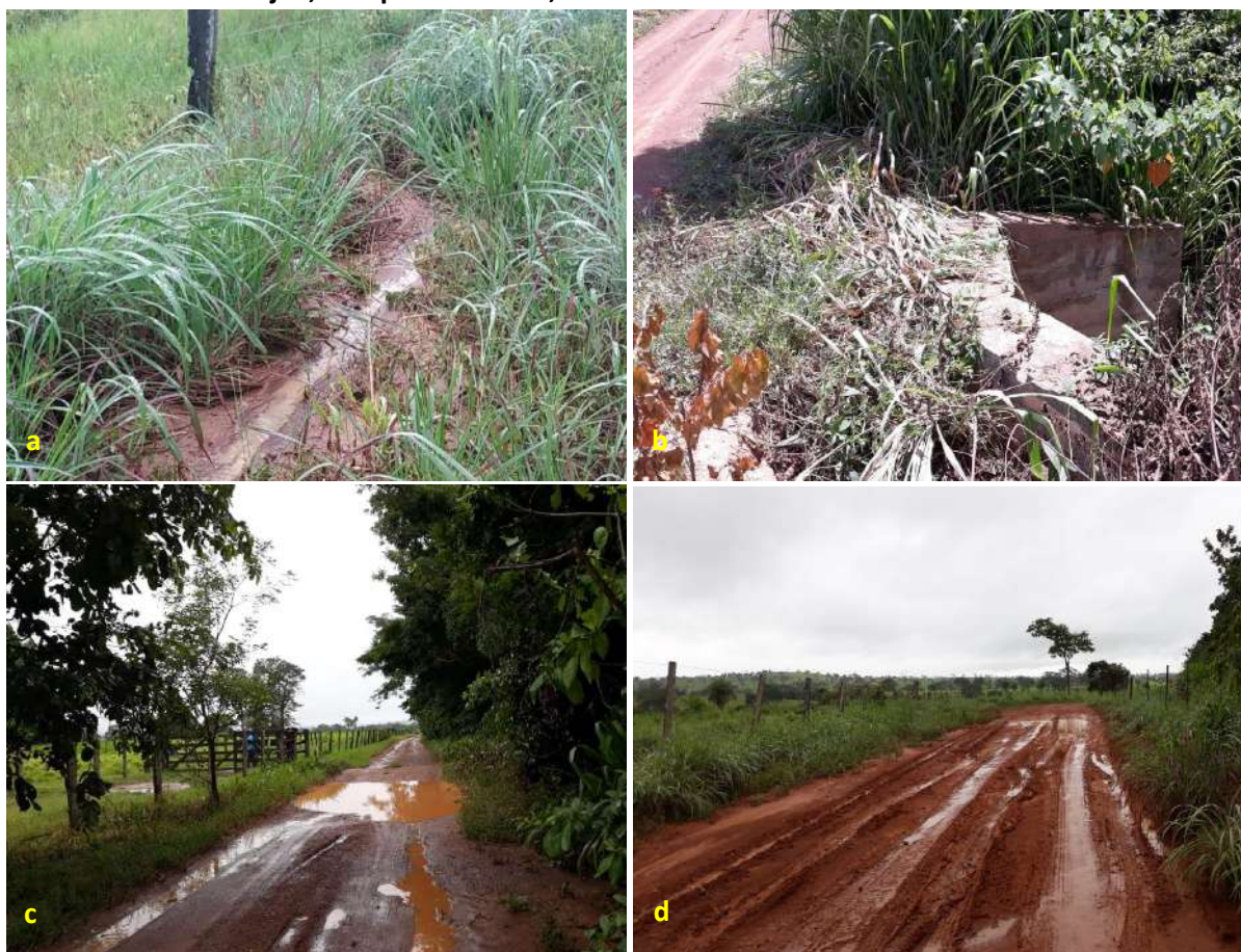
Foto 6.19 – Vala de infiltração (a), bueiro (b), ponto de alagamento (c) e atoleiro (d) na via de acesso à Comunidade de Brejão, Campos Belos-GO, 2019.
