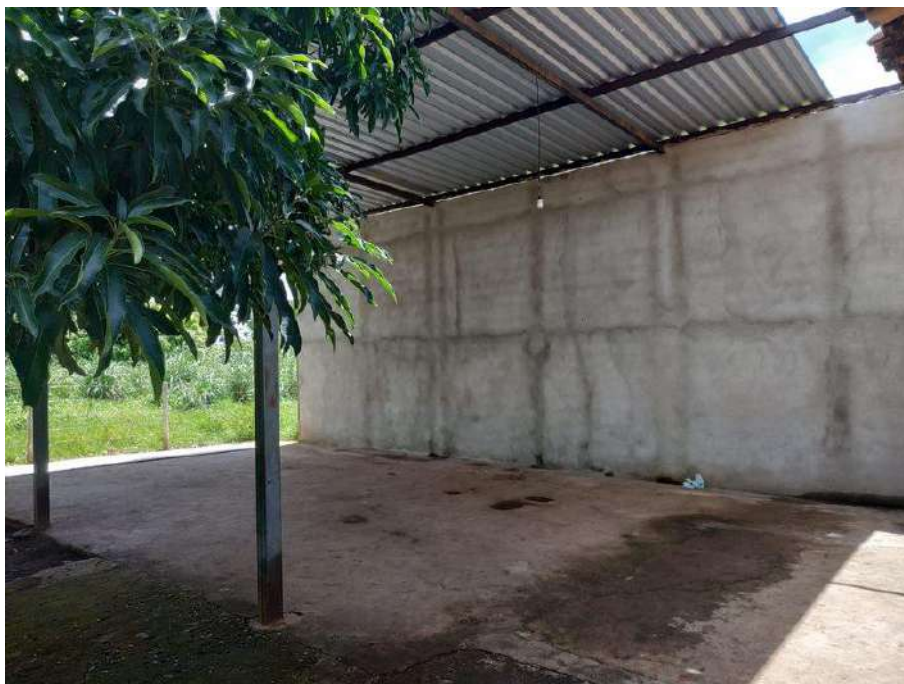
Foto 4.4 – Galpão para realização de reuniões, identificado na Comunidade de Brejão, Campos Belos-GO, 2019.
