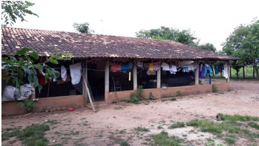
Foto 4.10 – Cobertura de telha de barro, identificada nas habitações da Comunidade de Brejão, Campos Belos-GO, 2019.
