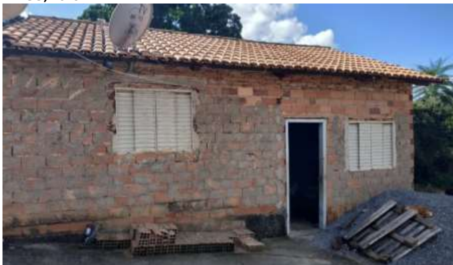
Foto 4.3 – Habitação construída de alvenaria sem reboco, identificada na Comunidade Boa Nova, Professor Jamil-GO, 2019.
