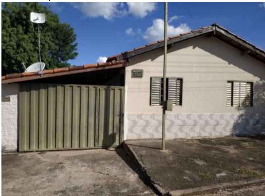
Foto 4.1 – Habitação construída de alvenaria com reboco e pintura, identificada na Comunidade Boa Nova, Professor Jamil-GO, 2019.
