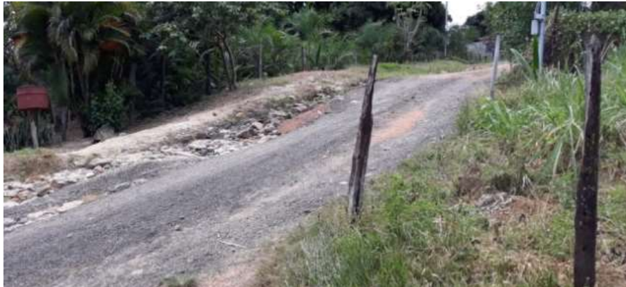
Foto 6.13 – Via interna sem pavimentação da Comunidade Boa Nova, Professor Jamil-GO, 2019.
