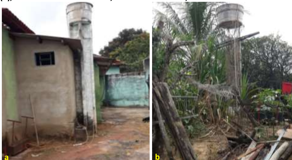
Foto 6.3 – Reservatório domiciliar instalado sobre estrutura de alvenaria (a) e outro sobre estrutura de metal (b), na Comunidade Boa Nova, Professor Jamil-GO, 2019
