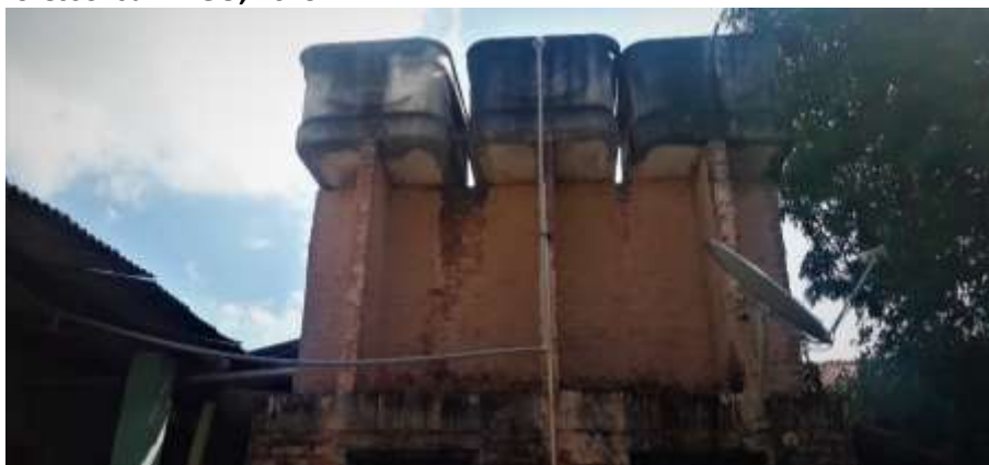
Foto 6.2 – Três reservatórios domiciliares ligados por tubulação vaso comunicantes, na Comunidade Boa Nova, Professor Jamil-GO, 2019
