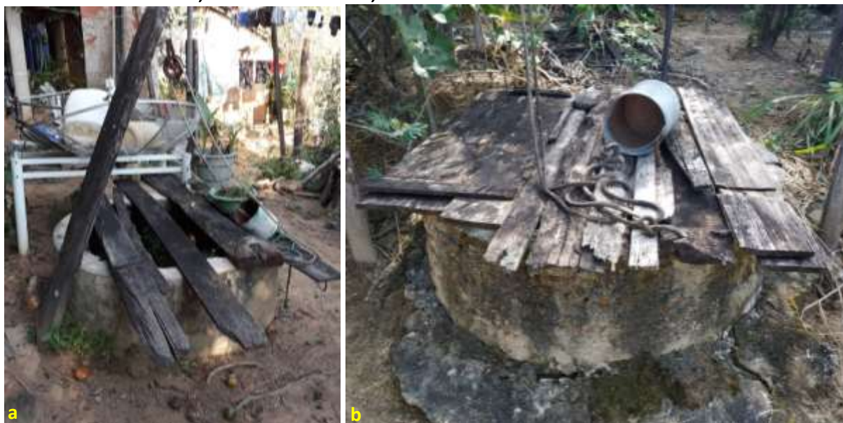
Foto 6.1 – Poço raso escavado tampado com madeira (a) e outro com calçamento parcial (b), na Comunidade Boa Nova, Professor Jamil-GO, 2019.
