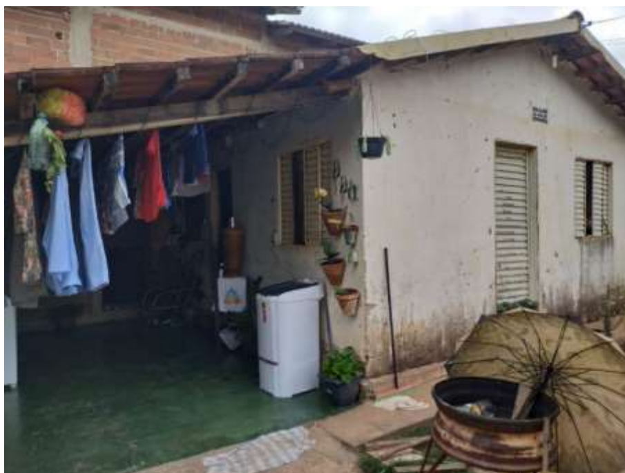
Foto 4.5 – Piso de cimento queimado, identificado na Comunidade Boa Nova, Professor Jamil-GO, 2019.
