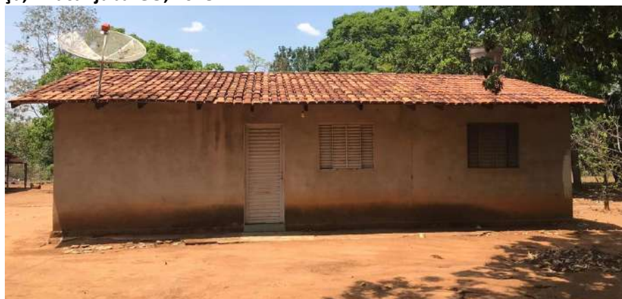
Foto 4.5 – Habitação construída de alvenaria com reboco sem pintura, identificada na Comunidade Boa Esperança, Piracanjuba-GO, 2018.
