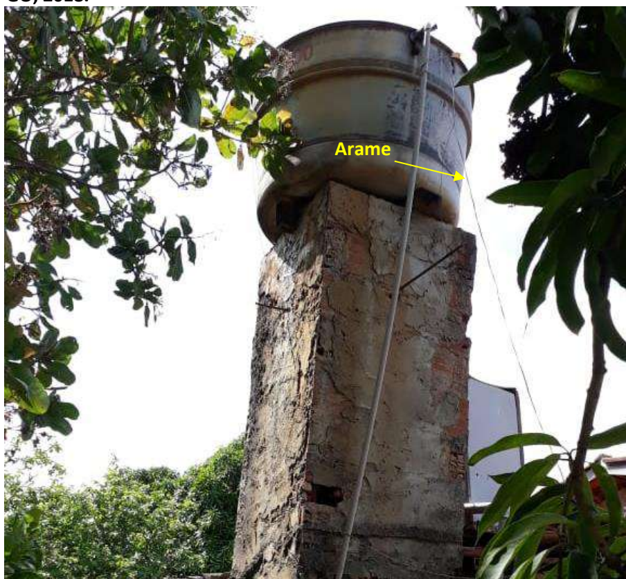
Foto 6.5 – Reservatório domiciliar com tampa amarrada com arame, Comunidade Boa Esperança, Piracanjuba-GO, 2018.
