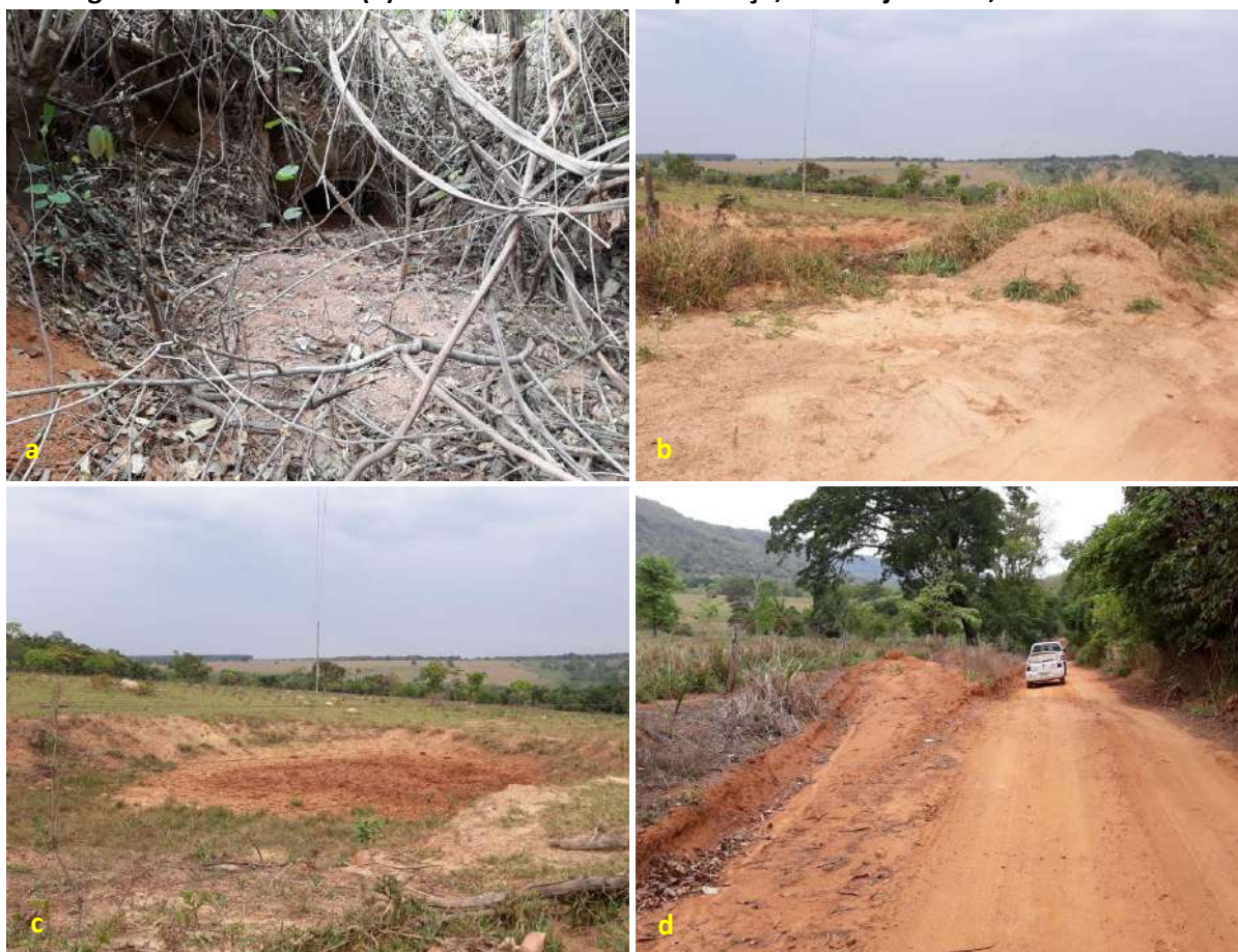
Foto 6.18 – Bueiro assoreado (a), vala de infiltração assoreada (b), bacia de contenção (c) e valeta na margem da via de acesso (d) à Comunidade Boa Esperança, Piracanjuba-GO, 2018.
