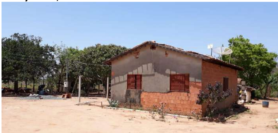
Foto 4.6 – Habitação construída de alvenaria sem reboco, identificada na Comunidade Boa Esperança, Piracanjuba-GO, 2018.
