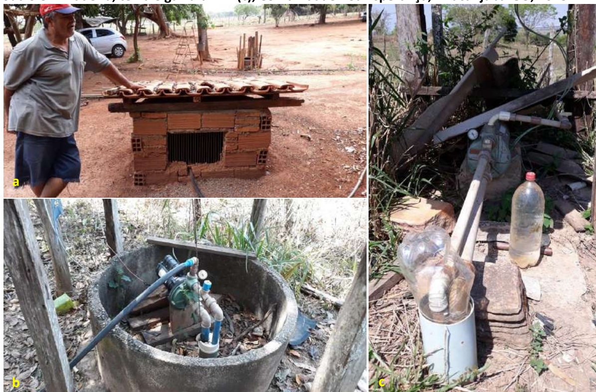
Foto 6.3 – Poço tubular raso abrigado em estrutura em alvenaria (a), em anilha em concreto (b) e outro em madeira, telha e garrafa PET (c), Comunidade Boa Esperança, Piracanjuba-GO, 2018.
