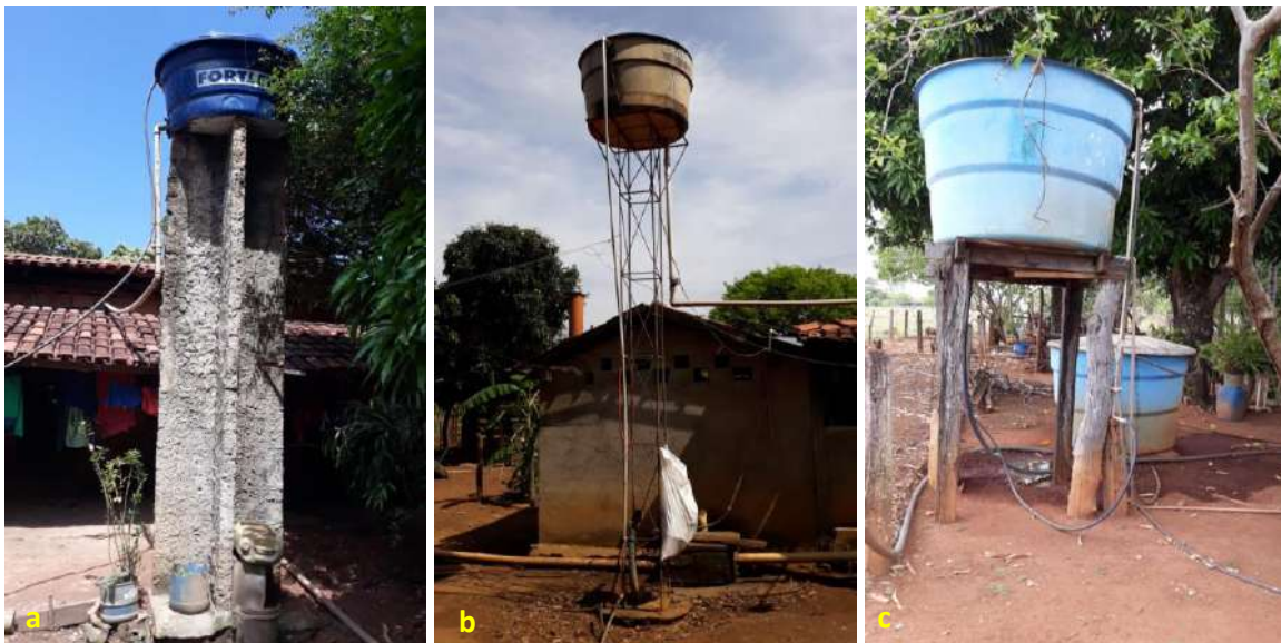
Foto 6.6 – Reservatório domiciliar instalado sobre estrutura em alvenaria (a), estrutura metálica (b) e outro sobre estrutura construída com madeira (c), Comunidade Boa Esperança, Piracanjuba-GO, 2018.
