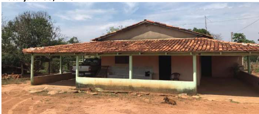
Foto 4.7 – Piso de residência constituído de concreto bruto, identificado na Comunidade Boa Esperança, Piracanjuba-GO, 2018.
