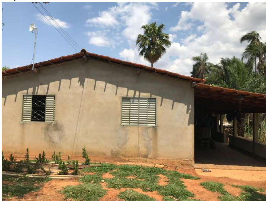
Foto 4.8 – Piso de residência constituído de cerâmica, identificado na Comunidade Boa Esperança, Piracanjuba-GO, 2018.
