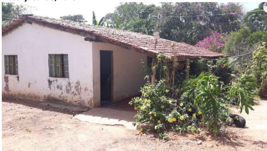
Foto 4.9 – Piso de residência constituído de cimento queimado, identificado na Comunidade Boa Esperança, Piracanjuba-GO, 2018.
