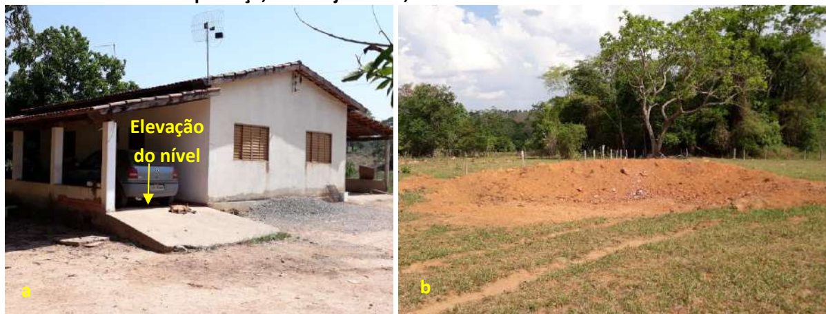
Foto 6.22 – Dispositivos de prevenção dos danos provocados pelas águas em residência (a) e lote (b) da Comunidade Boa Esperança, Piracanjuba-GO, 2018.
