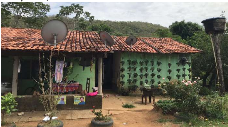
Foto 4.4 – Habitação construída de alvenaria com reboco e pintura, identificada na Comunidade Boa Esperança, Piracanjuba-GO, 2018.
