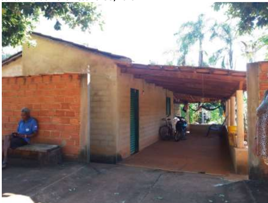
Foto 4.19 – Piso de residência constituído de concreto bruto, identificado na Comunidade de Balbino dos Santos, Santa Rita do Novo Destino-GO, 2019.
