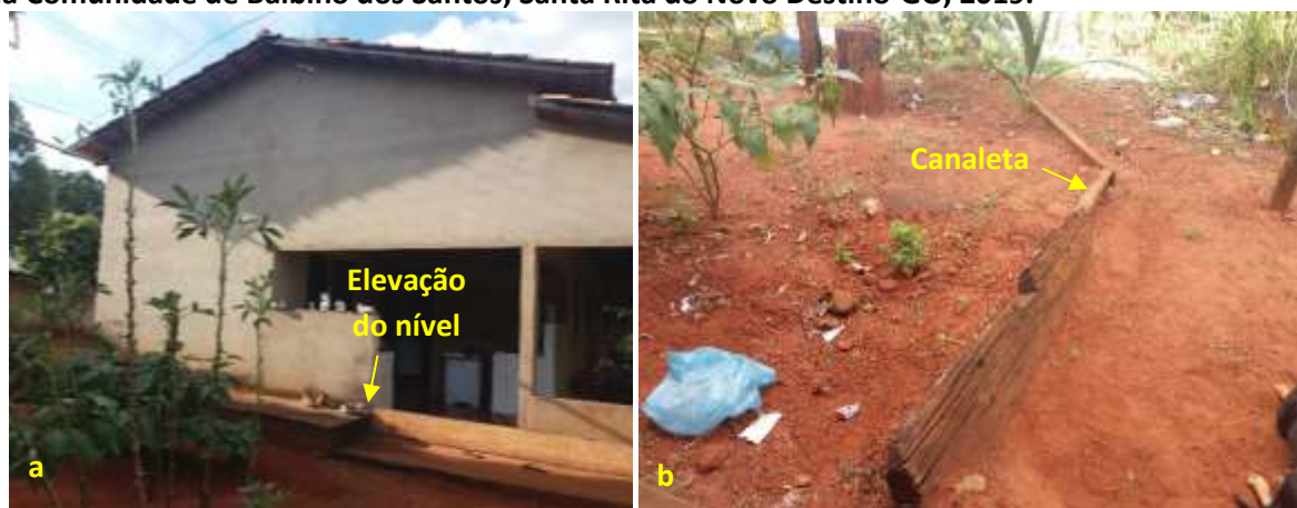
Foto 6.16 – Dispositivos de prevenção dos danos provocados pelas águas em residência (a) e lote (b) da Comunidade de Balbino dos Santos, Santa Rita do Novo Destino-GO, 2019.
