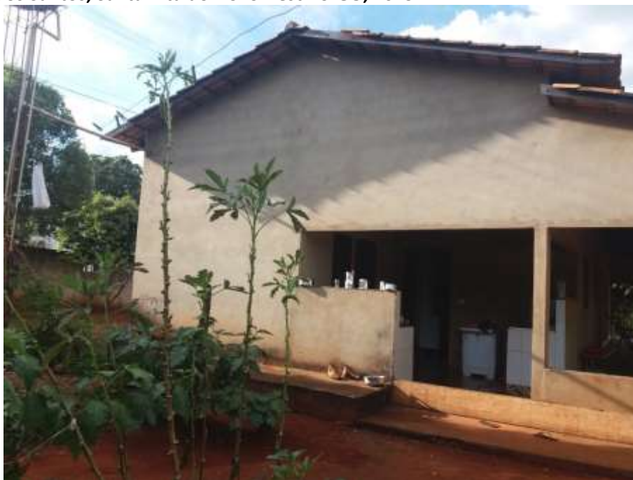
Foto 4.17 – Habitação construída de alvenaria com reboco sem pintura, identificada na Comunidade de Balbino dos Santos, Santa Rita do Novo Destino-GO, 2019.
