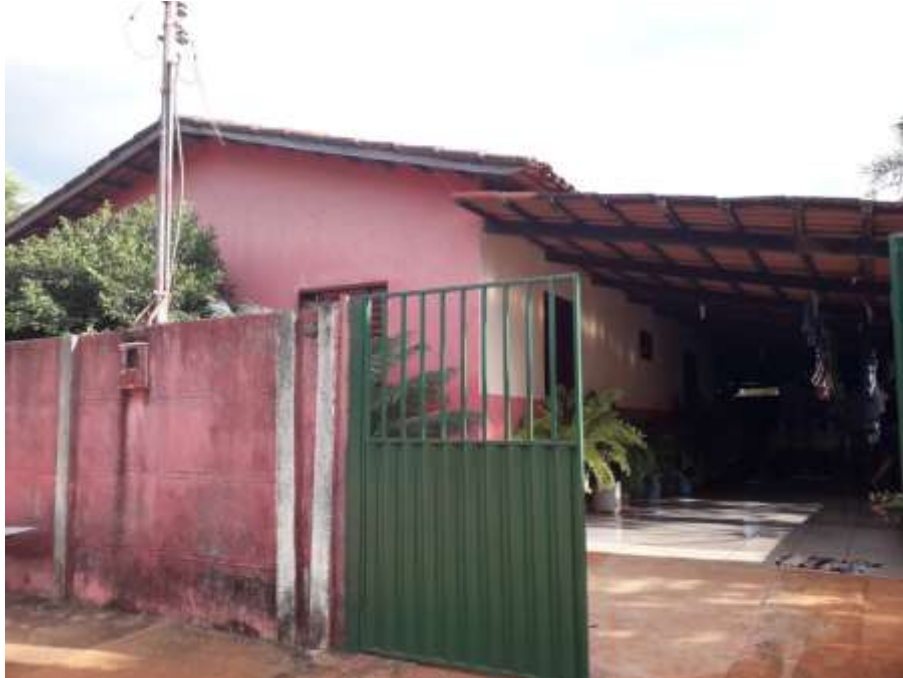
Foto 4.16 – Habitação construída de alvenaria com reboco e pintura, identificada na Comunidade de Balbino dos Santos, Santa Rita do Novo Destino-GO, 2019.
