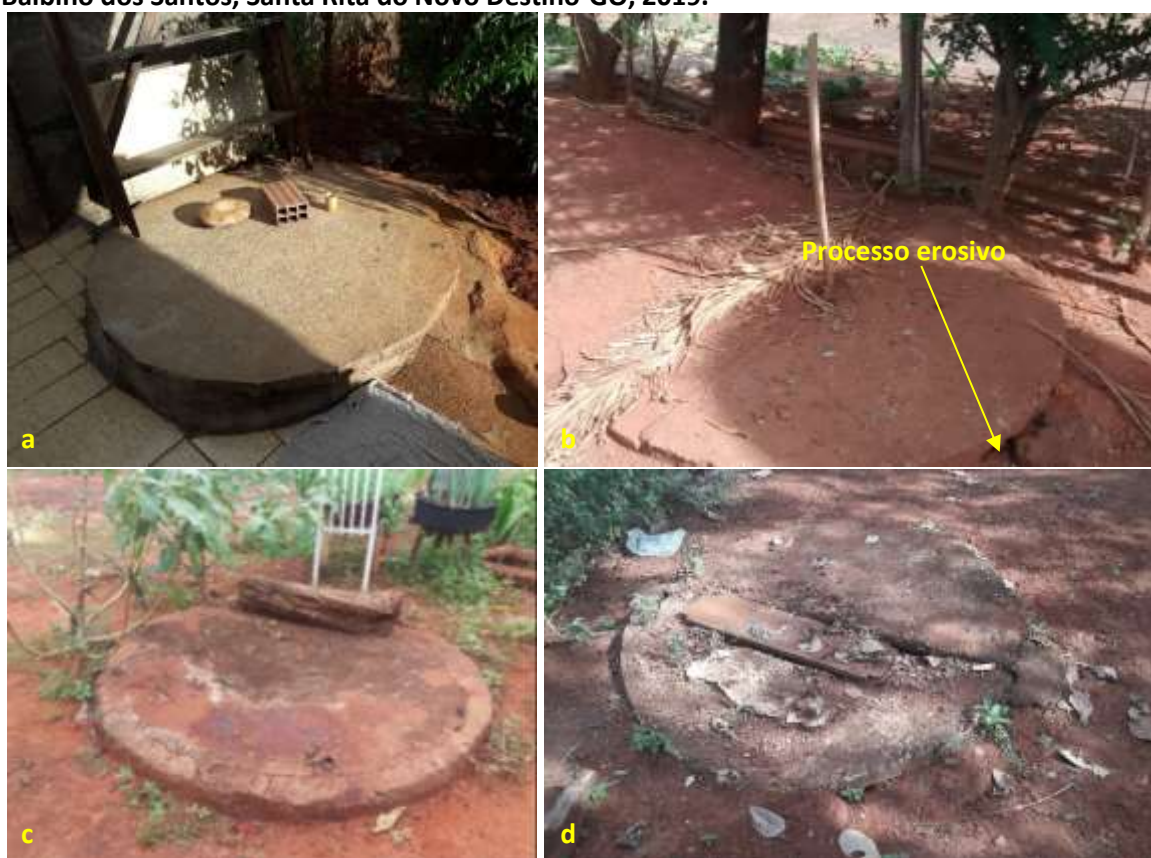
Foto 6.3 – Situações construtivas das fossas negras/rudimentares, com tampa de concreto e tubulação de respiro sem vedação (a) e (b), e sem tubulação de respiro (c) e (d), na Comunidade de Balbino dos Santos, Santa Rita do Novo Destino-GO, 2019.
