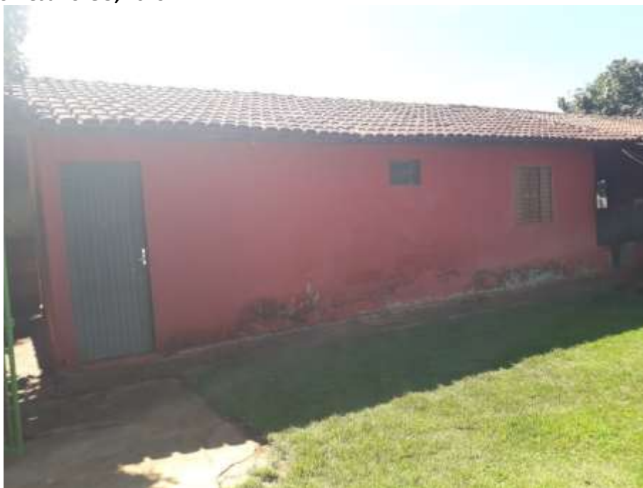
Foto 4.21 – Cobertura de telha de barro, identificada na Comunidade de Balbino dos Santos, Santa Rita do Novo Destino-GO, 2019.
