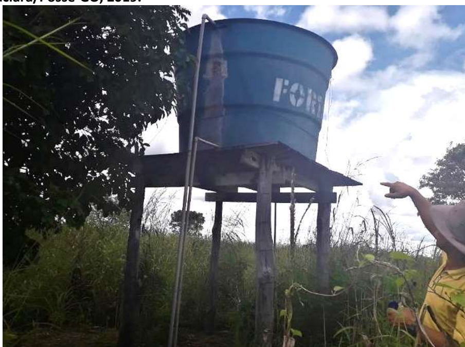
Foto 6.4 – Reservatório coletivo R2, instalado sobre uma estrutura de madeira na Comunidade de Baco Pari, Iaciara/Posse-GO, 2019.
