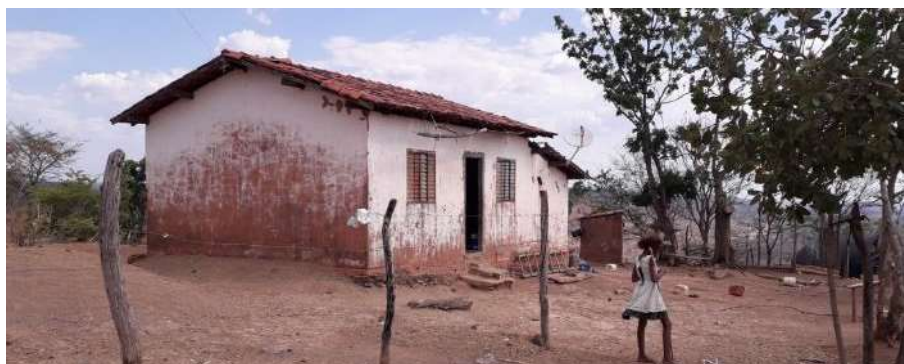
Foto 4.15 – Cobertura de telha de barro, identificada na Comunidade de Baco Pari, Iaciara/Posse-GO, 2019.
