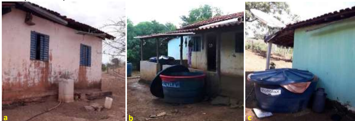
Foto 6.7 – Aproveitamento de forma improvisada de água de chuva na Comunidade de Baco Pari, Iaciara/Posse-GO, 2019.
