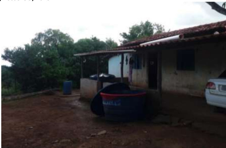
Foto 4.13 – Piso de residência constituído de concreto bruto, identificado na Comunidade de Baco Pari, Iaciara/Posse-GO, 2019.
