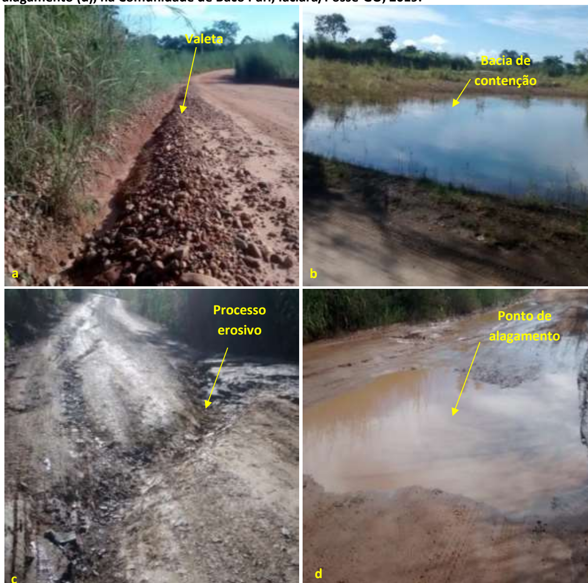
Foto 6.21 – Via de acesso com valeta (a), bacia de contenção (b), processo erosivo (c) e ponto de alagamento (d), na Comunidade de Baco Pari, Iaciara/Posse-GO, 2019.
