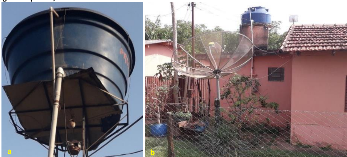
Foto 6.5 – Diferentes tipos de reservatórios domiciliares em polietileno: reservatório domiciliar com tampa amarrada com arame (a) e reservatório do tipo cisterna (b) na Comunidade Arraial da Ponte, Água Limpa-GO, 2018.
