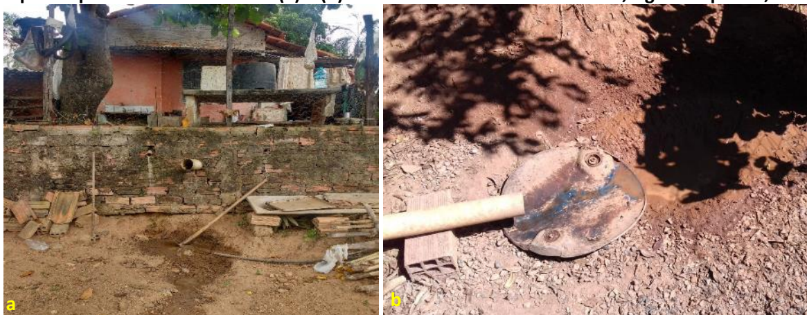
Foto 6.9 – Lançamento e acúmulo de água cinza proveniente da pia da cozinha diretamente no solo do quintal próximo aos domicílios (a) e (b) na Comunidade Arraial da Ponte, Água Limpa-GO, 2018.
