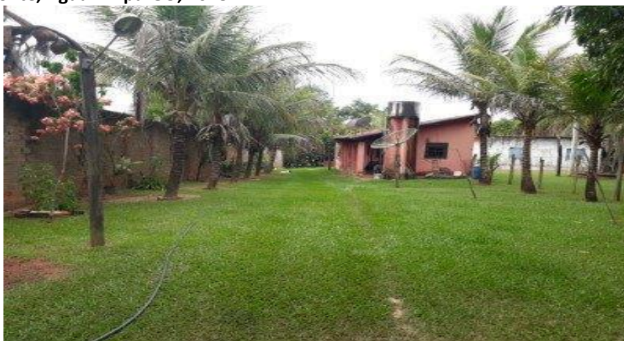
Foto 4.3 – Habitação construída de alvenaria com reboco e pintura, identificada na Comunidade Arraial da Ponte, Água Limpa-GO, 2018.
