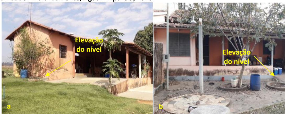
Foto 6.21 – Dispositivos de prevenção dos danos provocados pelas águas nas residências da Comunidade Arraial da Ponte, Água Limpa-GO, 2018.
