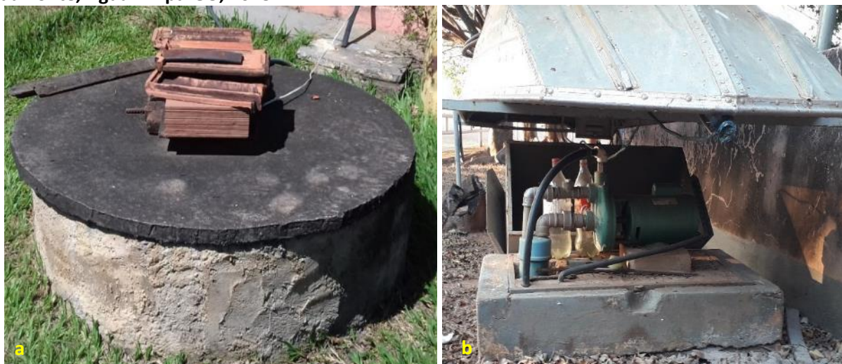
Foto 6.2 – Tipos de SAI utilizados: poço raso escavado (a) e poço tubular raso (b), Comunidade Arraial da Ponte, Água Limpa-GO, 2018.
