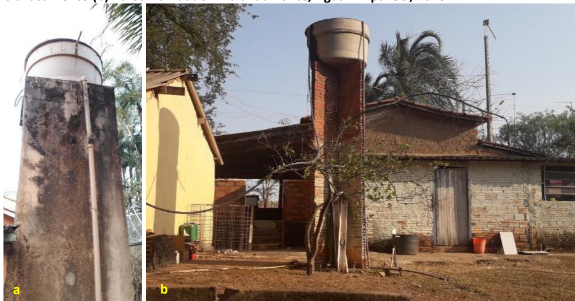
Foto 6.4 – Reservatório de fibrocimento com presença de extravasor (a) e outro com sinais de extravasamento (b) na Comunidade Arraial da Ponte, Água Limpa-GO, 2018.
