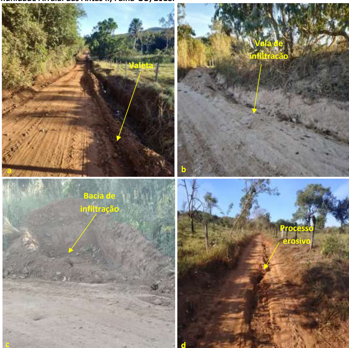
Foto 6.16 – Valeta (a), vala de infiltração (b), bacia de infiltração (c) e processo erosivo (d) na Comunidade Arraial das Antas II, Faina-GO, 2018.
