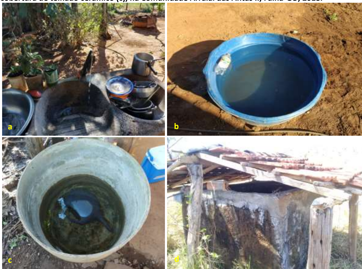
Foto 6.4 – Pontos de consumo de água externos ao domicílio: mangueira de polietileno vinda diretamente da captação (a), reservatório de polietileno sem tampa apoiado no solo (b), reservatório de cimento amianto sem tampa apoiado no solo (c) e reservatório de concreto com cobertura de telhado cerâmico (c), na Comunidade Arraial das Antas II, Faina-GO, 2018.
