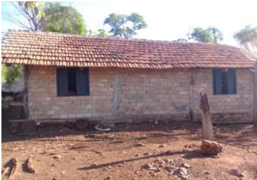
Foto 4.5 – Cobertura de telha de barro, identificado na Comunidade Arraial das Antas II, Faina-GO, 2018.
