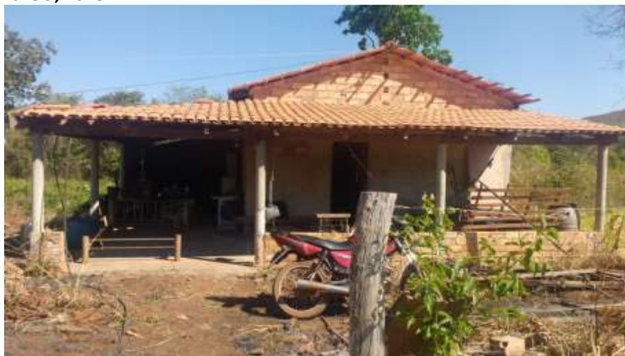
Foto 4.2 – Habitação construída de alvenaria sem reboco, identificada na Comunidade Arraial das Antas II, Faina-GO, 2018.
