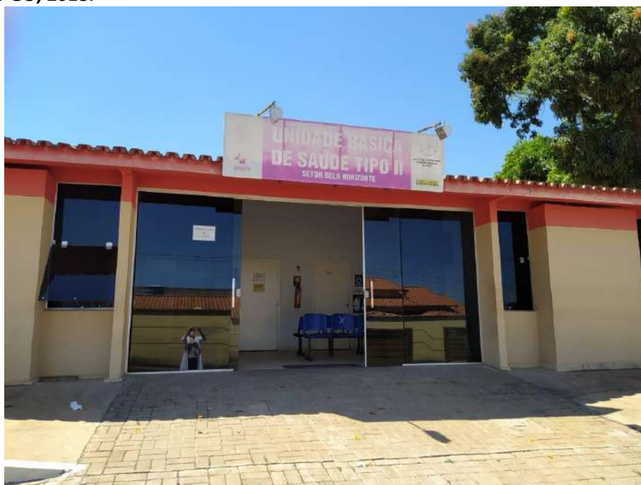
Foto 5.1 – Vista externa da UBS Tipo II Setor Belo Horizonte, referência da Comunidade Aranha, Niquelândia-GO, 2018.
