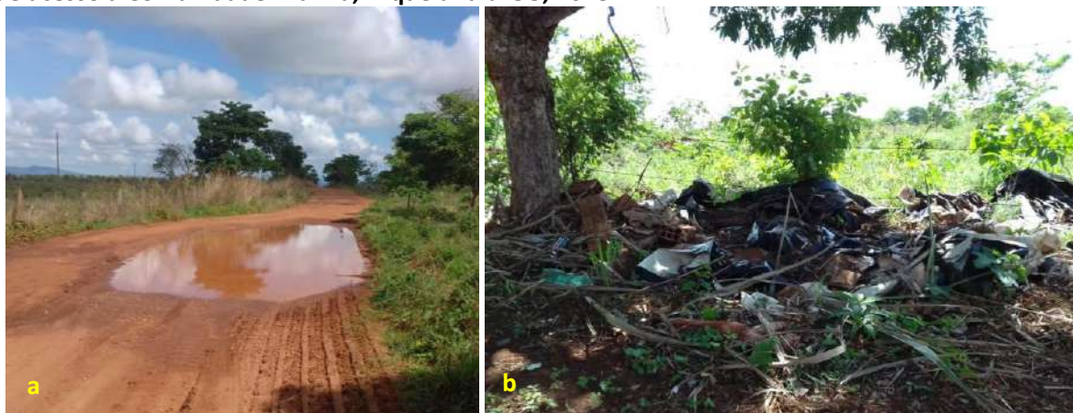
Foto 6.16 – Ponto de alagamento (a) e ponto de descarte de resíduos sólidos (b) na margem da via de acesso à Comunidade Aranha, Niquelândia-GO, 2018.
