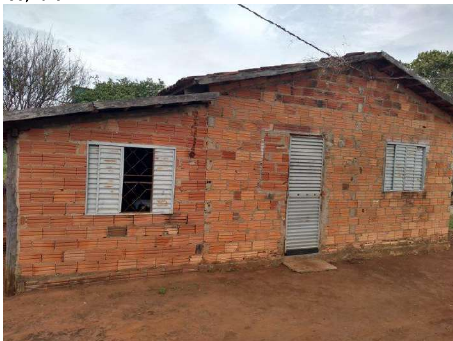
Foto 4.5 – Habitação construída de alvenaria sem reboco, identificada na Comunidade Aranha, Niquelândia-GO, 2018.
