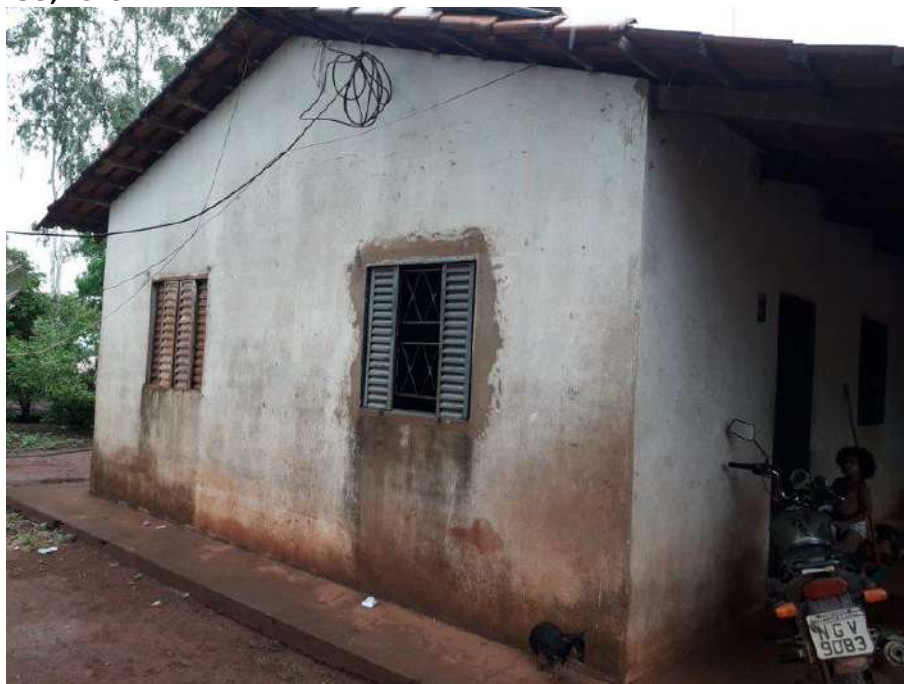
Foto 4.6 – Habitação construída de alvenaria com reboco, identificada na Comunidade Aranha, Niquelândia-GO, 2018.
