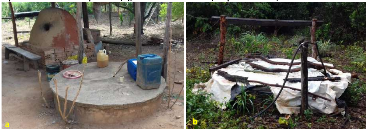
Foto 6.5 – Poço raso escavado com tampa de concreto (a) e poço raso escavado com tampa improvisada de lona de plástico (b), Comunidade Aranha, Niquelândia-GO, 2018.
