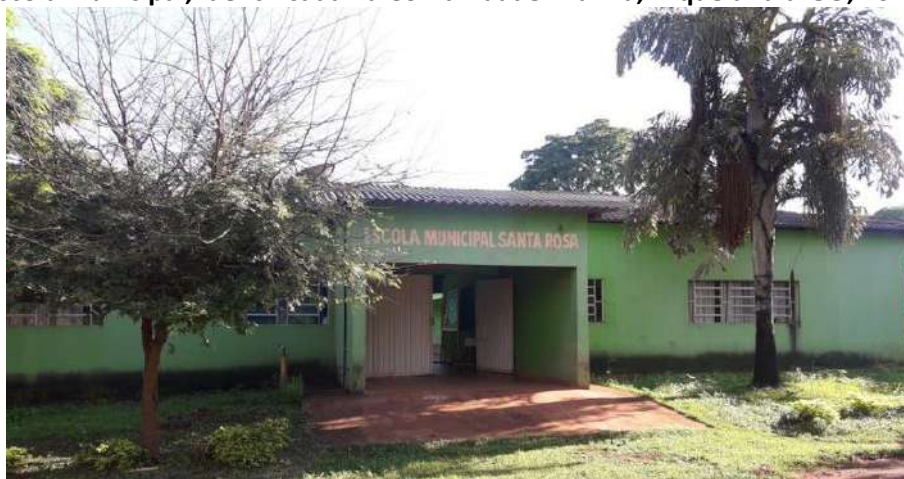
Foto 4.1 – Escola municipal, identificada na Comunidade Aranha, Niquelândia-GO, 2018.
