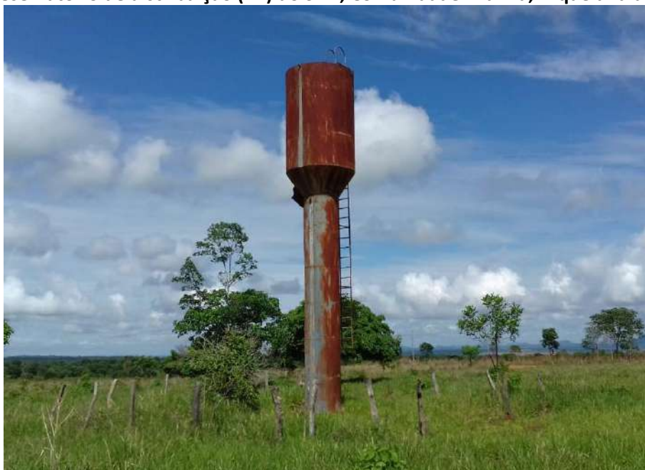
Foto 6.3 – Reservatório de distribuição (R1) do SAA, Comunidade Aranha, Niquelândia-GO, 2018.
