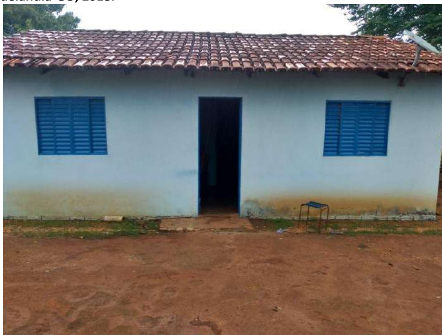
Foto 4.7 – Habitação construída de alvenaria com reboco e pintura, identificada na Comunidade Aranha, Niquelândia-GO, 2018.
