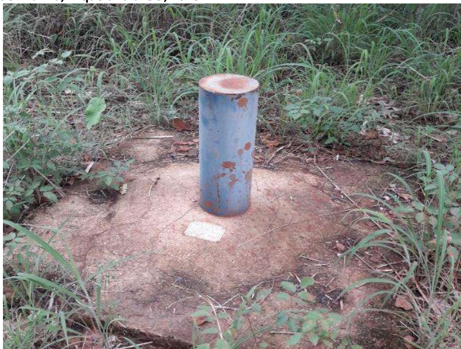
Foto 6.2 – Poço tubular profundo desativado do Sistema de Abastecimento de Água (SAA), Comunidade Aranha, Niquelândia-GO, 2018.
