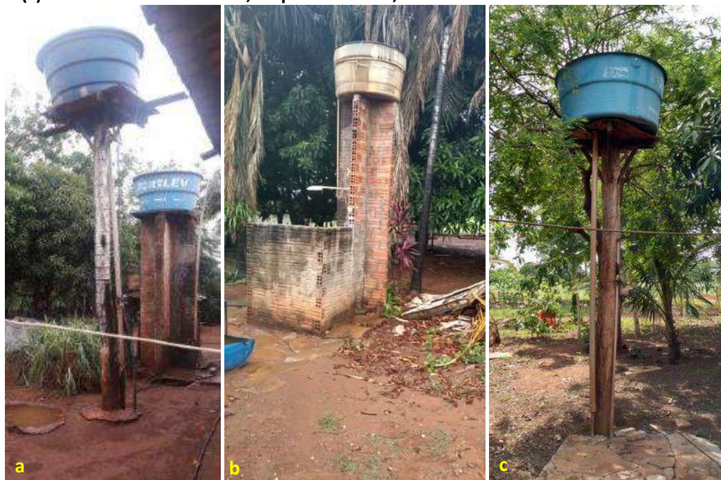
Foto 6.6 – Unidade familiar dotada de dois reservatórios (a), reservatório em fibrocimento instalado sobre estrutura de alvenaria (b) e reservatório em fibra de vidro instalado sobre estrutura de madeira (c) na Comunidade Aranha, Niquelândia-GO, 2018.
