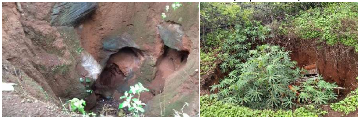
Foto 6.19 – Processos erosivos em lotes da Comunidade Aranha, Niquelândia-GO, 2018.
