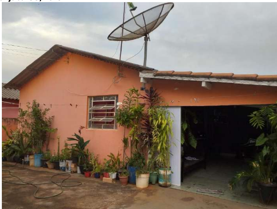
Foto 4.1 – Habitação construída de alvenaria com reboco e pintura, identificada na Comunidade Ana Laura, Piracanjuba-GO, 2019.
