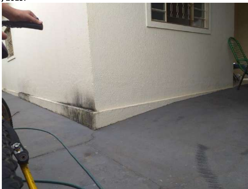
Foto 4.3 – Piso de residência constituído de concreto bruto, identificado na Comunidade Ana Laura, Piracanjuba-GO, 2019.
