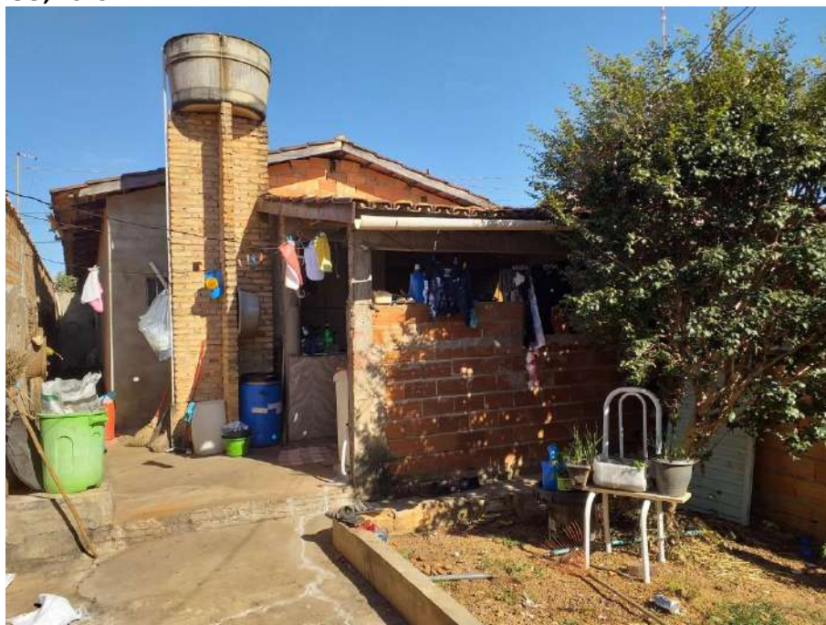
Foto 4.2 – Habitação construída de alvenaria sem reboco, identificada na Comunidade Ana Laura, Piracanjuba-GO, 2019.
