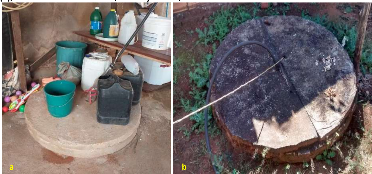
Foto 6.1 – Poço raso escavado com mureta de proteção, calçado ao redor e tampado com tampa de concreto (a), e outro com mureta de proteção sem revestimento e sem calçamento ao redor do poço (b), na Comunidade Ana Laura, Piracanjuba-GO, 2019.
