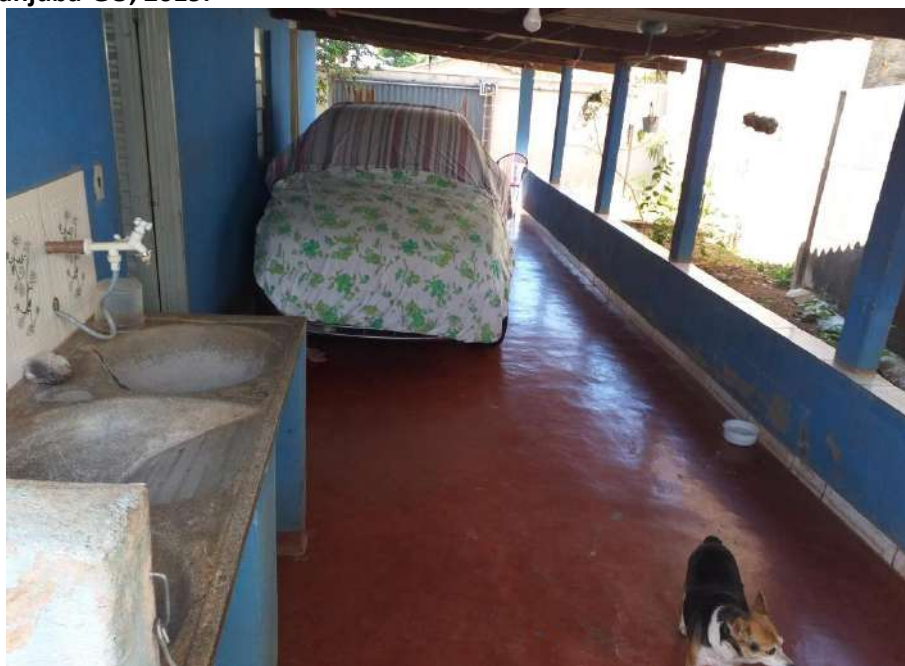
Foto 4.5 – Piso de residência constituído de cimento queimado, identificado na Comunidade Ana Laura, Piracanjuba-GO, 2019.
