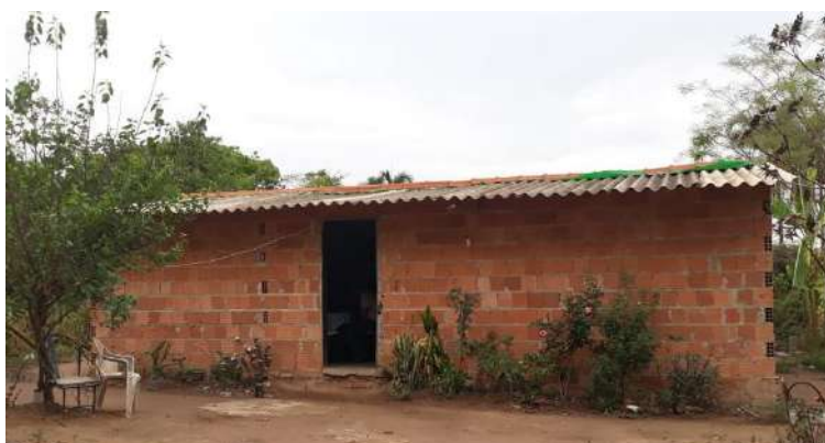
Foto 4.10 – Cobertura do tipo fibrocimento, identificada na Comunidade dos Almeidas, Silvânia-GO, 2018.
