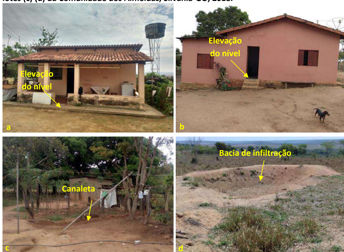
Foto 6.27 – Dispositivos de prevenção dos danos provocados pelas águas nas residências (a) (b) e nos lotes (c) (d) da Comunidade dos Almeidas, Silvânia-GO, 2018.
