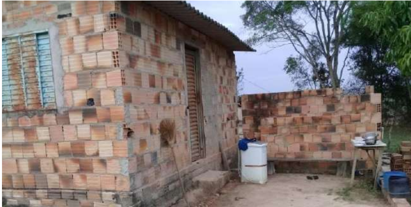
Foto 4.3 – Habitação construída de alvenaria sem reboco, identificada na Comunidade dos Almeidas, Silvânia-GO, 2018.
