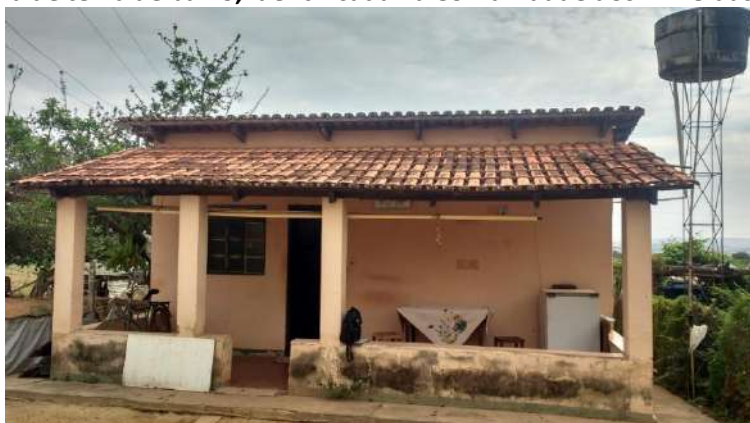
Foto 4.9 – Cobertura de telha de barro, identificada na Comunidade dos Almeidas, Silvânia-GO, 2018.
