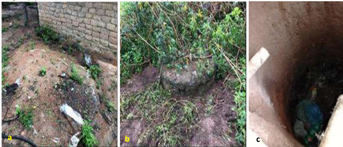
Foto 6.15 – Exemplo de fossas rudimentares com resíduos sólidos nas imediações (a), presença de vegetação (b) e de resíduos sólidos no interior (c), na Comunidade dos Almeidas, Silvânia-GO, 2018.
