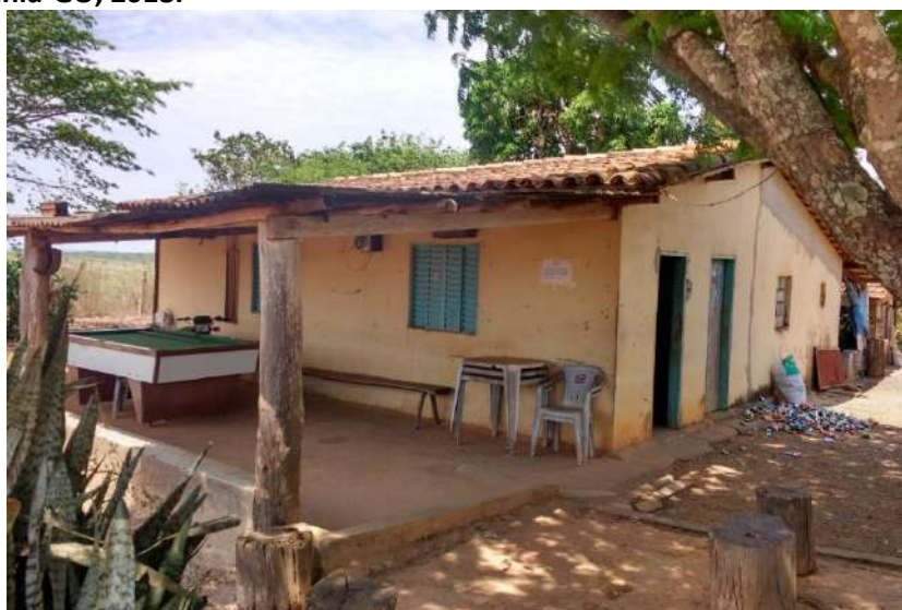
Foto 4.6 – Piso de residência constituído de concreto bruto, identificado na Comunidade dos Almeidas, Silvânia-GO, 2018.
