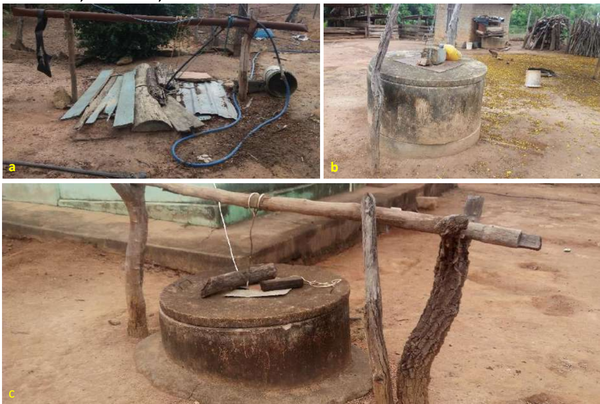
Foto 6.9 – Mecanismos de proteção utilizados nos poços rasos escavado: poço tampado com materiais improvisados (a), com tampa e mureta em concreto (b) e calçamento (c), na Comunidade dos Almeidas, Silvânia-GO, 2018.
