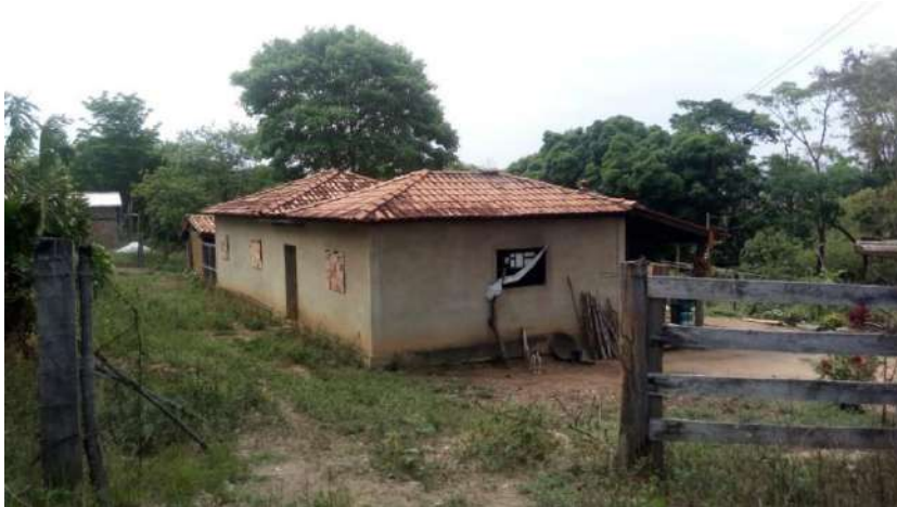
Foto 4.4 – Habitação construída de alvenaria com reboco, identificada na Comunidade dos Almeidas, Silvânia-GO, 2018.
