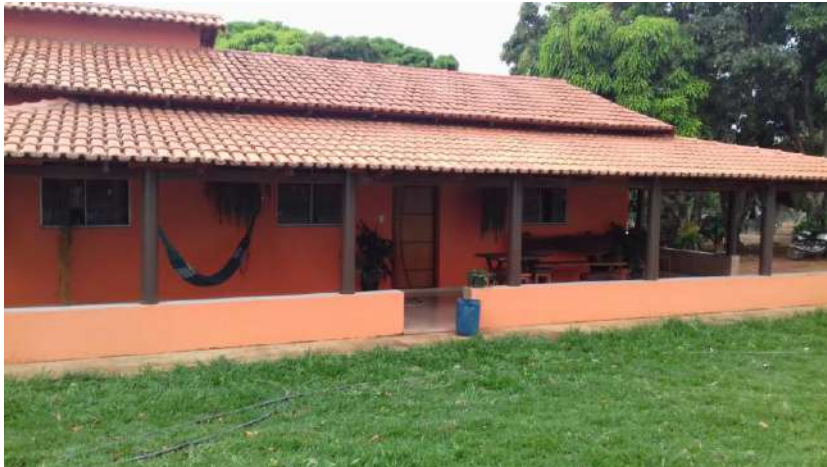
Foto 4.5 – Habitação construída de alvenaria com reboco e pintura, identificada na Comunidade dos Almeidas, Silvânia-GO, 2018.
