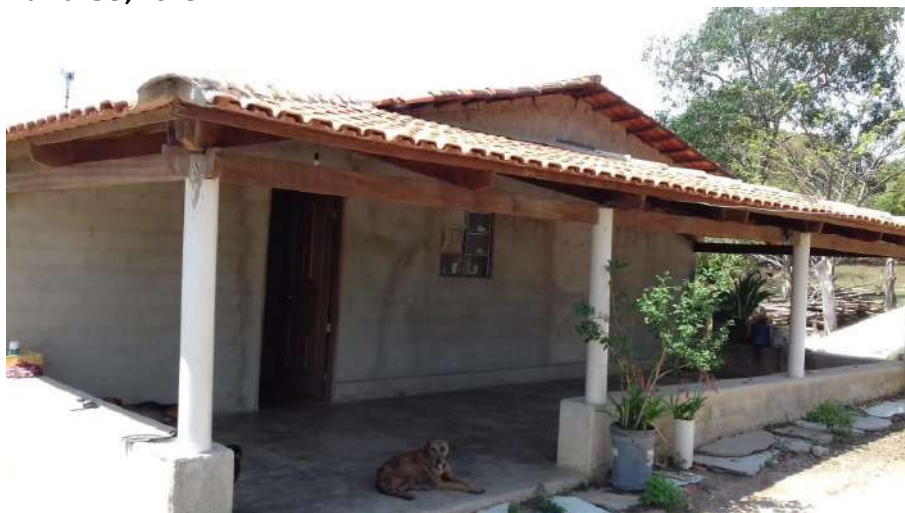
Foto 4.7 – Piso de residência constituído de cimento queimado, identificado na Comunidade dos Almeidas, Silvânia-GO, 2018.
