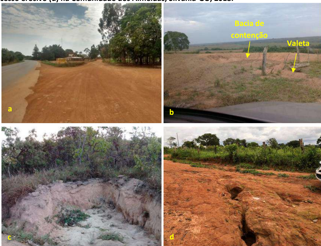
Foto 6.24 – Via de acesso (a); valeta e bacia de contenção (b); vala de infiltração (c); e exemplo de processo erosivo (d) na Comunidade dos Almeidas, Silvânia-GO, 2018.
