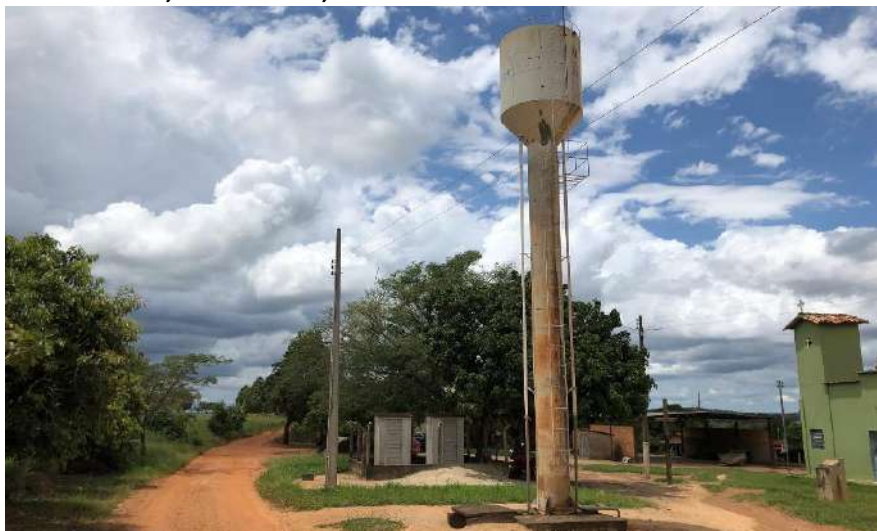
Foto 6.3 – Reservatório elevado R1, localizado em uma área sem muros, cercas ou portões, na Comunidade dos Almeidas, Silvânia-GO, 2018.
