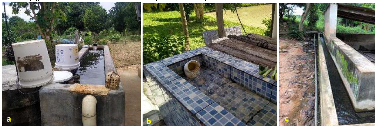
Foto 6.8 – Água corrente, em uma estrutura de alvenaria, para o uso humano (a e b) e dessedentação animal (c), na Comunidade dos Almeidas, Silvânia-GO, 2018.
