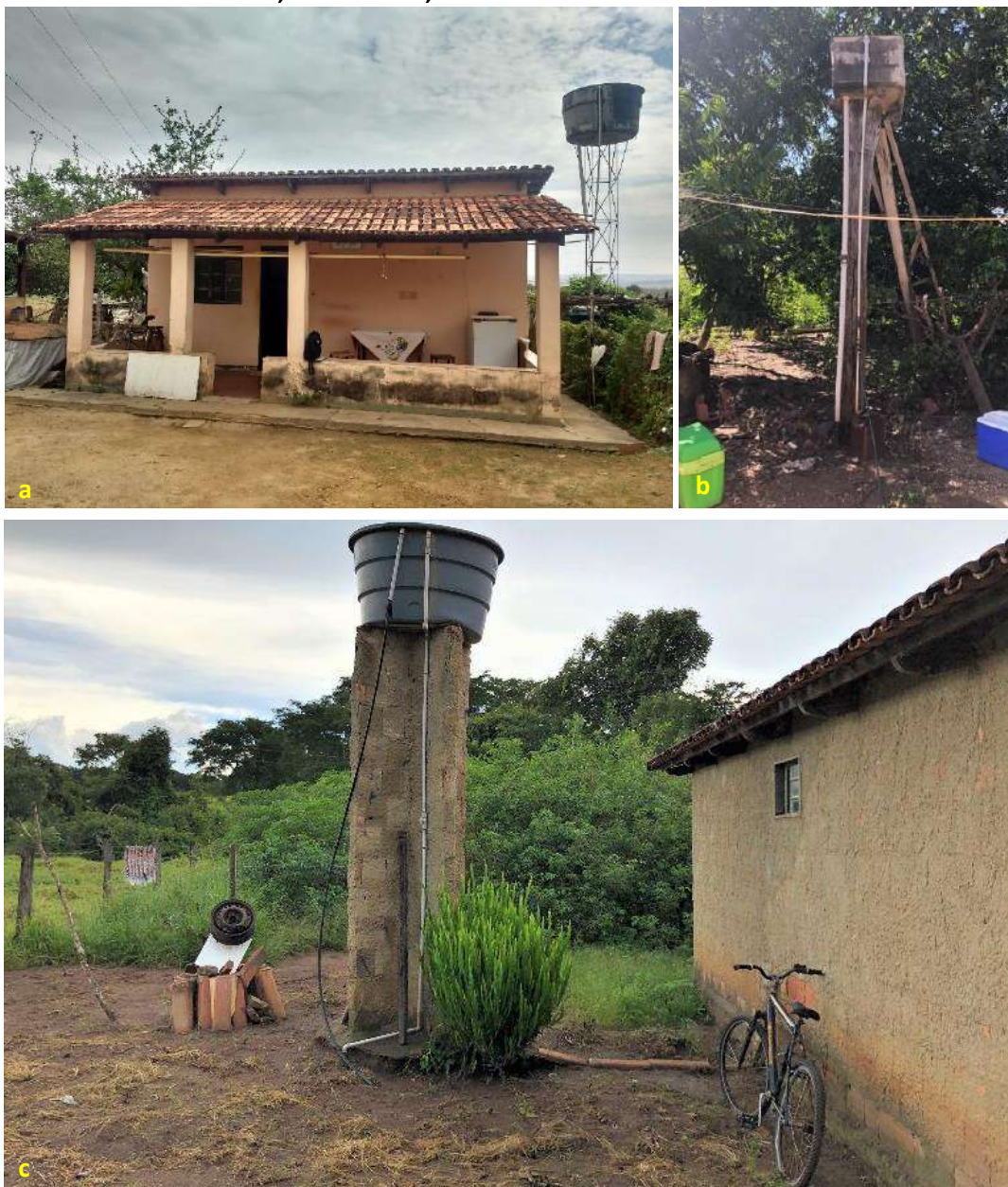
Foto 6.12 – Reservatórios em fibrocimento instalados sobre uma estrutura metálica (a), sobre estrutura de madeira (b), e um reservatório em polietileno instalado sobre estrutura de alvenaria (c) na Comunidade dos Almeidas, Silvânia-GO, 2018.
