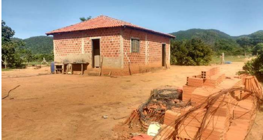
Foto 4.7 – Cobertura de telha de barro, identificada nas habitações da Comunidade Água Quente, Minaçu-GO, 2018.
