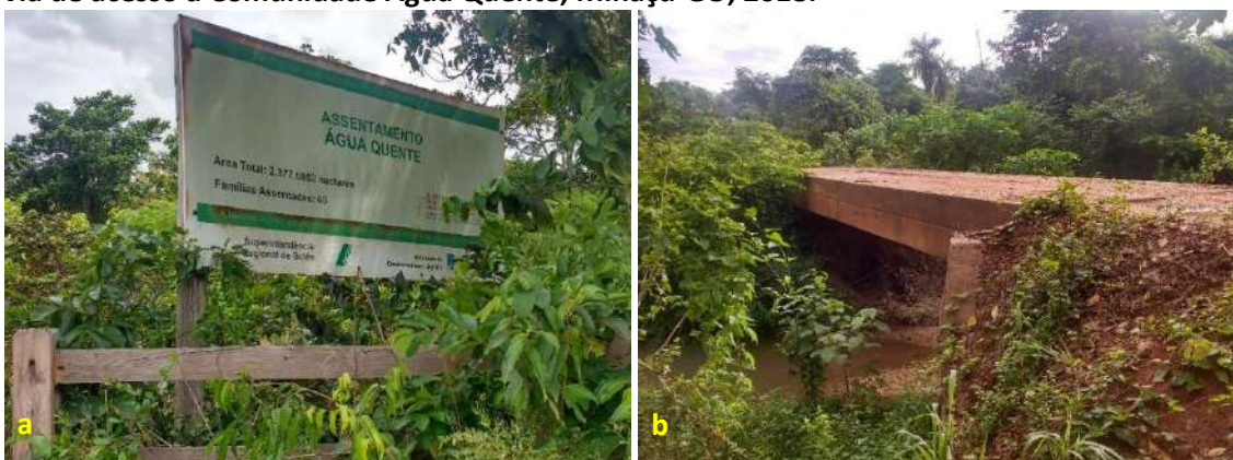
Foto 6.16 – Placa sinalizando a comunidade (a) e a estrutura de passagem sobre o fundo de vale (b), na via de acesso à Comunidade Água Quente, Minaçu-GO, 2018.
