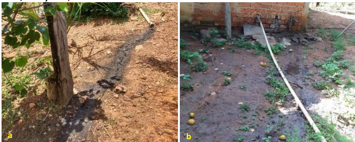
Foto 6.9 – Lançamento e acúmulo de água cinza proveniente da pia da cozinha e/ou do tanque de lavar roupas diretamente no solo do quintal próximo aos domicílios (a) e (b), na Comunidade Água Quente, Minaçu-GO, 2018.
