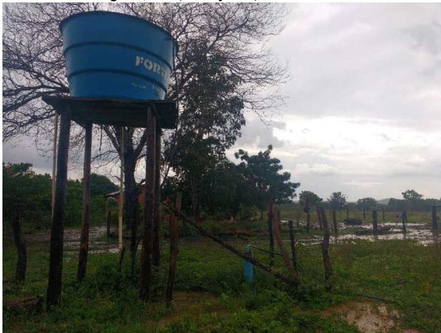
Foto 6.3 – Poço tubular profundo e reservatório do SAA 2 responsável por abastecer o núcleo comunitário da Comunidade Água Quente, Minaçu-GO, 2018.
