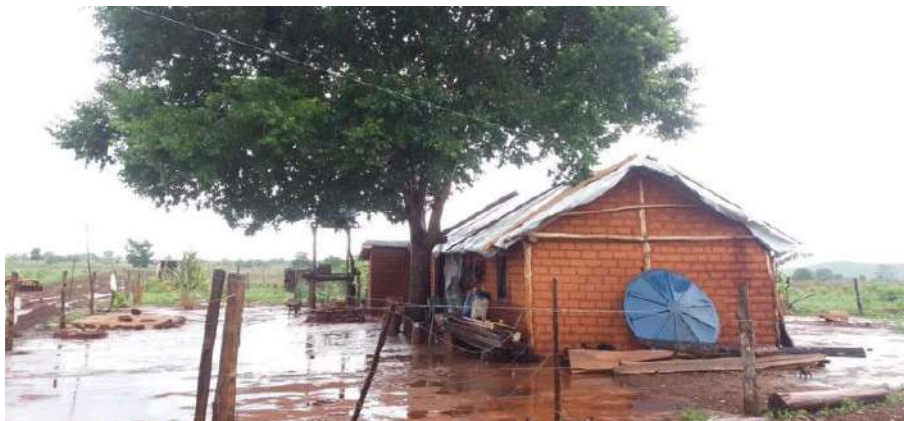
Foto 4.6 – Habitação construída de adobe, identificada na Comunidade Água Quente, Minaçu-GO, 2018.
