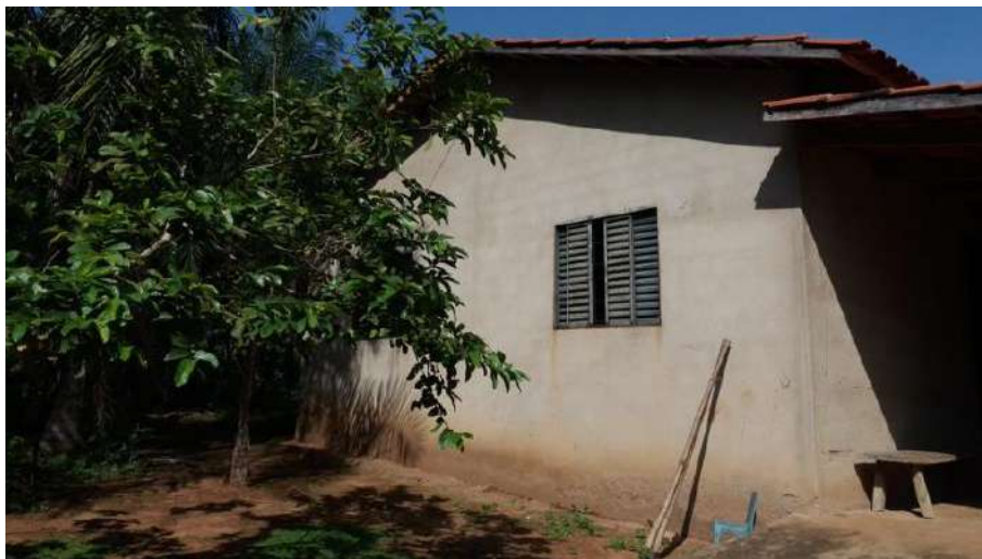
Foto 4.5 – Habitação construída de alvenaria com reboco, identificada na Comunidade Água Quente, Minaçu-GO, 2018.
