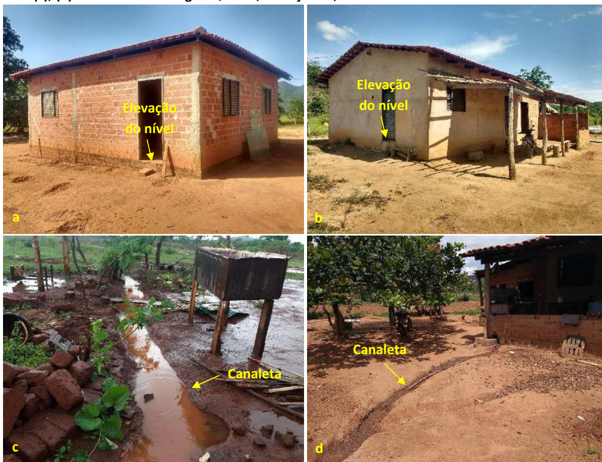
Foto 6.22 – Dispositivos de prevenção dos danos provocados pelas águas em residências (a), (b) e lotes (c), (d) da Comunidade Água Quente, Minaçu-GO, 2018.
