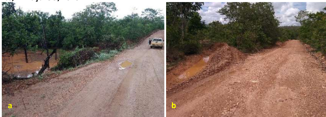
Foto 6.17 – Bacia de contenção (a) e vala de infiltração (b) na via de acesso à Comunidade Água Quente, Minaçu-GO, 2018.
