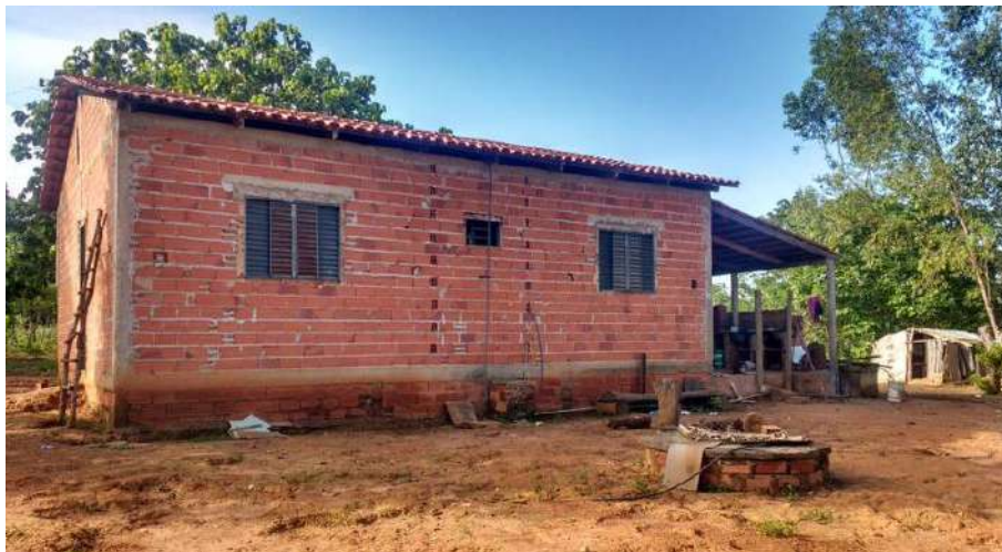
Foto 4.4 – Habitação construída de alvenaria sem reboco, identificada na Comunidade Água Quente, Minaçu-GO, 2018.
