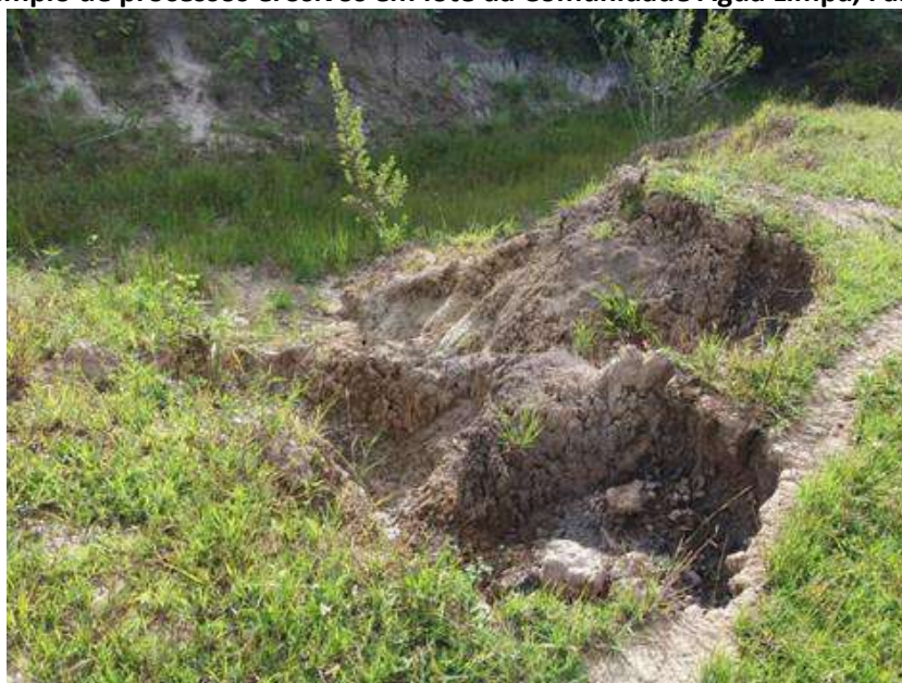
Foto 6.24 – Exemplo de processos erosivos em lote da Comunidade Água Limpa, Faina-GO, 2019.
