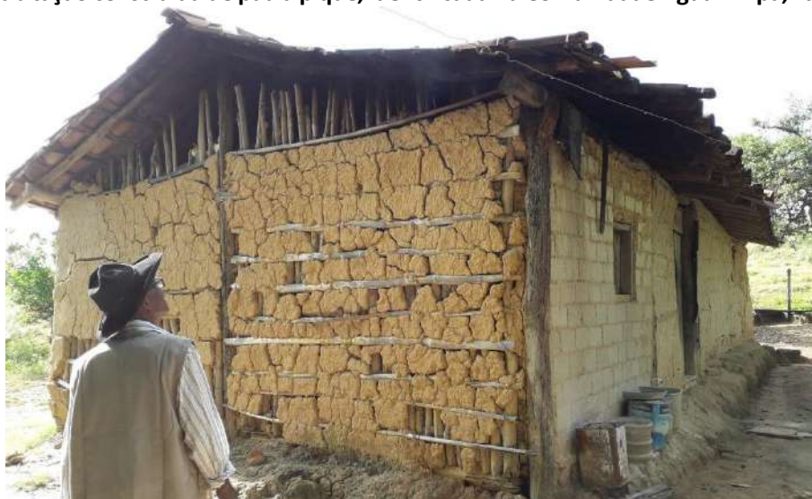
Foto 4.5 – Habitação construída de pau a pique, identificada na Comunidade Água Limpa, Faina-GO, 2019.
