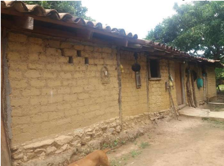
Foto 4.3 – Habitação construída de adobe, identificada na Comunidade Água Limpa, Faina-GO, 2019.
