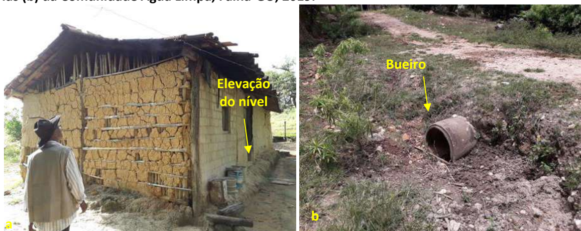
Foto 6.23 – Dispositivos de prevenção dos danos provocados pelas águas nas residências (a) e nas vias (b) da Comunidade Água Limpa, Faina-GO, 2019.
