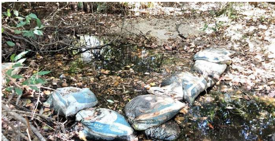
Foto 6.5 – Represamento de manancial realizado por meio de sacos de areia, na Comunidade Água Limpa, Faina-GO, 2019.
