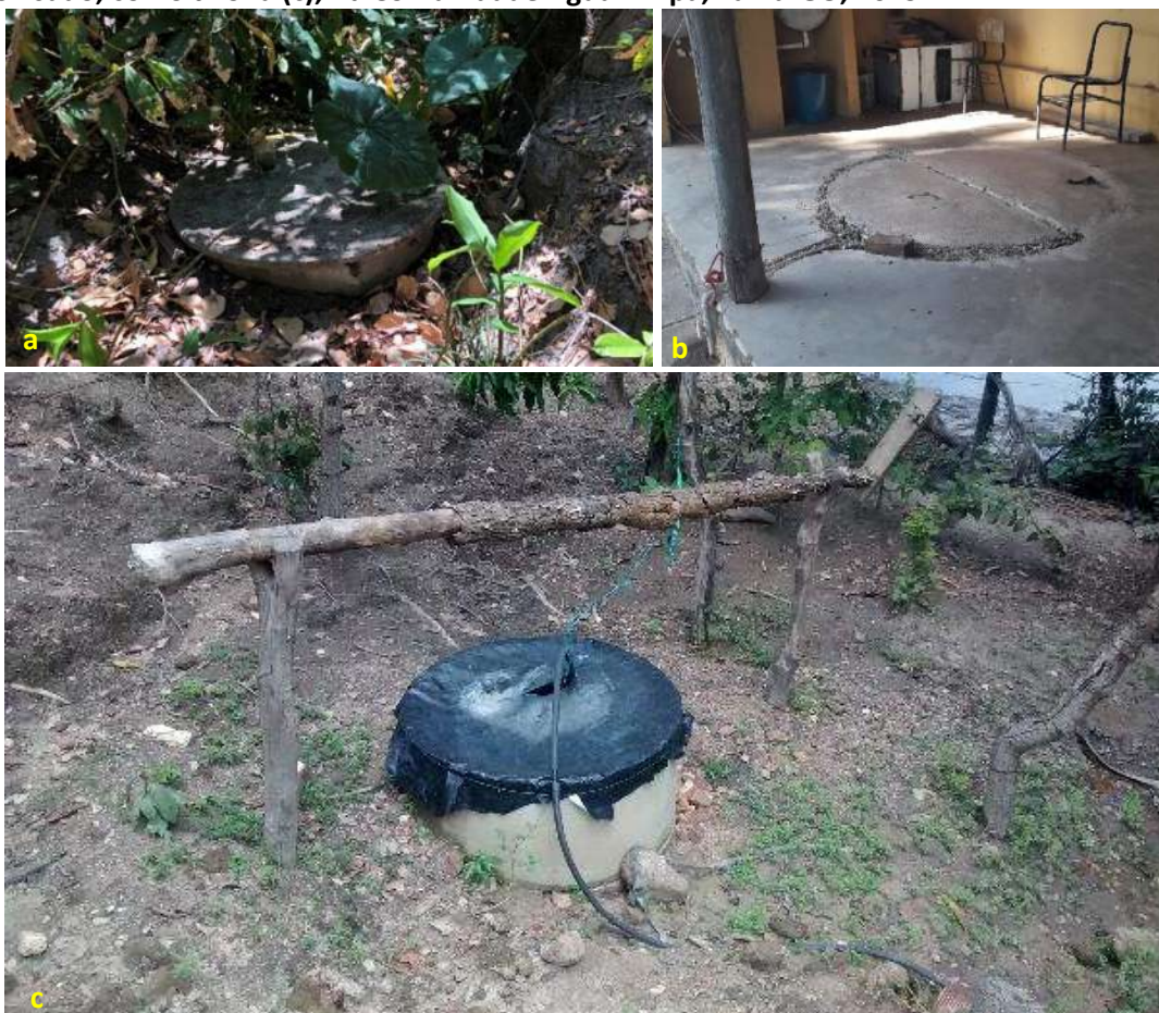
Foto 6.4 – Sistema drenante considerado como poço raso escavado feito com tubulação e tampa em concreto (a), além de poço raso escavado protegido por tampa de concreto (b) ou em material improvisado, como a lona (c), na Comunidade Água Limpa, Faina-GO, 2019.
