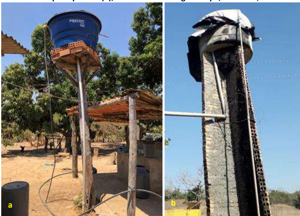
Foto 6.6 – Reservatório domiciliar em polietileno com extravasor e tampa amarrada (a), e em fibrocimento com tampa improvisada (b), na Comunidade Água Limpa, Faina-GO, 2019.
