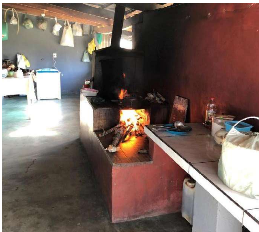
Foto 4.6 – Piso de residência constituído de cimento queimado, identificado na Comunidade Água Limpa, Faina-GO, 2019.
