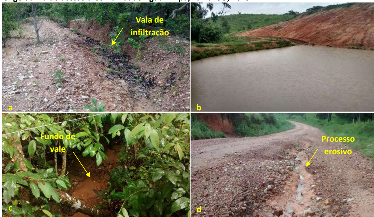
Foto 6.20 – Vala de infiltração (a), bacia de contenção (b), fundo de vale (c) e processo erosivo (d) ao longo da via de acesso à Comunidade Água Limpa, Faina-GO, 2019.
