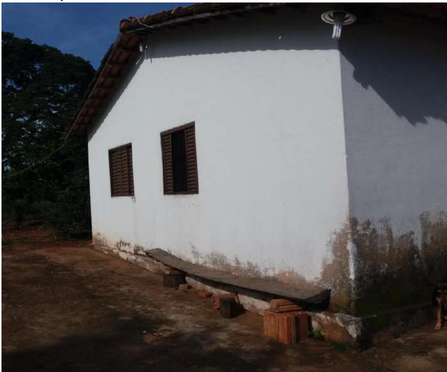
Foto 4.4 – Habitação construída de alvenaria com reboco e pintura, identificada na Comunidade Água Limpa, Faina-GO, 2019.
