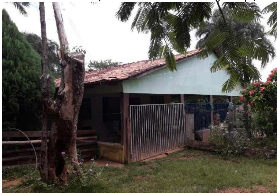
Foto 4.8 – Cobertura de telha de barro, identificada na Comunidade Água Limpa, Faina-GO, 2019.
