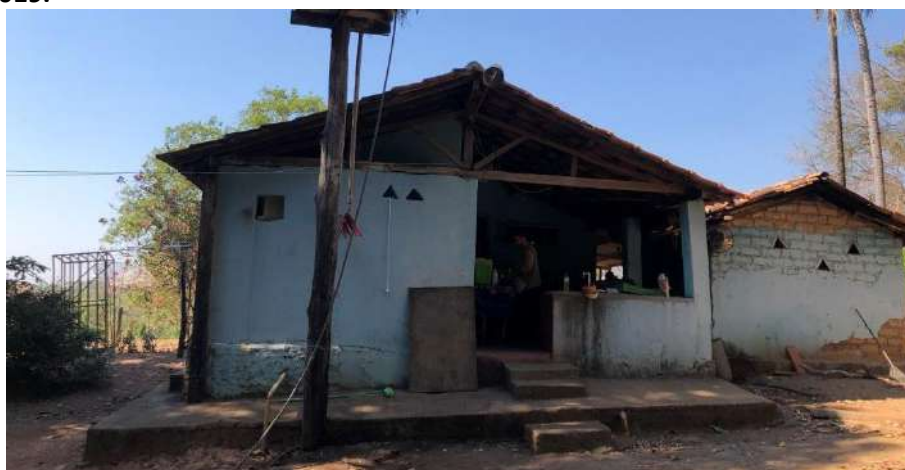
Foto 4.7 – Piso de residência constituído de concreto bruto, identificado na Comunidade Água Limpa, Faina-GO, 2019.
