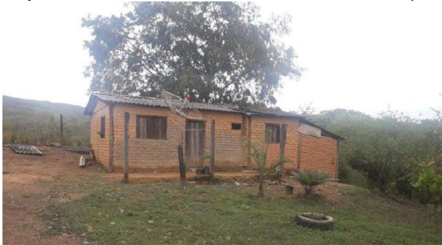
Foto 4.7 – Habitação construída de adobe, identificada na Comunidade Acaba Vida, Niquelândia-GO, 2018.
