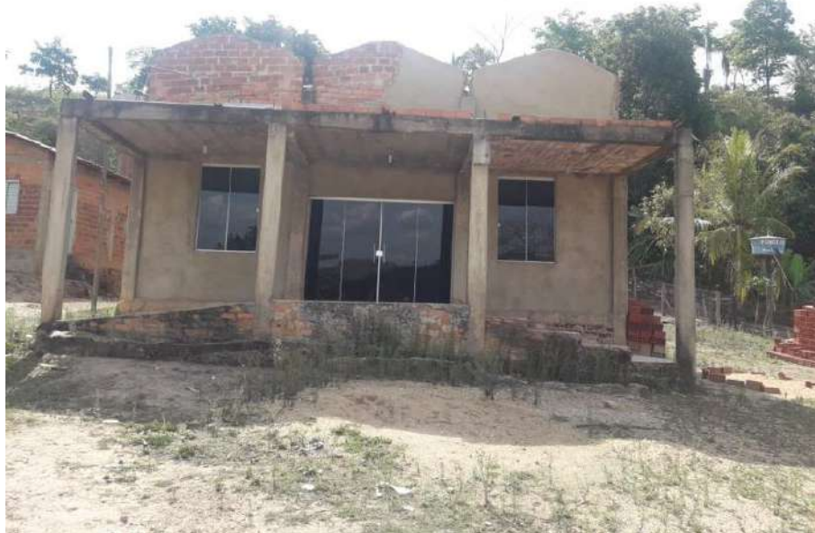
Foto 4.1 – Escola estadual em construção, identificada na Comunidade Acaba Vida, Niquelândia-GO, 2018.
