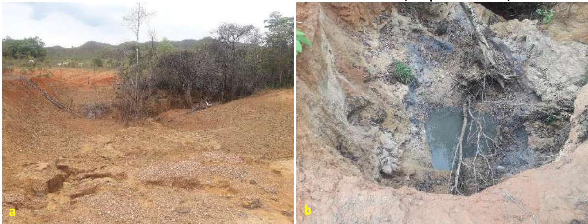
Foto 6.23 – Processos erosivos em lotes da Comunidade Acaba Vida, Niquelândia-GO, 2018.
