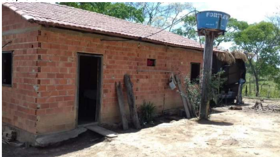
Foto 4.12 – Cobertura de telha de barro, identificada nas habitações da Comunidade Acaba Vida, Niquelândia-GO, 2018.
