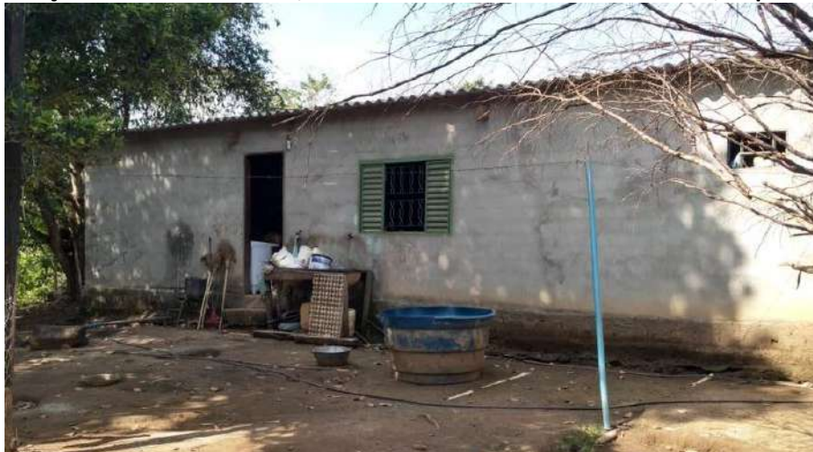
Foto 4.8 – Habitação construída de adobe, identificada na Comunidade Acaba Vida, Niquelândia-GO, 2018.
