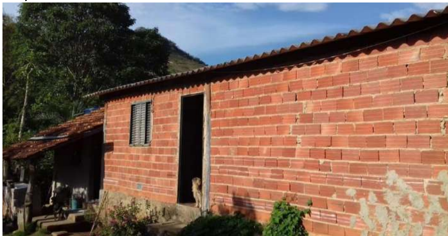
Foto 4.6 – Habitação construída de alvenaria sem reboco, identificada na Comunidade Acaba Vida, Niquelândia-GO, 2018.
