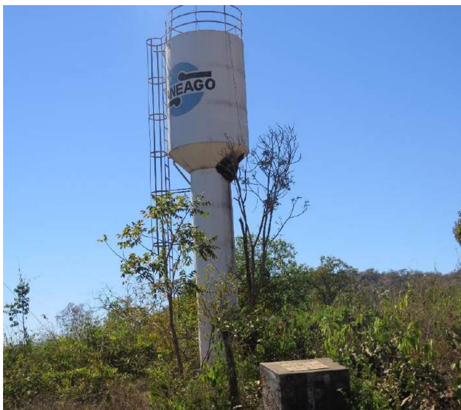
Foto 6.3 – Reservatório de distribuição de água do SAA da Comunidade Abobreira, Nova Roma-GO, 2018.
