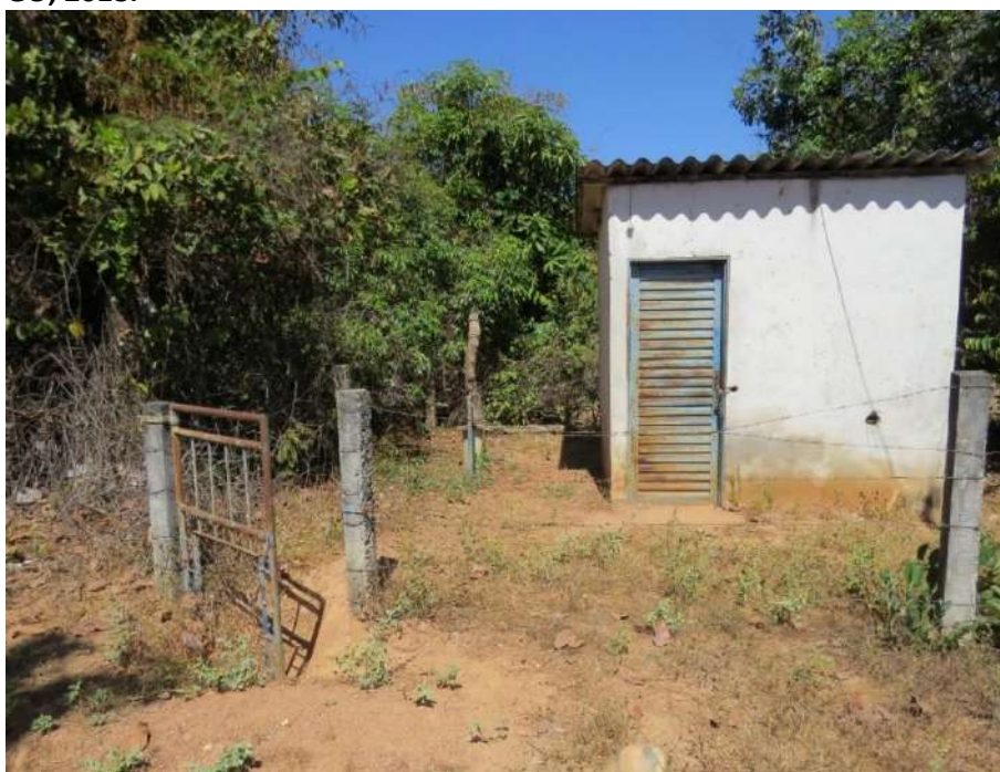
Foto 6.2 – Área de captação do Sistema de abastecimento de Água (SAA) da Comunidade Abobreira, Nova Roma-GO, 2018.
