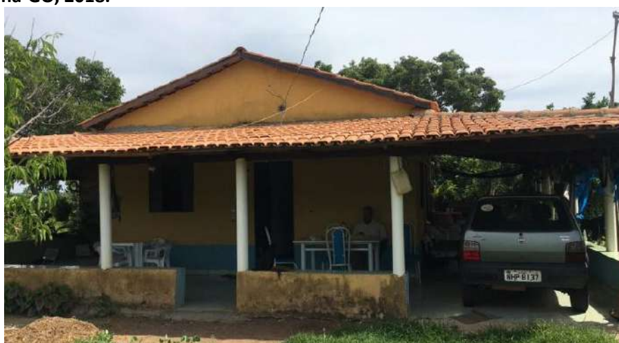
Foto 4.4 – Habitação construída de alvenaria com reboco e pintura, identificada na Comunidade 17 de Abril, Faina-GO, 2018.
