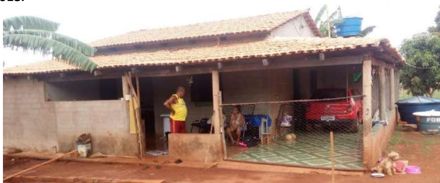
Foto 4.3 – Habitação construída de alvenaria com reboco, identificada na Comunidade 17 de Abril, Faina-GO, 2018.
