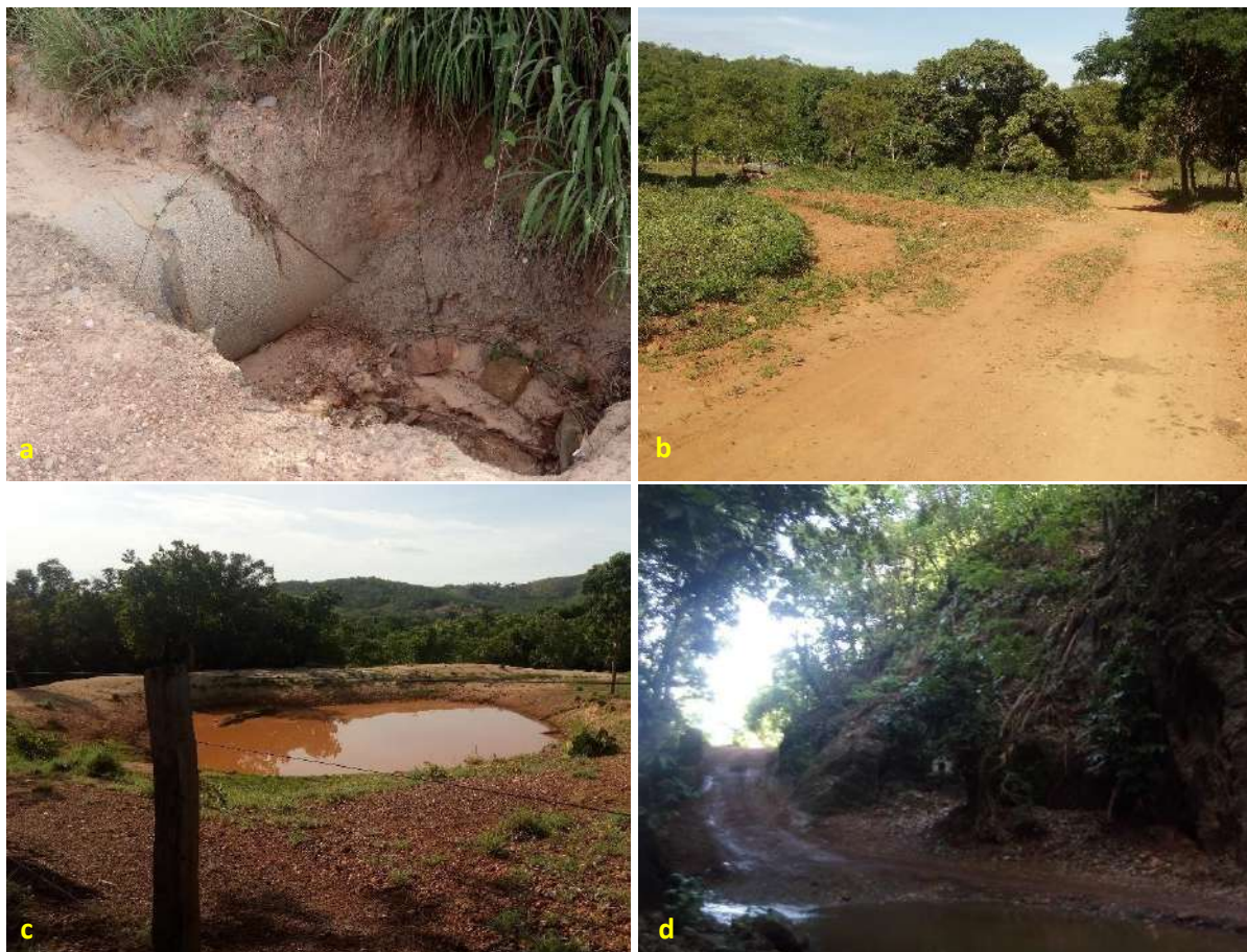
Foto 6.14 – Bueiro (a), valeta de infiltração (b), bacia de contenção (c) e ponto de alagamento (d), na via de acesso à Comunidade 17 de Abril, Faina-GO, 2018.
