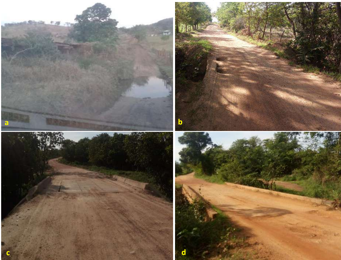
Foto 6.13 – Pontes na via de acesso à Comunidade 17 de Abril, Faina-GO, 2018.
