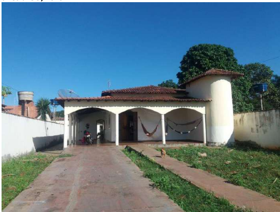
Foto 4.5 – Cobertura de telha de barro, identificada nas habitações da Comunidade Valdemar de Oliveira, Goianésia-GO, 2019.
