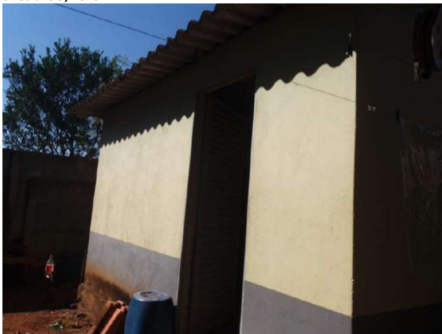
Foto 4.1 – Habitação construída de alvenaria com reboco, identificada na Comunidade Valdemar de Oliveira, Goianésia-GO, 2019.
