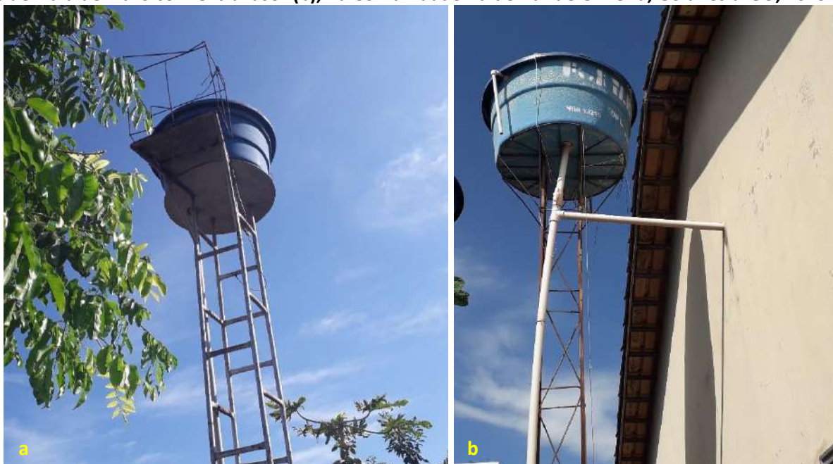
Foto 6.2 – Reservatórios domiciliares instalados sobre estruturas metálicas, sendo de polietileno (a) e de fibra de vidro com extravasor (b), na Comunidade Valdemar de Oliveira, Goianésia-GO, 2019.
