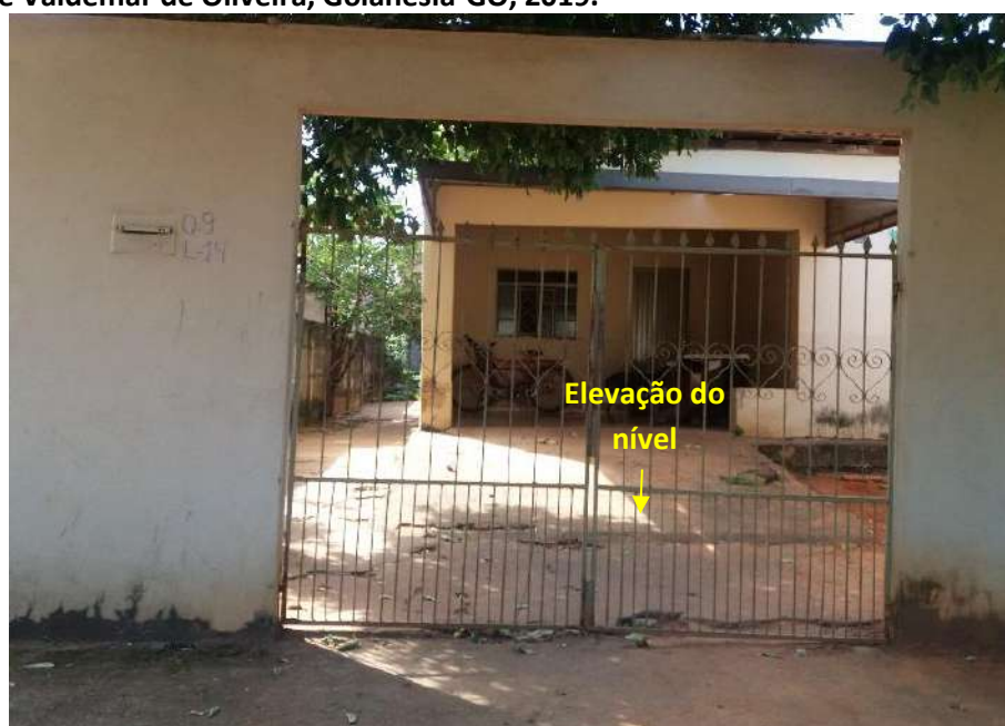
Foto 6.9 – Dispositivo de prevenção dos danos provocados pelas águas em residência da Comunidade Valdemar de Oliveira, Goianésia-GO, 2019.
