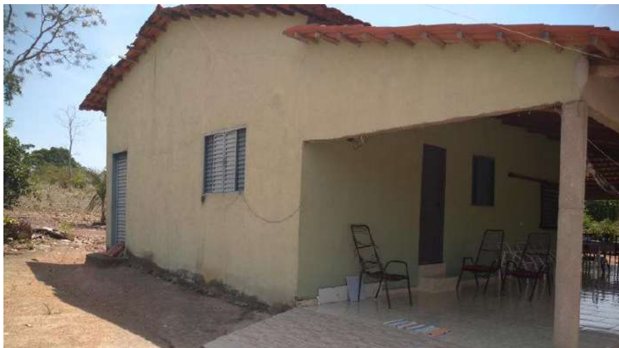
Foto 4.4 – Piso de cerâmica, identificado nas habitações da Comunidade Sebastião Rosa da Paz, Uruaçu-GO, 2018.
