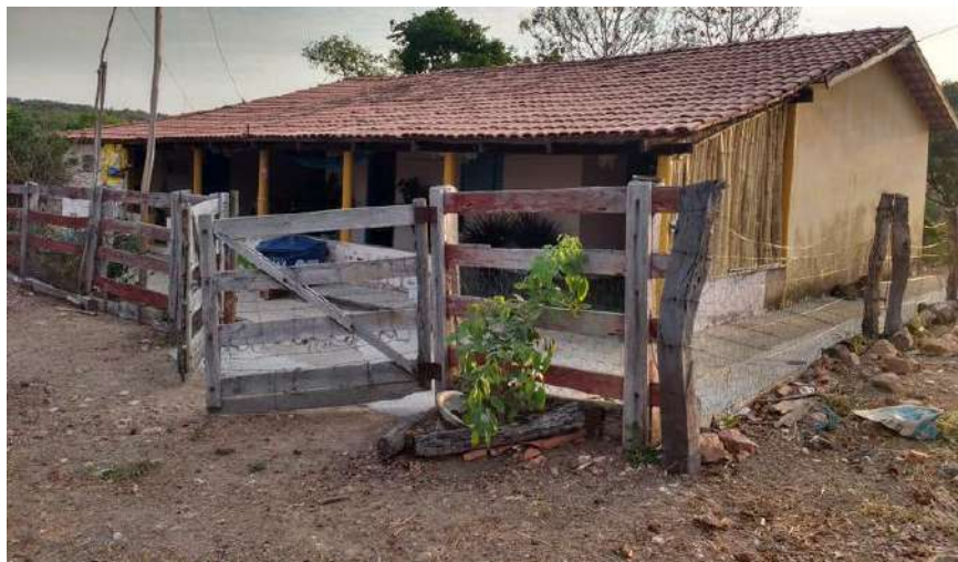
Foto 4.5 – Cobertura de telha de barro, identificada na Comunidade Sebastião Rosa da Paz, Uruaçu-GO, 2018.
