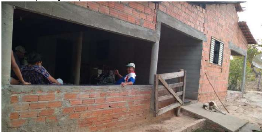
Foto 4.3 – Habitação construída de alvenaria com e sem reboco, identificada na Comunidade Sebastião Rosa da Paz, Uruaçu-GO, 2018.
