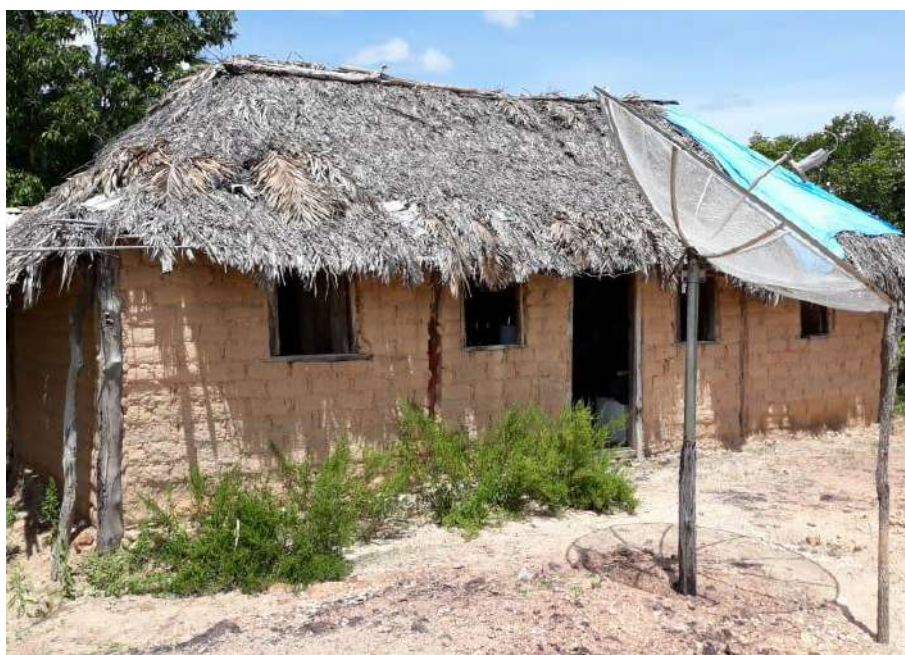
Foto 4.14 – Cobertura de palha, identificada na Comunidade de Pelotas, Monte Alegre de Goiás-GO, 2019.
