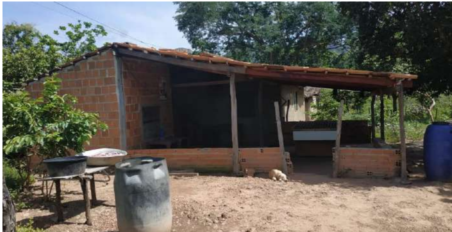
Foto 4.7 – Habitação construída de alvenaria sem reboco, identificada na Comunidade de Pelotas, Monte Alegre de Goiás-GO, 2019.
