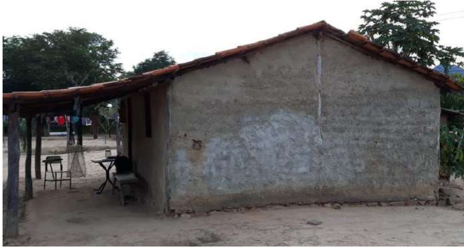
Foto 4.6 – Habitação construída de alvenaria com reboco, identificada na Comunidade de Pelotas, Monte Alegre de Goiás-GO, 2019.
