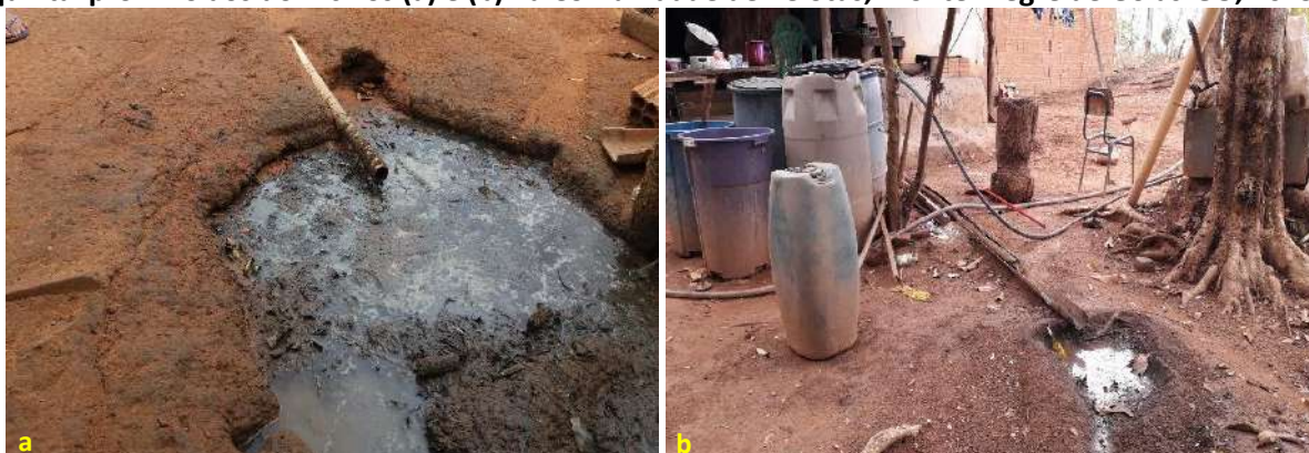
Foto 6.8 – Lançamento e acúmulo de água cinza proveniente da pia da cozinha diretamente no solo do quintal próximo aos domicílios (a) e (b) na Comunidade de Pelotas, Monte Alegre de Goiás-GO, 2019.
