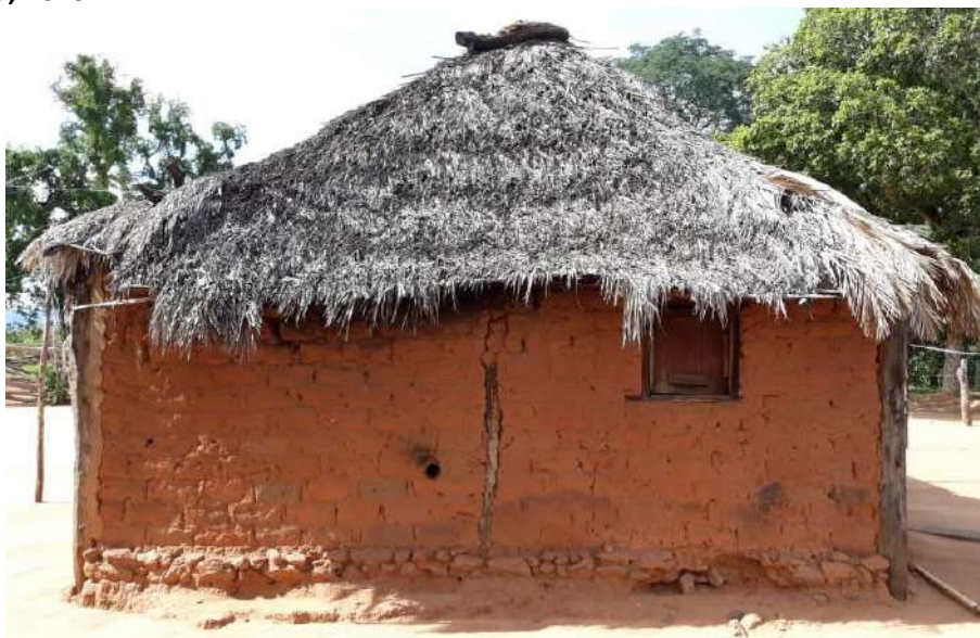
Foto 4.10 – Habitação construída de adobe, identificada na Comunidade de Pelotas, Monte Alegre de Goiás-GO, 2019.
