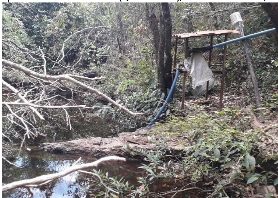
Foto 6.2 – Córrego Queixo Dantas com o conjunto motobomba responsável pela captação d'água do SAA utilizado pela Comunidade de Mimoso (Queixo Dantas), Mimoso de Goiás-GO, 2019.
