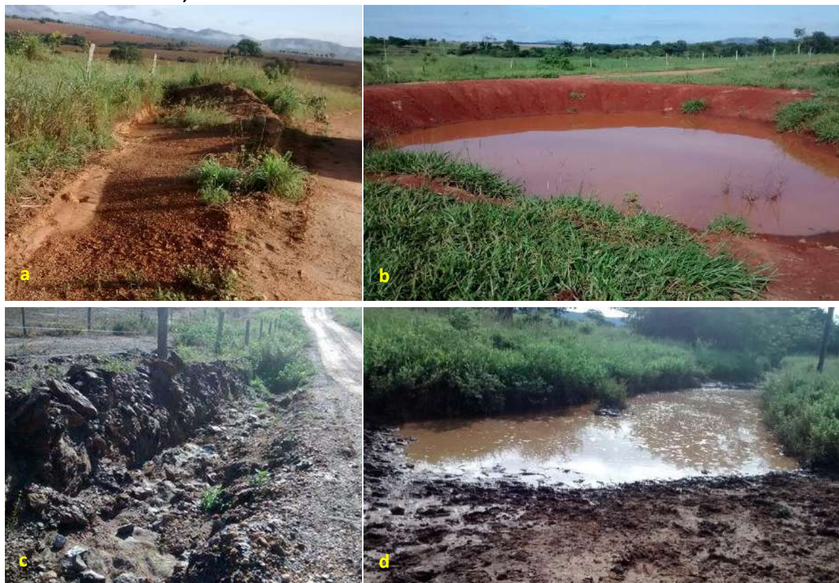
Foto 6.18 – Situação da drenagem pluvial na via de acesso: vala de infiltração (a), bacia de contenção (b), processo erosivo (c) e ponto de alagamento (d), na Comunidade de Mimoso (Queixo Dantas), Mimoso de Goiás-GO, 2019.
