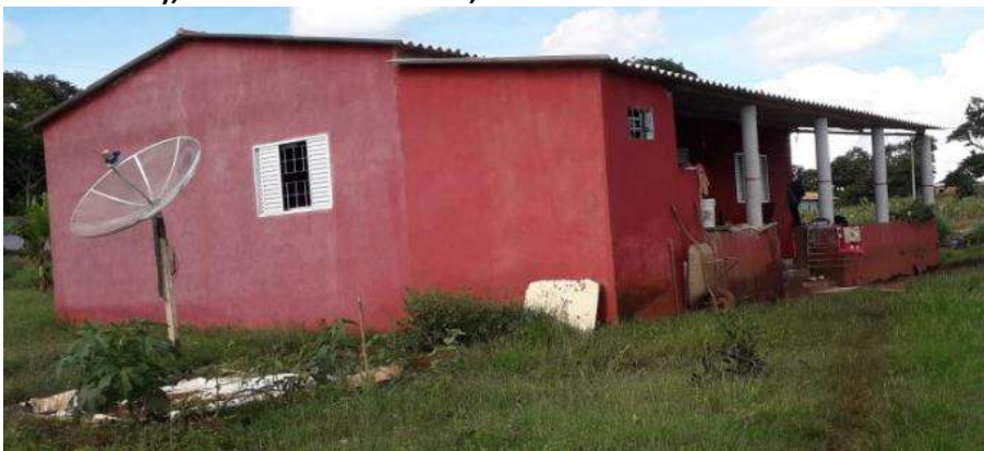
Foto 4.6 – Habitação construída de alvenaria com reboco e pintura, identificada na Comunidade de Mimoso (Queixo Dantas), Mimoso de Goiás-GO, 2019.
