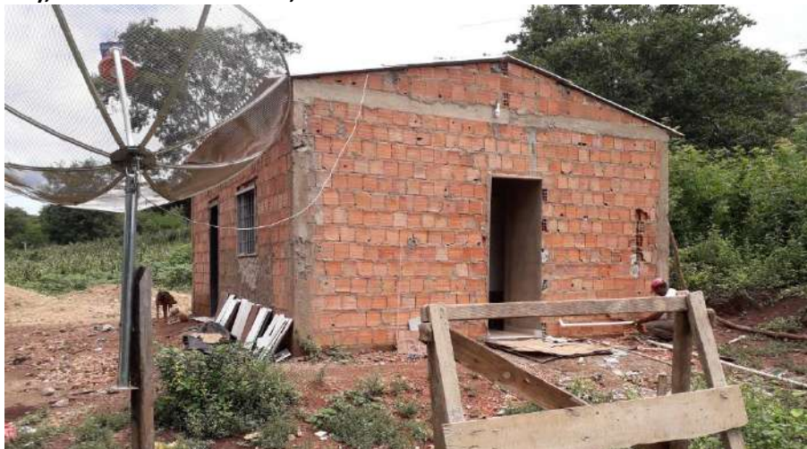
Foto 4.5 – Habitação construída de alvenaria sem reboco, identificada na Comunidade de Mimoso (Queixo Dantas), Mimoso de Goiás-GO, 2019.
