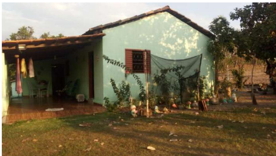
Foto 4.4 – Piso de residência constituído de cerâmica, identificado na Comunidade Limoeiro, Faina-GO, 2018.
