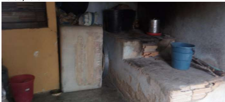
Foto 4.5 – Piso de residência constituído de cimento queimado, identificado na Comunidade Limoeiro, Faina-GO, 2018.
