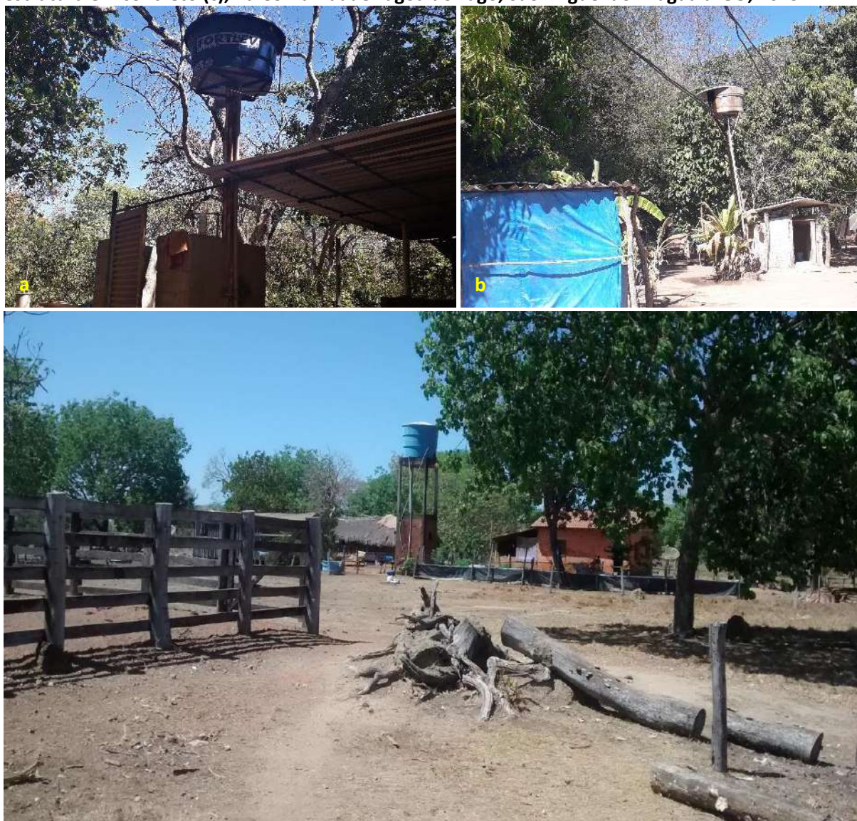
Foto 6.5 – Reservatório domiciliar instalado sobre estrutura metálica (a), madeira (b) e outro sobre estrutura em concreto (c), na Comunidade Lagoa do Lago, São Miguel do Araguaia-GO, 2019.
