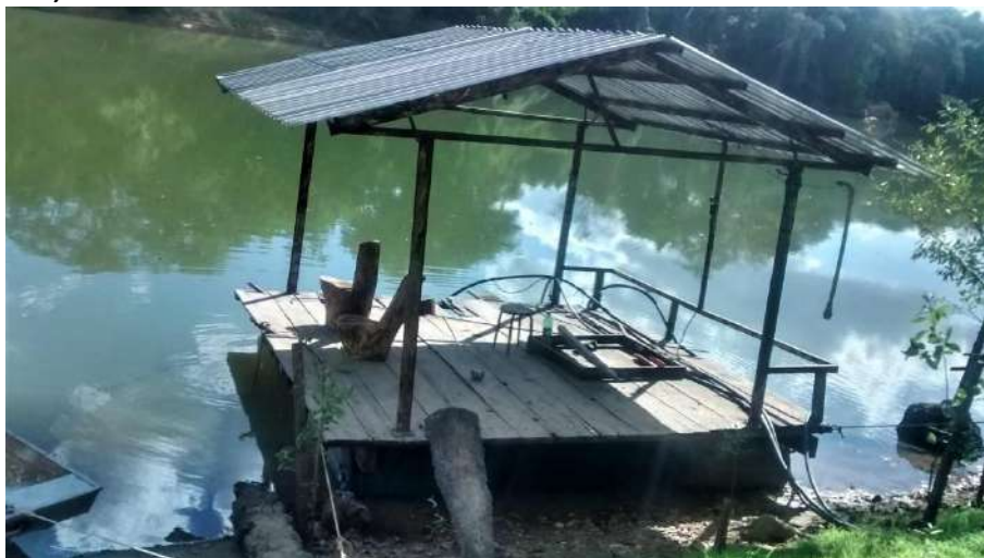
Foto 6.3 – Ponto de captação em manancial superficial, na Comunidade Lagoa do Lago, São Miguel do Araguaia-GO, 2019.
