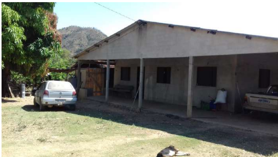
Foto 4.12 – Cobertura de fibrocimento, identificada na Comunidade José Martí, Niquelândia-GO, 2018.
