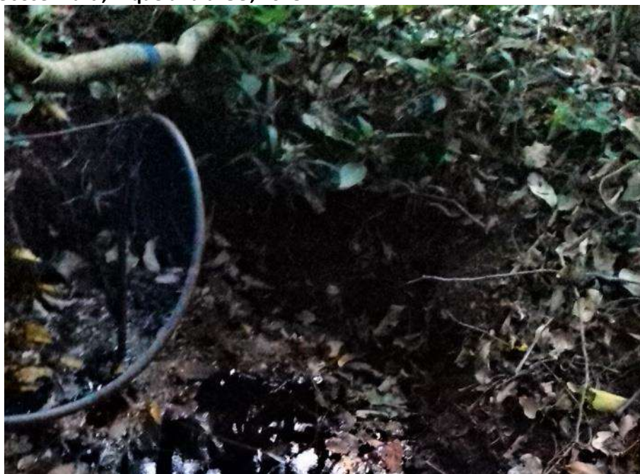
Foto 6.7 – Captação realizada com conjunto motobomba submerso em uma nascente, na Comunidade José Martí, Niquelândia-GO, 2018.
