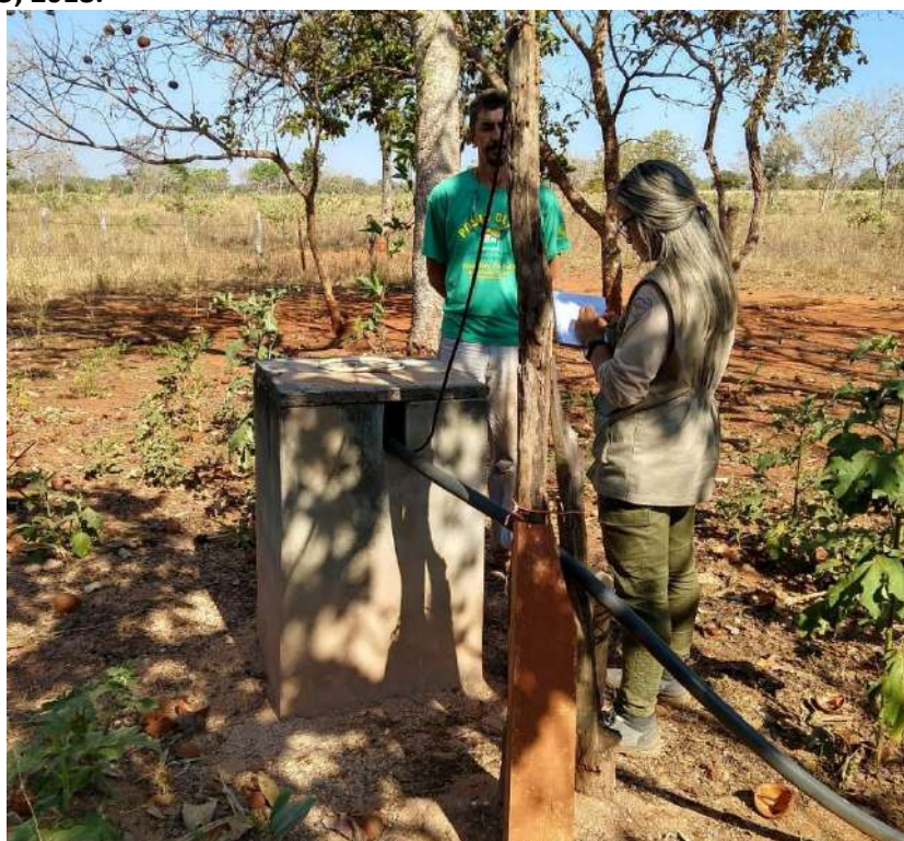
Foto 6.4 – Abrigo em alvenaria de um poço tubular profundo, ná Comunidade José Martí, Niquelândia-GO, 2018.
