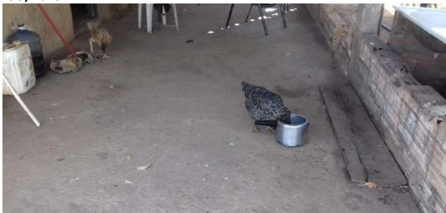
Foto 4.8 – Piso de residência constituído de concreto bruto, identificado na Comunidade José Martí, Niquelândia-GO, 2018.
