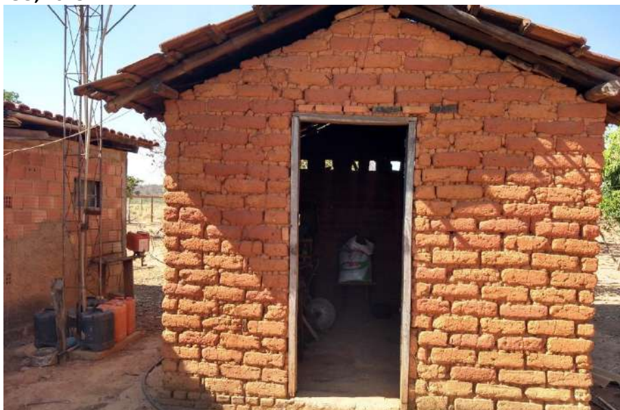
Foto 4.7 – Extensão habitacional construída de adobe, identificada na Comunidade José Martí, Niquelândia-GO, 2018.
