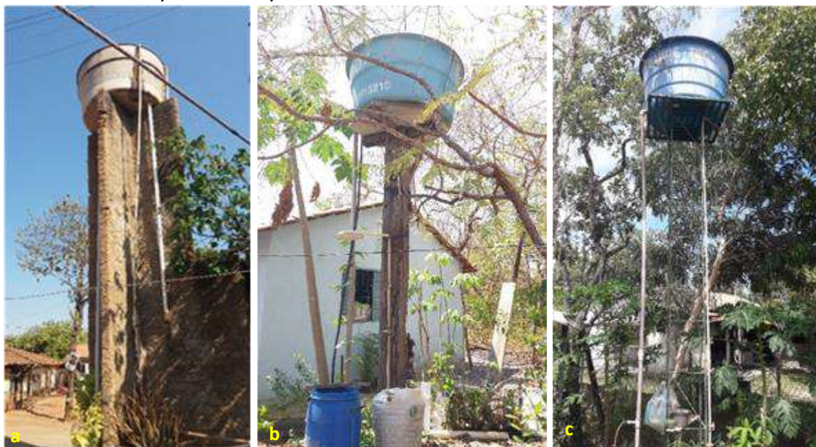
Foto 6.4 – Reservatório de fibrocimento instalado sobre uma estrutura de alvenaria (a), reservatório de fibra de vidro sobre uma estrutura em madeira (b), e outro sobre uma estrutura metálica (c), na Comunidade Itacaiú, Britânia-GO, 2018.
