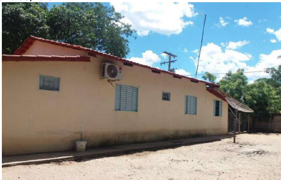
Foto 4.9 – Habitação construída de alvenaria com reboco e pintura, identificada na Comunidade Itacaiú, Britânia-GO, 2018.
