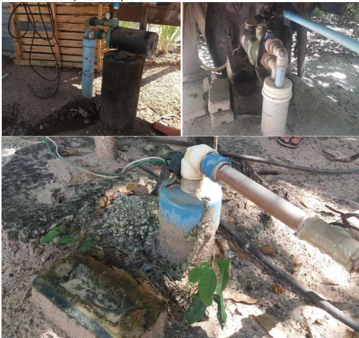
Foto 6.1 – Diferentes poços tubulares rasos utilizados para ingestão de água por algumas famílias da Comunidade Itacaiú, Britânia-GO, 2018.
