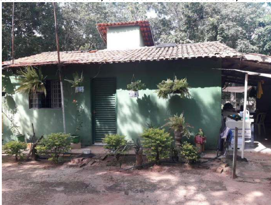
Foto 4.13 – Cobertura de telha de barro, identificada na Comunidade Itacaiú, Britânia-GO, 2018.
