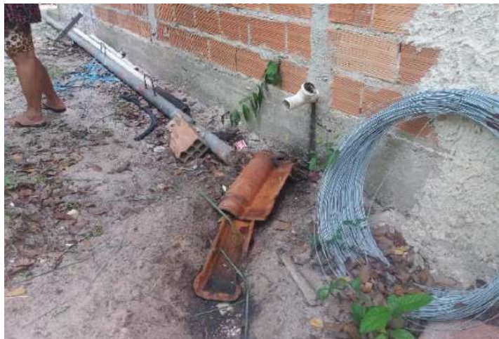
Foto 6.6 – Lançamento e acúmulo de água cinza proveniente da pia da cozinha e/ou do tanque de lavar roupas diretamente no solo do quintal próximo aos domicílios, na Comunidade Itacaiú, Britânia-GO, 2018.
