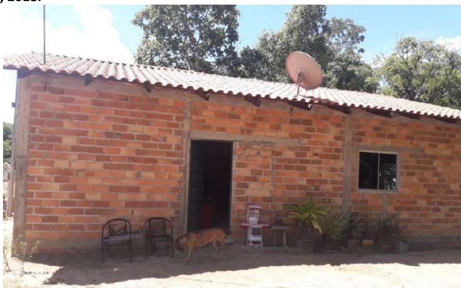
Foto 4.10 – Habitação construída de alvenaria sem reboco, identificada na Comunidade Itacaiú, Britânia-GO, 2018.
