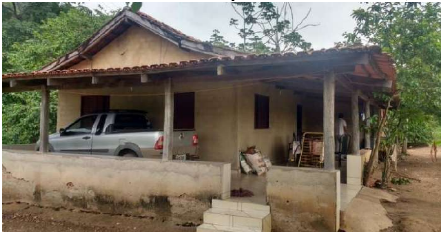
Foto 4.8 – Piso de cerâmica, identificado nas habitações da Comunidade Céu Azul, Minaçu-GO, 2018.
