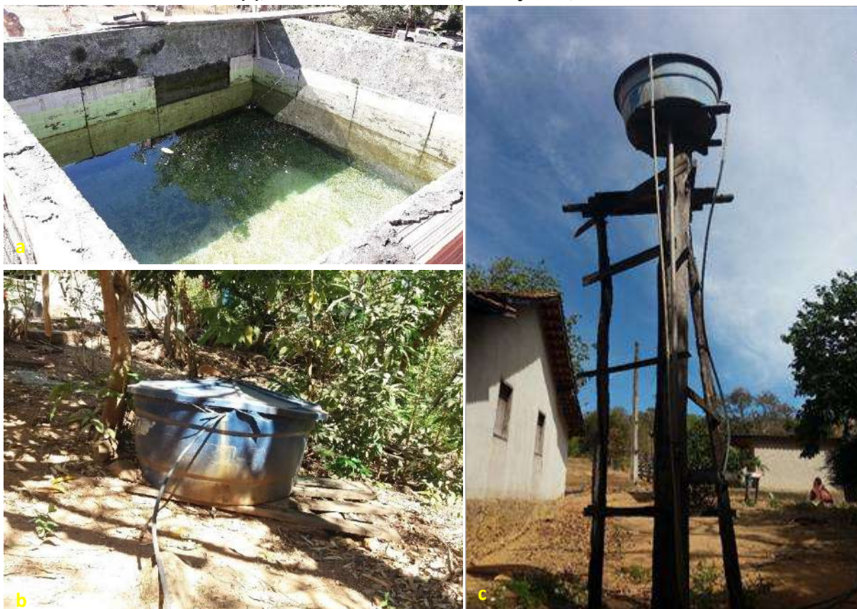
Foto 6.7 – Reservatório construído em alvenaria (a), em polietileno instalado no solo (b) e outro sobre estrutura de madeira(c), Comunidade Céu Azul, Minaçu-GO, 2018.
