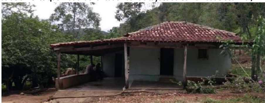
Foto 4.7 – Piso de cimento queimado identificado nas habitações da Comunidade Céu Azul, Minaçu-GO, 2018.
