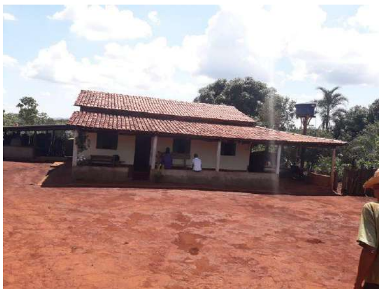
Foto 4.6 – Cobertura de telha de barro, identificada na Comunidade Conceição, Niquelândia-GO, 2018.
