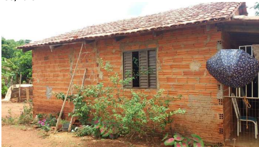
Foto 4.3 – Habitação construída de alvenaria sem reboco, identificada na Comunidade Conceição, Niquelândia-GO, 2018.
