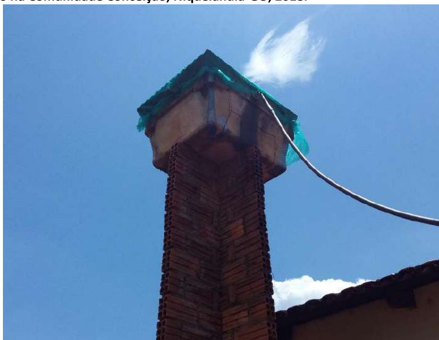
Foto 6.4 – Reservatório domiciliar com tampa fixada de forma improvisada com tela e telha de fibrocimento na Comunidade Conceição, Niquelândia-GO, 2018.
