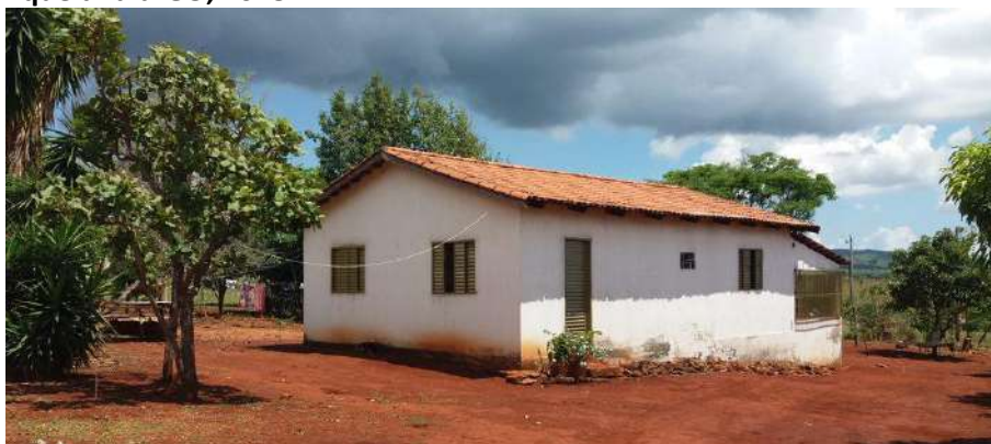
Foto 4.5 – Habitação construída de alvenaria com reboco e pintura, identificada na Comunidade Conceição, Niquelândia-GO, 2018.
