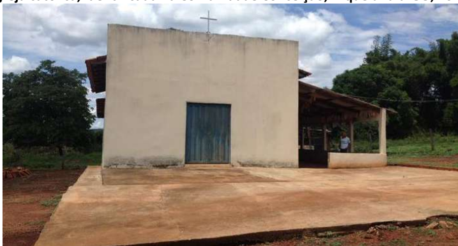
Foto 4.1 – Igreja católica, identificada na Comunidade Conceição, Niquelândia-GO, 2018.
