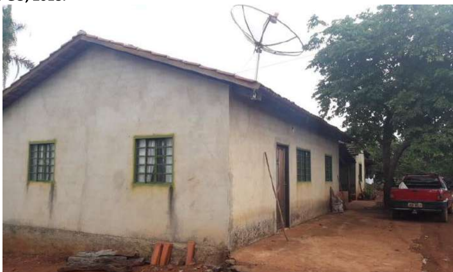
Foto 4.4 – Habitação construída de alvenaria com reboco, identificada na Comunidade Conceição, Niquelândia-GO, 2018.
