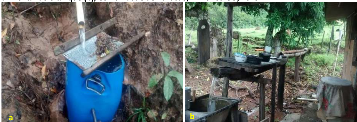
Foto 6.3 – Suprimento de água realizado por meio de bica com gradeamento improvisado (a) e outra alimentando o tanque (b), Comunidade de Buracão, Mineiros-GO, 2019.
