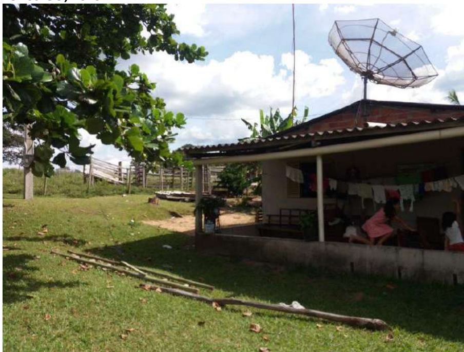
Foto 4.2 – Habitação construída de alvenaria com e sem reboco, identificada na Comunidade de Buracão, Mineiros-GO, 2019.
