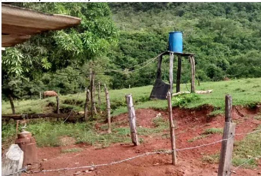
Foto 6.5 – Reservatório improvisado do tipo bombona instalado sobre estrutura de madeira, Comunidade de Buracão, Mineiros-GO, 2019.
