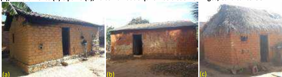
Foto 68.1 – Diferentes coberturas encontradas nas comunidades rurais e tradicionais: telha cerâmica (a), fibro-cimento (b) e palha (a), na comunidade quilombola São Domingos, Cavalcante-GO.
