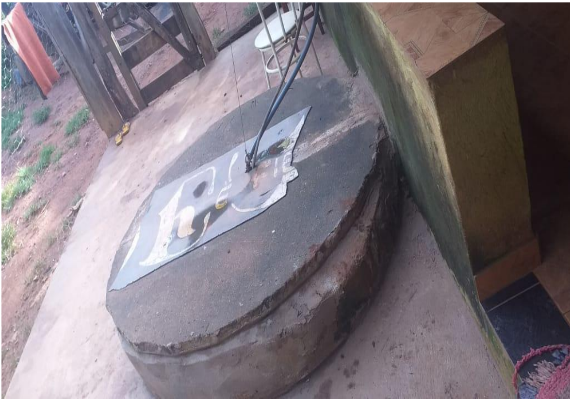
FIGURA 2: Poço de captação de água. FONTE: Os autores (2020).
